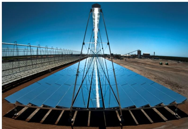
Figura 4.17: Collettore Fresnel
