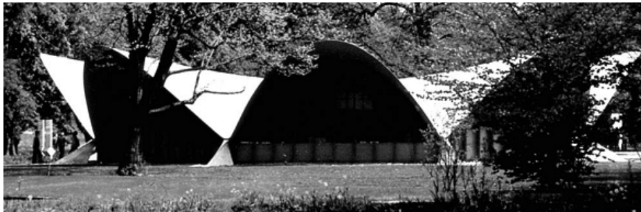
Figura 4.22: Esempio di copertura in TRC
