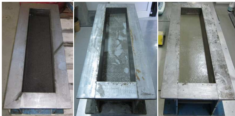
Figura 9.1: Fasi di getto dello strato di TRC sulla lastra di Foamglas ® nel cassero UNI
