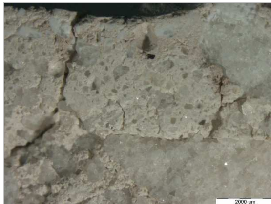
Figura 6.31 Presenza di fessure lungo i bordi
