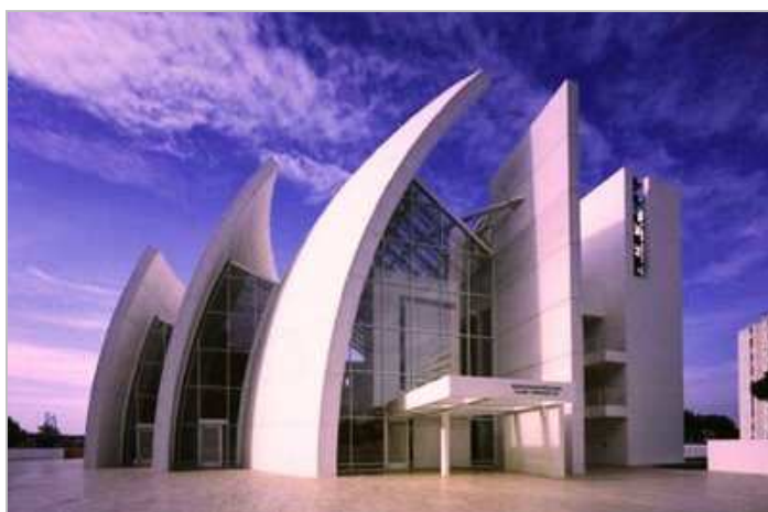
Figura 1.1 Vista frontale chiesa "Dives in misericordia"
