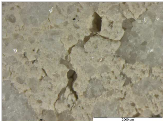
Figura 6.30 Fessurazione profonda e lunga nella pasta di cemento
