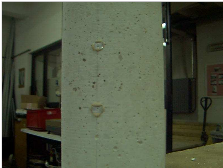
Figura 4.50 Applicazione delle placche metalliche
