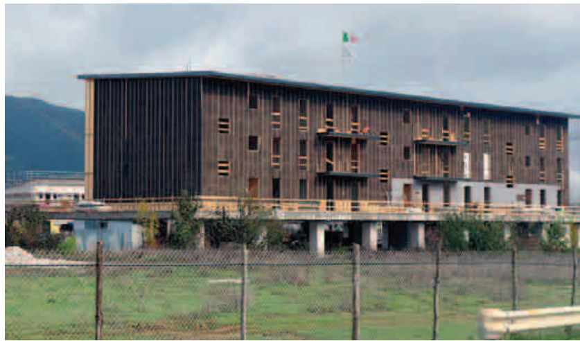
27. Edificio per progetto C.A.S.E., ORCEANA costruzioni, (sotto)
