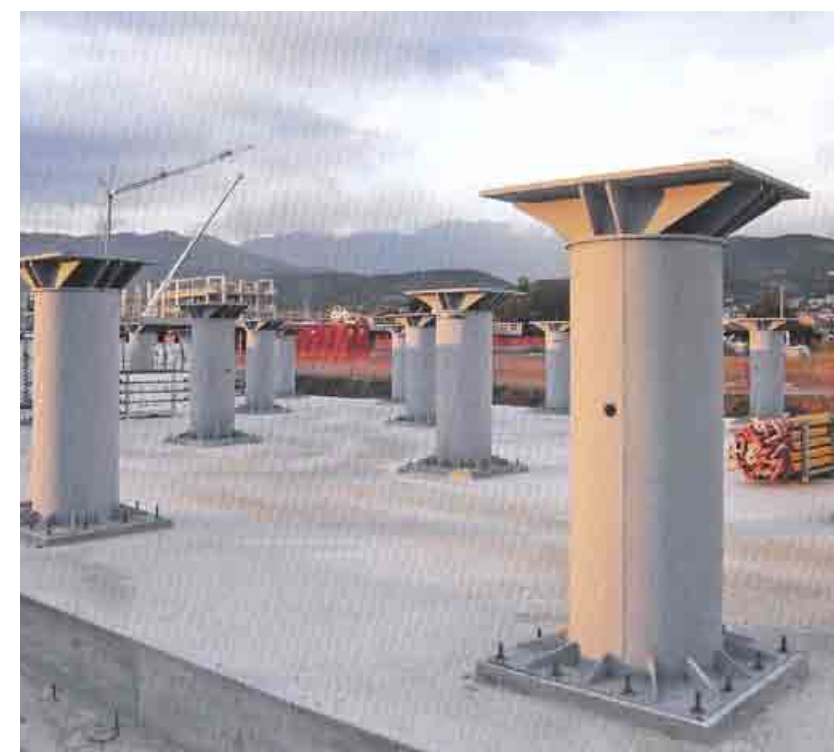
24. Colonne posate ed inghisaggi alla base.
