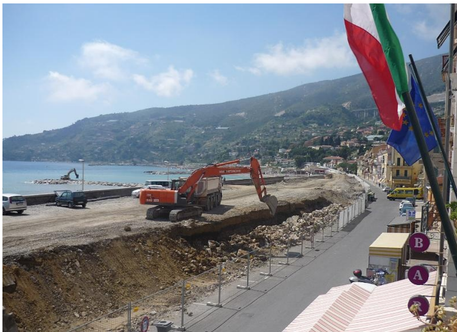
Figura 35: I lavori di demolizione del rilevato ferroviario ad opera della Fin.Im. (fonte Comune di Ospedaletti)
