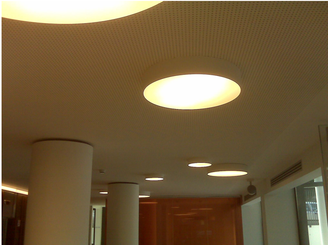
Foto della hall. Fonte: scatto dell'autore
