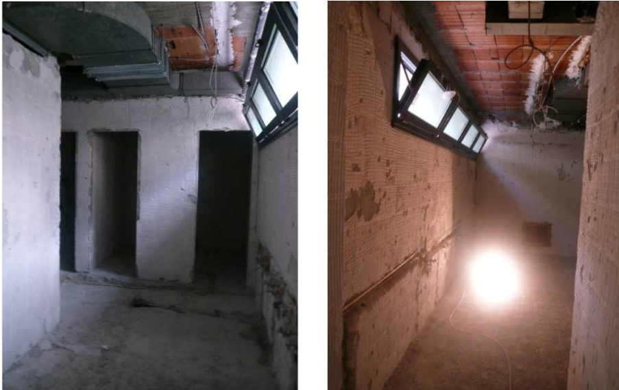
Foto dei locali adibiti ai servizi prima dell'intervento. Fonte: Generali Gestione Immobiliare
