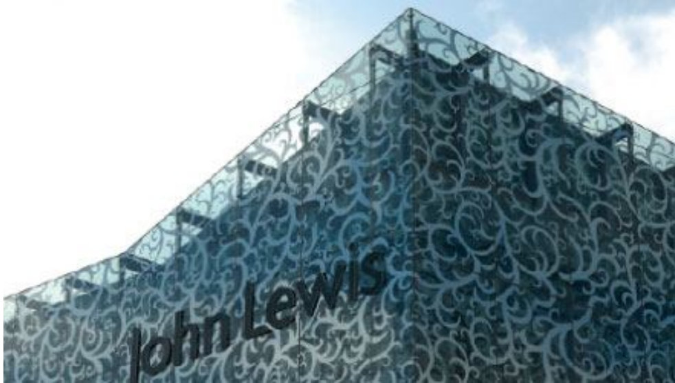
Veduta di facciata del John Lewis Department Store, a Leicester. Fonte: www.theplan.it
