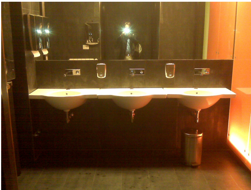
Foto dei locali adibiti ai servizi dopo l'intervento. Fonte: scatto dell'autore
