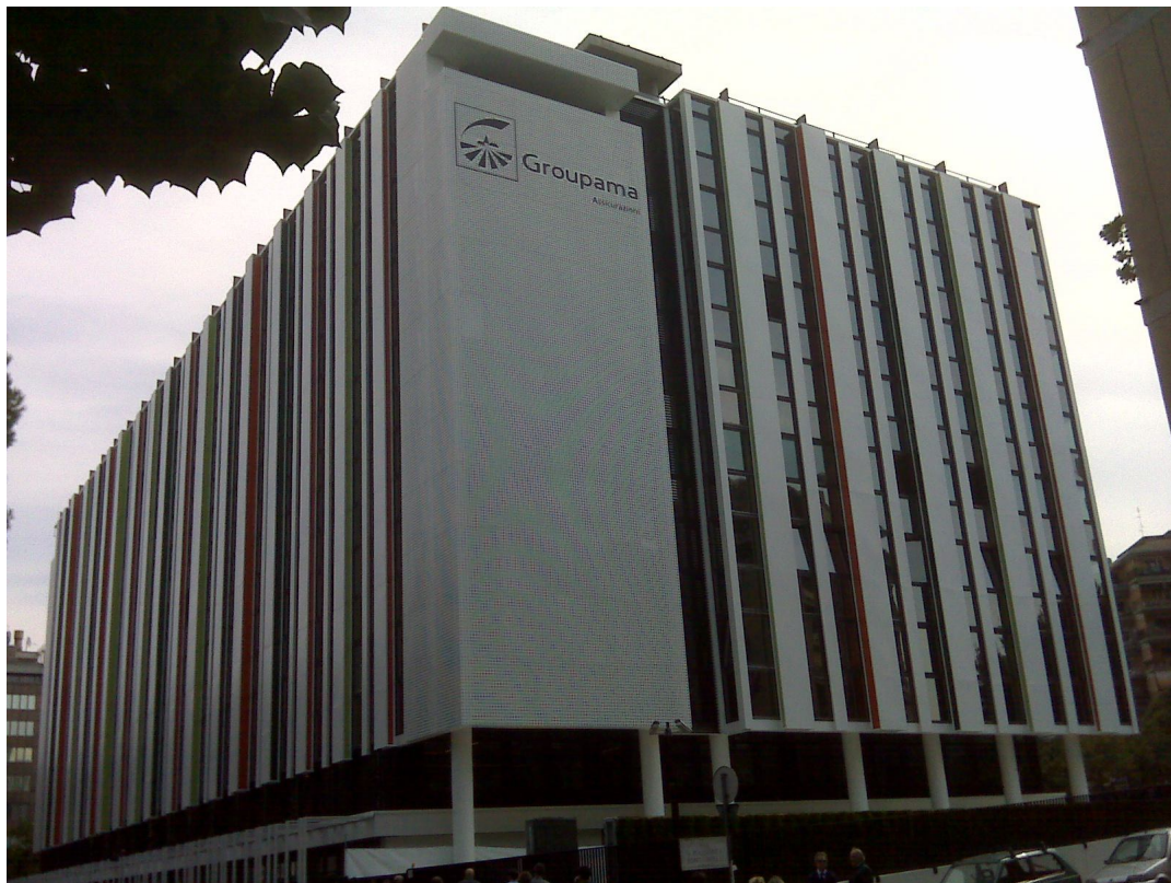
Vista panoramica dell'edificio di Generali, Via Cesare Pavese 385. Fonte: scatto dell'autore
