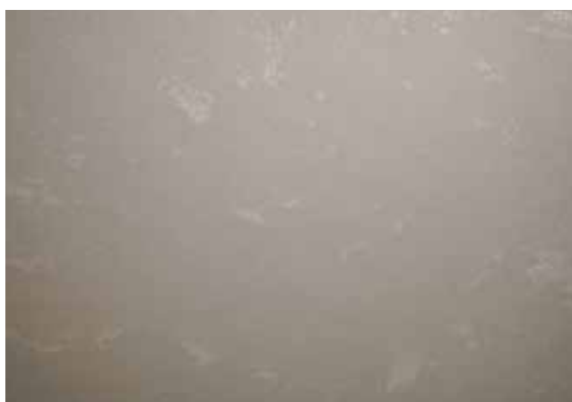
Fig.7.30 Macchie bianche disperse su tutta la superficie
