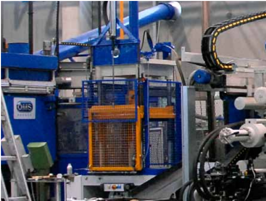
Fig. 7.17 Tranciatrice automatica posizionata accanto ad ogni stazione di pressofusione.
