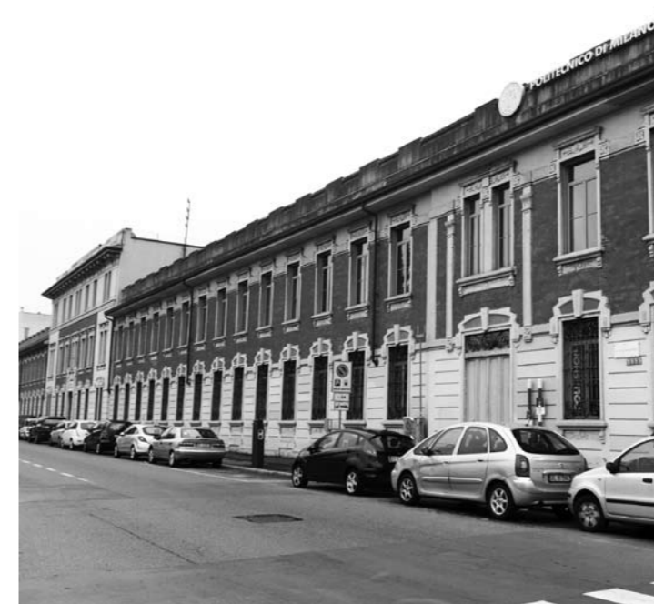
28. Facciata del Politecnico lungo via Durando
