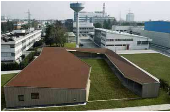
Fig.26_ Veduta generale con la corte interna
