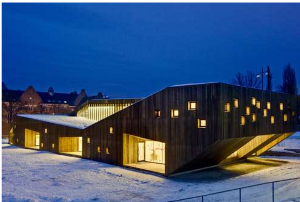
Fig.44_ Vista dell'asilo dall'alto
