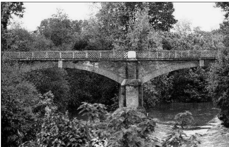
Fig.62_ Foto del Ponte, prima della ristrutturazione.
