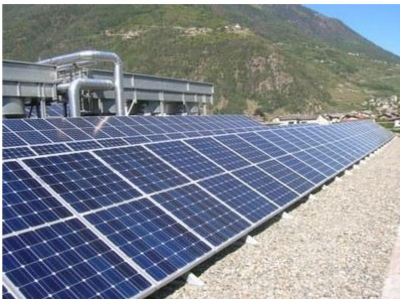
Fig. 36: Esempio di pannelli fotovoltaici al silicio monocristallino
