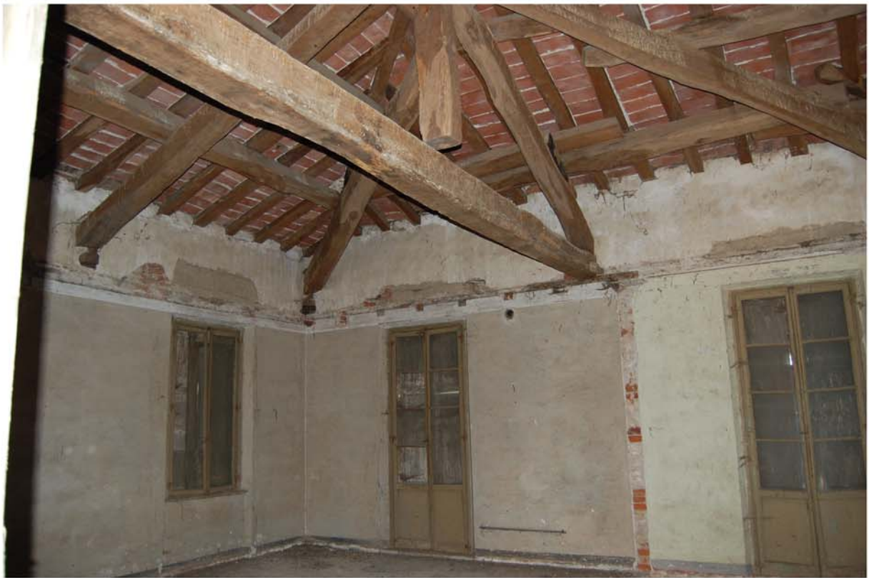
Ultimo solaio della torre Castellana: sono visibili le tracce dei tramezzi che lo dividevano in locali per la servitù.
