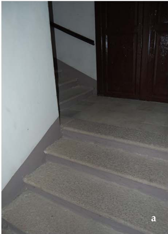
Fig. 3.16 Pedate in granito della scala principale (a); pavimento in seminato alla veneziana della sala Verde (b).
