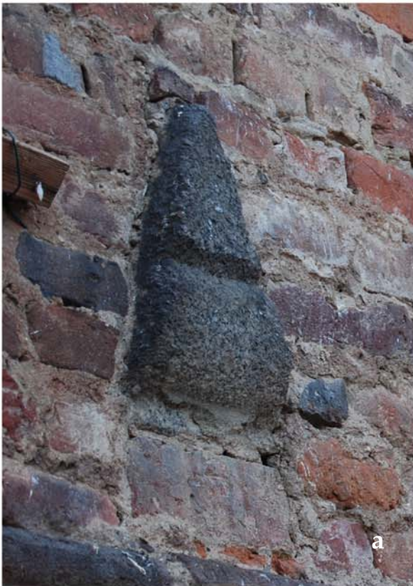
Fig. 3.15 Elemento lapideo in granodiorite (Ghiandone) inserito nella zona di cerniera del ponte levatoio (a); parapetto in granito del balcone sul lato Ovest della torre de Gnocchi (b).
