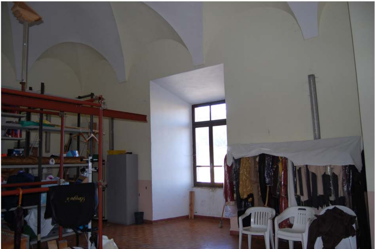
Sala al secondo piano della torre Castellana: vista verso Sud-Ovest; pavimento moderno in quadrotti di legno, attualmente adibita a magazzino costumi.
