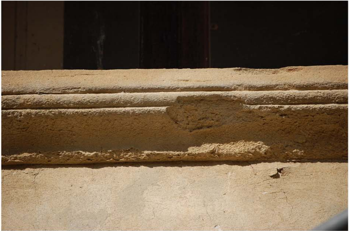
Fig. 4.3 Davanzale di finestra sul lato Est, in arenaria (pietra molera) in avanzato stato di alterazione per disgregazione e esfoliazione.
