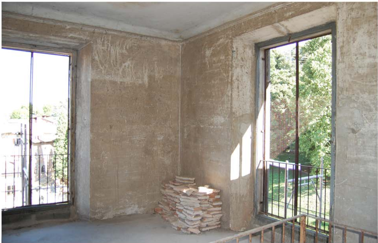
Lato Sud-Est della terrazza.
