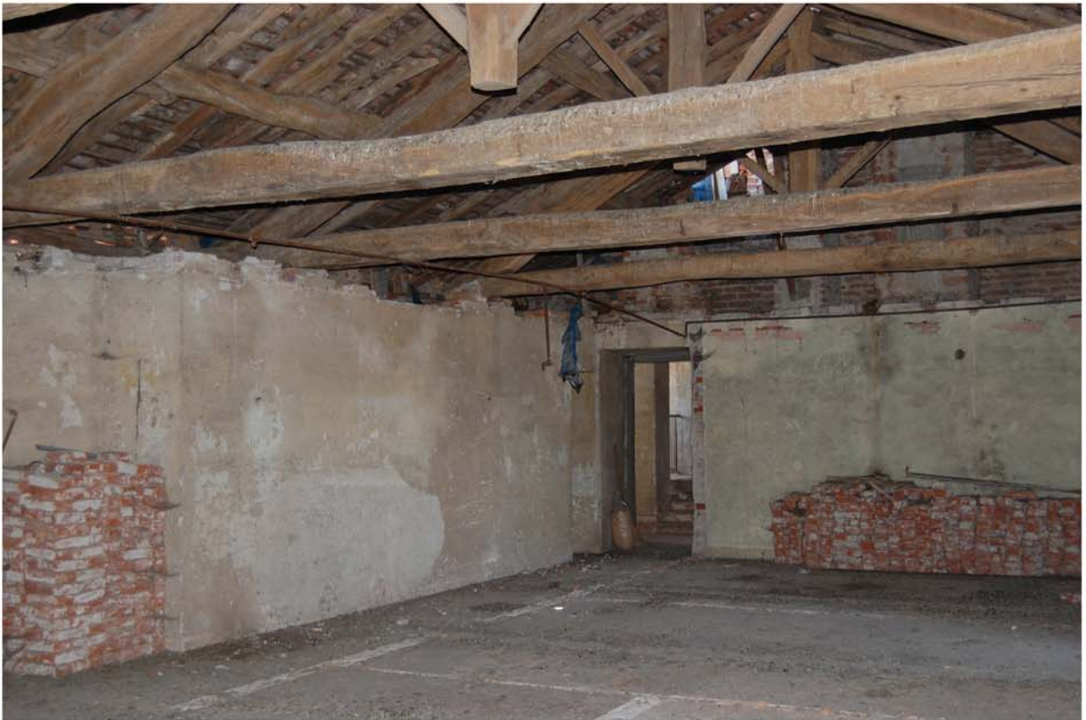
Solaio della torre de Gnocchi dopo la demolizione dei tramezzi degli appartamenti della servitù della famiglia Belgioioso.
