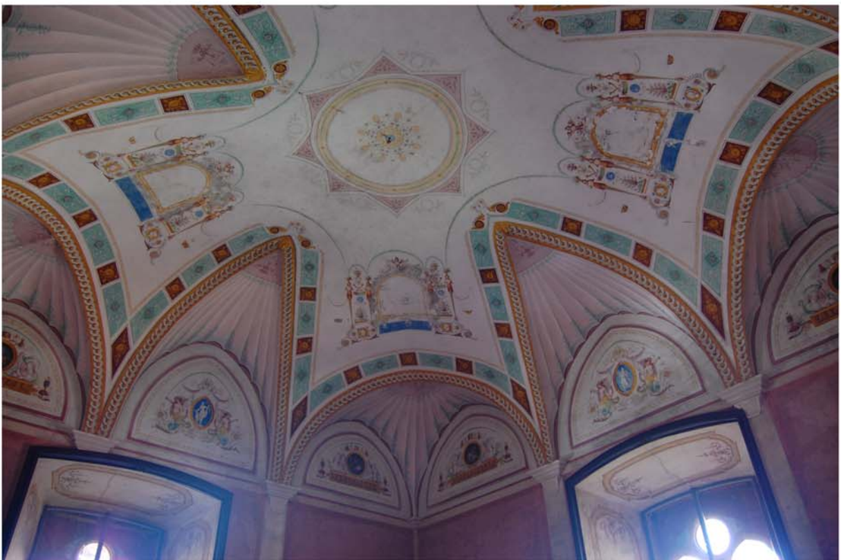
Sala rosa: soffitto a volta a padiglione con unghie.
