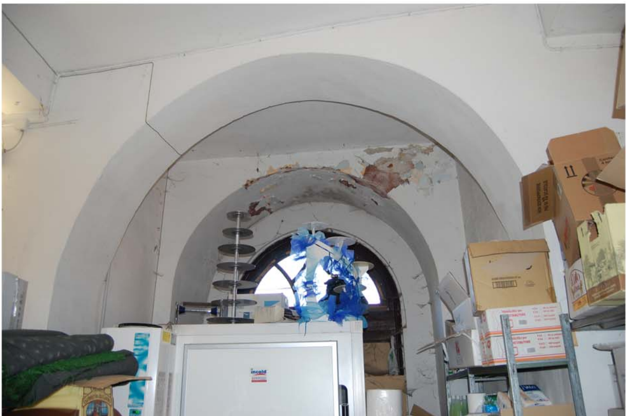
Locale lato Sud: particolare delle aperture ad arco verso Ovest.
