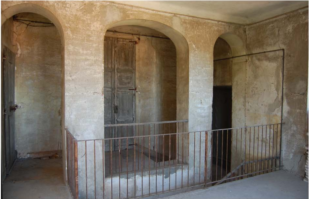
Terrazza alla fine della scala con gli accessi da sinistra verso destra: al balcone in legno che conduce al camminamento in cima alla torre Castellana, al solaio della stessa e al solaio della torre de Gnocchi.
