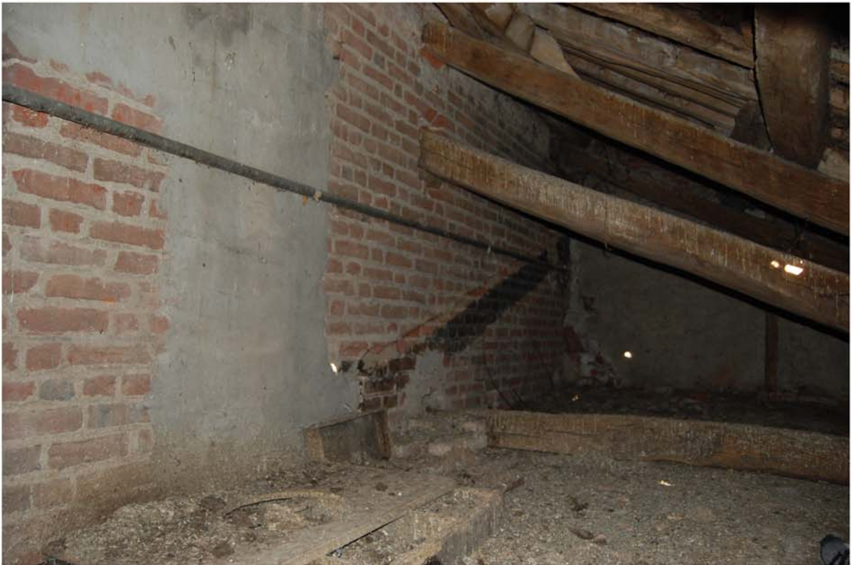
Sottotetto sovrastante l'ex-appartamento del parroco adiacente alle sale beige e rosa ; sul fondo il muro di separazione con il bagno.
