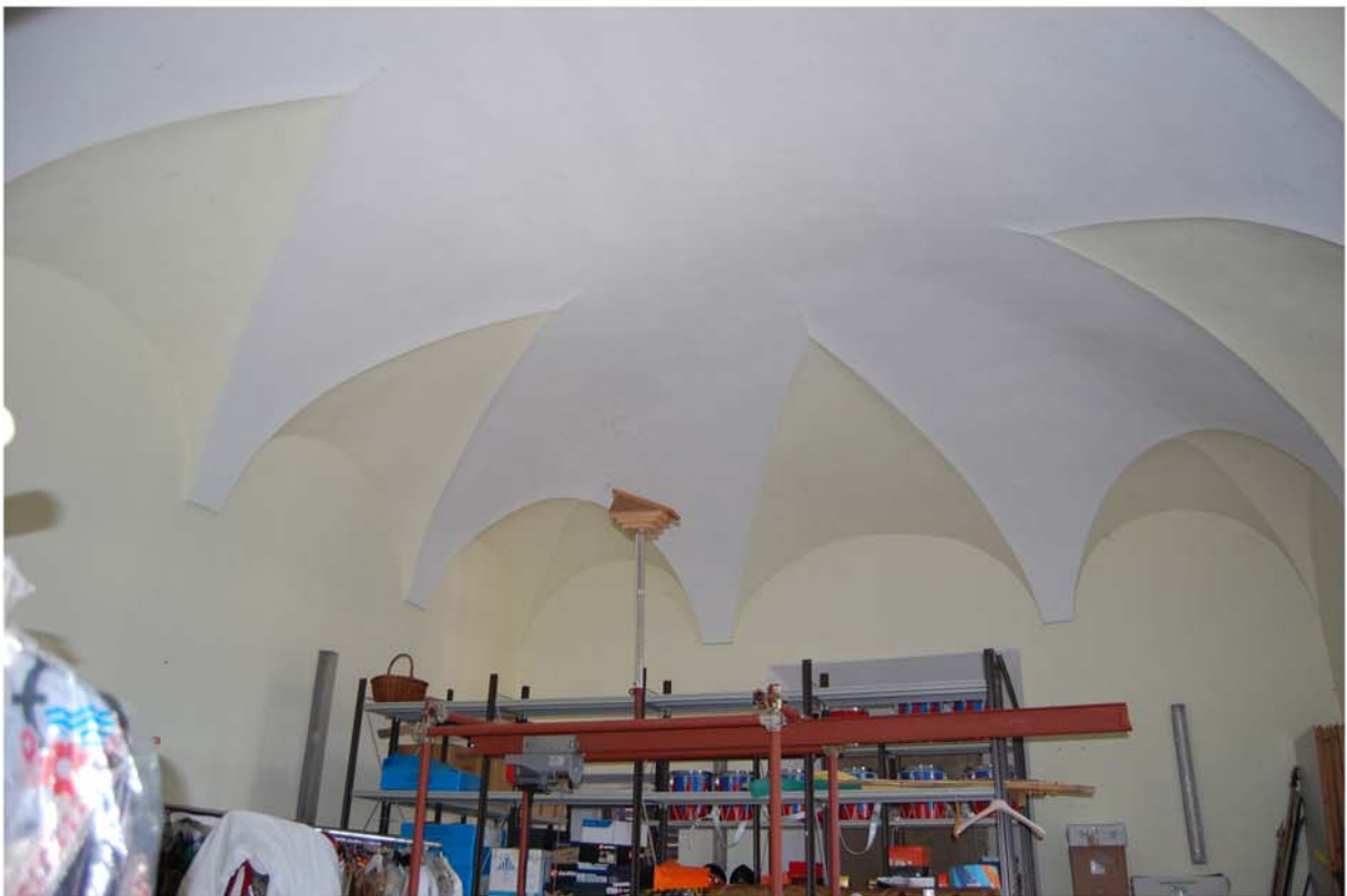
Sala al secondo piano della torre Castellana: vista del soffitto.
