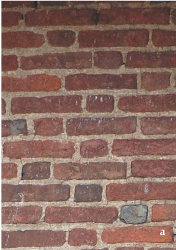
Fig. 3.14 Muratura in laterizi con apparecchiatura alla senese (a); elemento lapideo in Ceppo inserito come mensola a sostegno dell'apertura del ponte levatoio (b).
