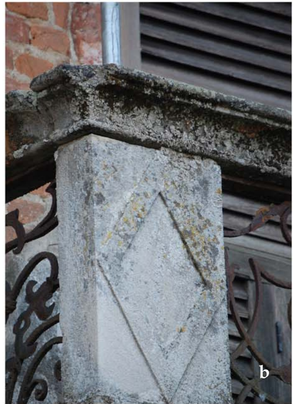
Fig. 3.15 Elemento lapideo in granodiorite (Ghiandone) inserito nella zona di cerniera del ponte levatoio (a); parapetto in granito del balcone sul lato Ovest della torre de Gnocchi (b).
