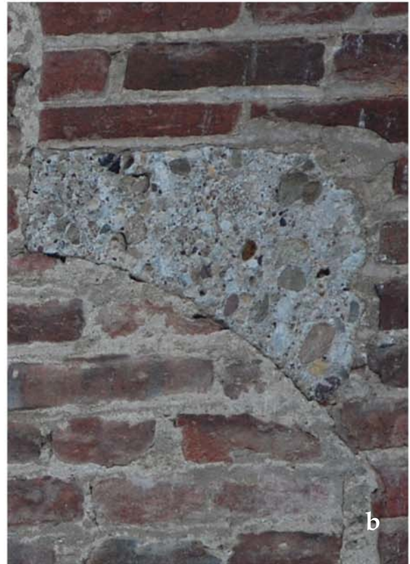
Fig. 3.14 Muratura in laterizi con apparecchiatura alla senese (a); elemento lapideo in Ceppo inserito come mensola a sostegno dell'apertura del ponte levatoio (b).
