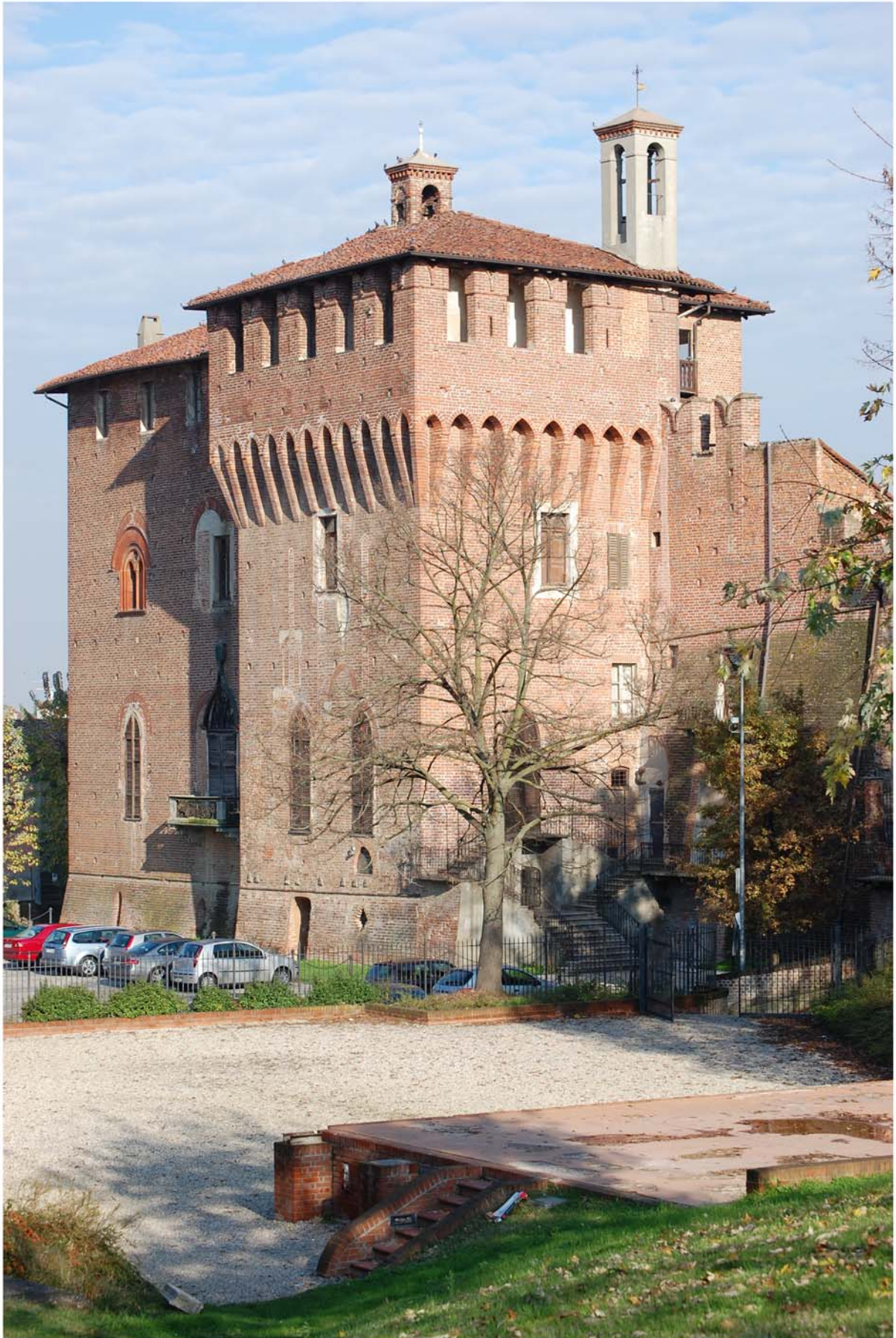
Fig. 3.1 La torre Castellana e la torre de Gnocchi viste da Sud-Ovest.
