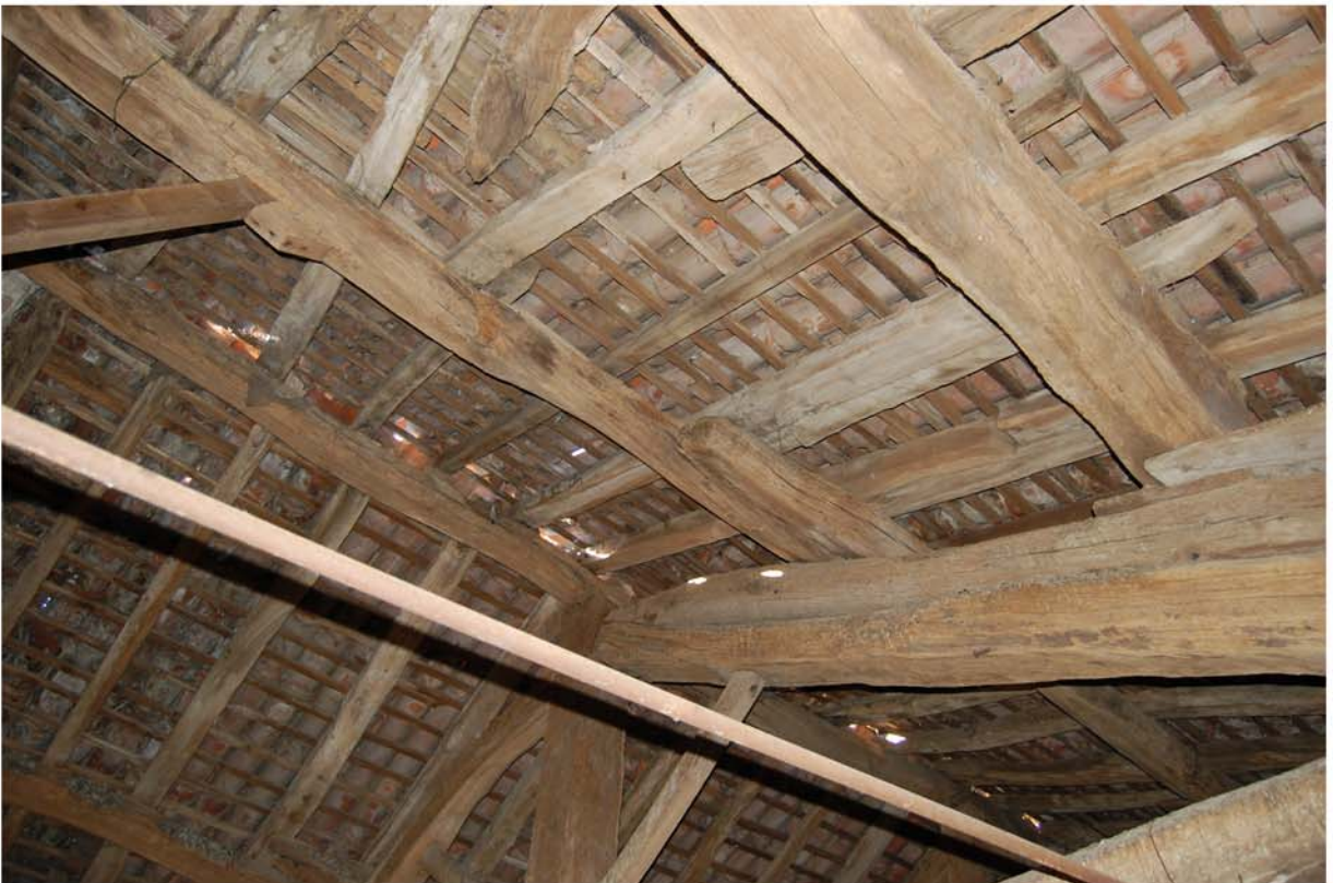
Orditura in legno del tetto della torre de Gnocchi.
