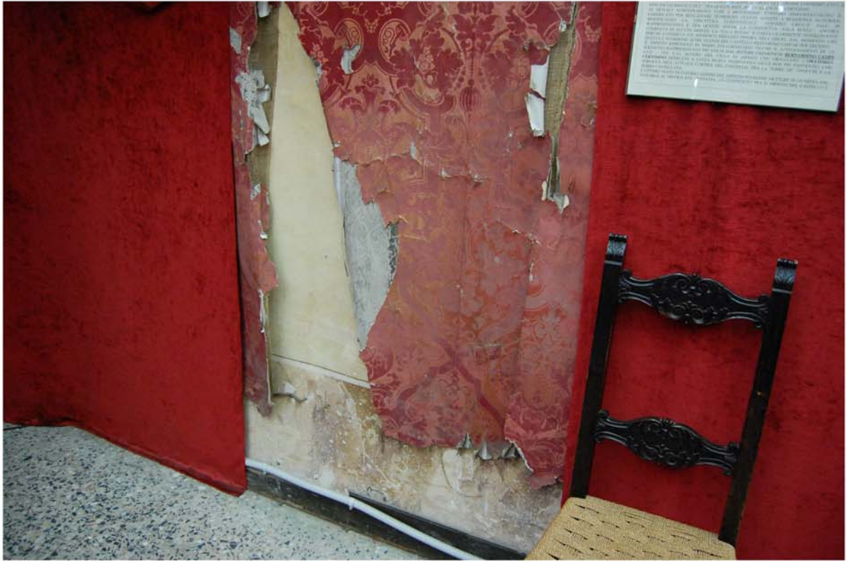
Fig. 4.5 Tappezzeria lacerata e con ampie lacune della sala Rossa; si nota la precedente decorazione delle pareti color beige, la successiva tappezzeria color grigio a sua volta ricoperta da quella rossa.
