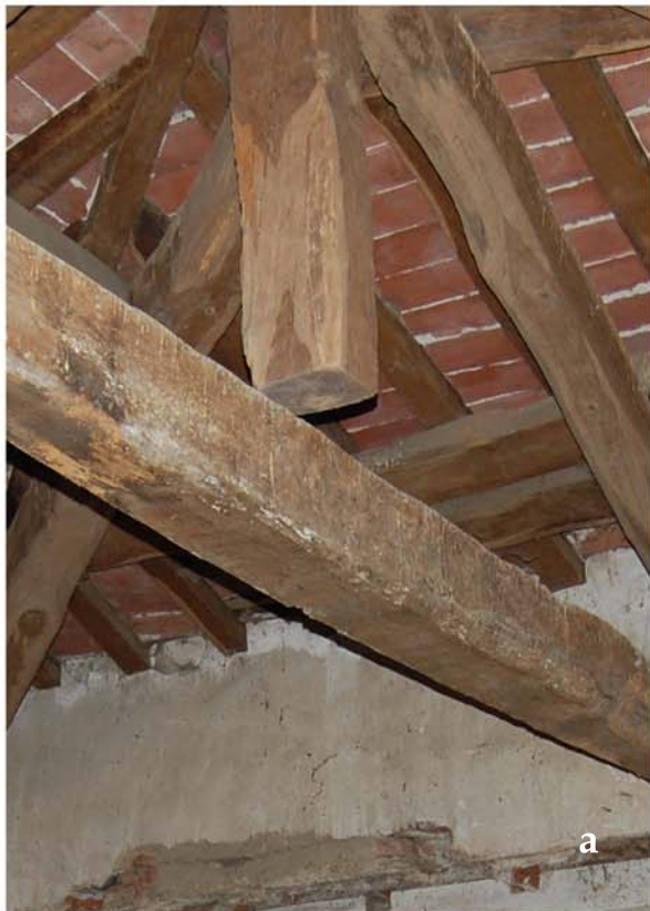
Fig. 3.17 Orditura lignea della copertura della torre Castellana (a); soffitto in legno decorato dell'antisala al piano terra (b).
