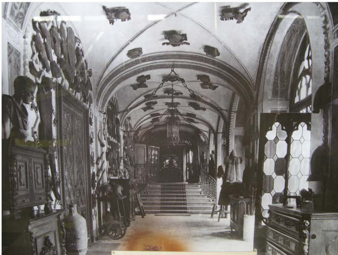
Fig. 2.8 La galleria d'armi in una foto del 1951. (riproduzione conservata nel castello)
