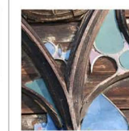
Velro in lastre da colorato ad incolore. Utilizzato sia nelle chiusure (ante) che negli elementi fissi delle finestre.
