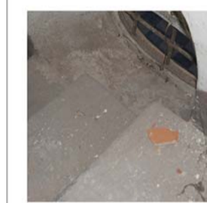
10 Scala in lastre di gneiss rifinito grezzo.
