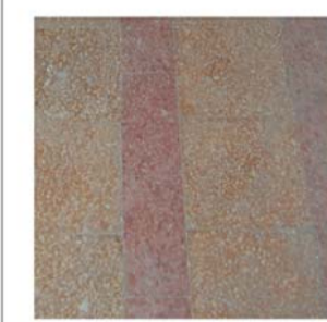
7 Pavimento in piastrelle in seminato con differenti colorazioni e motivi geometrici nelle diverse stanze.
