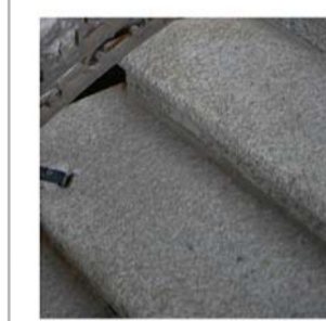
9 Scala in granito scabellato grezzo con gradino in unico blocco.
