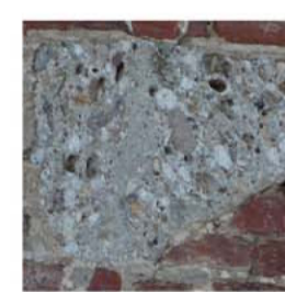
Elemento lapideo in conglomerato ad elementi poligenici denominato "Ceppo Lombardo". Zona di estrazione lungo i corsi dei fiumi Lambro e Adda nell'alta pianura lombarda. Elementi strutturali particolarmente sollecitati da parti in movimento.
