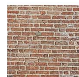
Muratura portante in laterizi con disposizione alla senese
