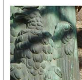
Elemento in bronzo utilizzato nella decorazione della finestra. Alterazione bruno verdstra dovuta ad ossidazione.
