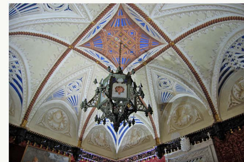
VOLTA A PADIGLIONE CON UNGHIE NELLA SALA ROSSA
