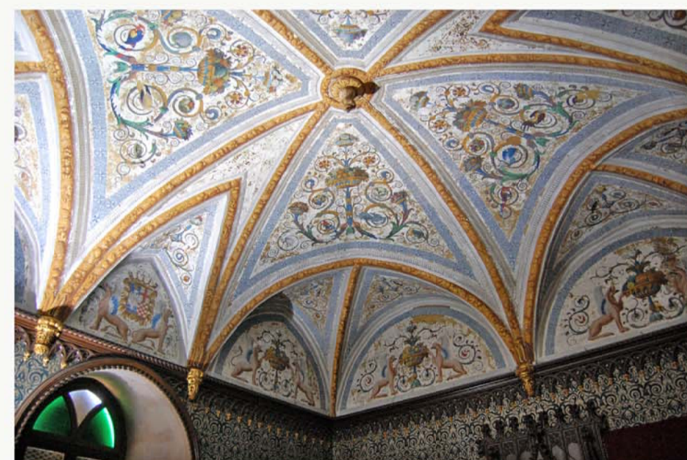
VOLTA A PADIGLIONE CON UNGHIE NELLA SALA AZZURRA
