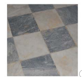
1 Pavimento in marmo grigio e bianco a scacchiera, dimensioni delle piastrelle 29,3 x 29,3 cm.
