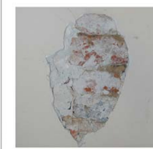
14 Intonaco realizzato con malta a base di calce ricoprente un muro di età carsina con mattoni in laterizio e giunti in argilla cruda.
