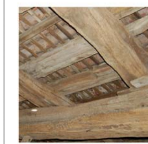
19 Legno dell'orditura del tetto.
