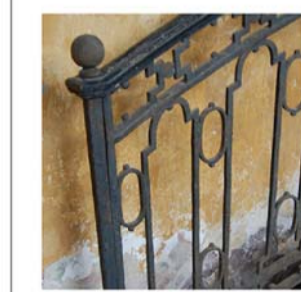
18 Ferro battuto della ringhiera dello scalone nella galleria d'armi.
