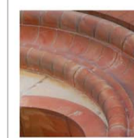
Cornici delle finestre in cotto
