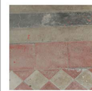
6 Pavimento in cemento colorato in rosso, grigio scuro e grigio chiaro.
