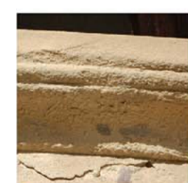
Elemento lapideo in arenaria fine tipo "Pietra Molera" probabilmente proveniente dai flysch cretaci affioranti in Brianza. Colorazione giallo-ocra dovuta ad alterazione. Utilizzato per i davanzali delle finestre e stipiti di porte.
