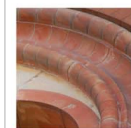
Cornici delle finestre in cotto
