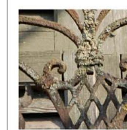
Ringhiere di balconi e scalinate in ferro battuto con ricche decorazioni. Interessate da profonda corrosione (ruggine).
