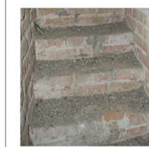
8 Scala in mattoni disposti di piatto e stilati con malta di calce.
