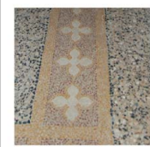
3 Pavimento in seminato con decorazioni.
