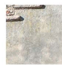
Intonaco esterno realizzato con malta a base di cemento Portland
