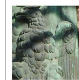
Elemento in bronzo utilizzato nella decorazione della finestra. Alterazione bruno verdastro dovuta ad ossidazione.
