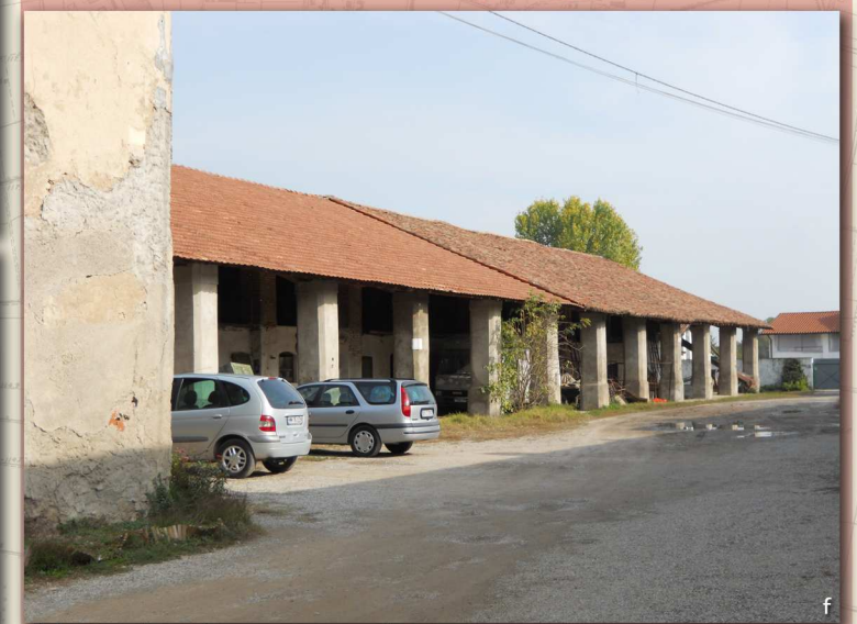
f. la Cascina Cantona: corte interna
