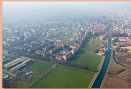
In alto: vista aerea dell'area d'intervento. Di fianco: percorso della TEEM. Tratto da: http://tangenziale.esterna.it
