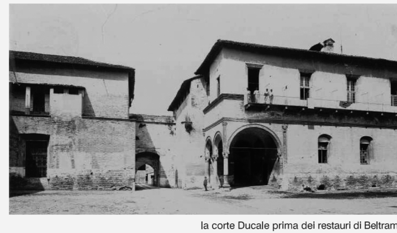
la corte Ducale prima dei restauri di Beltrami
