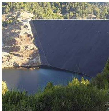
87. Diga di Gimigliano sul fiume Melito
