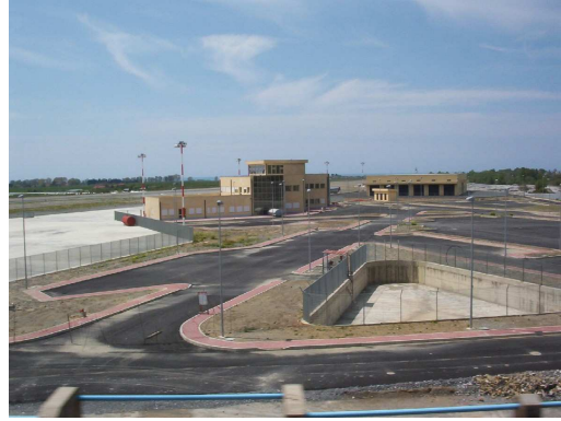
86. Stato di abbandono delle strutture
