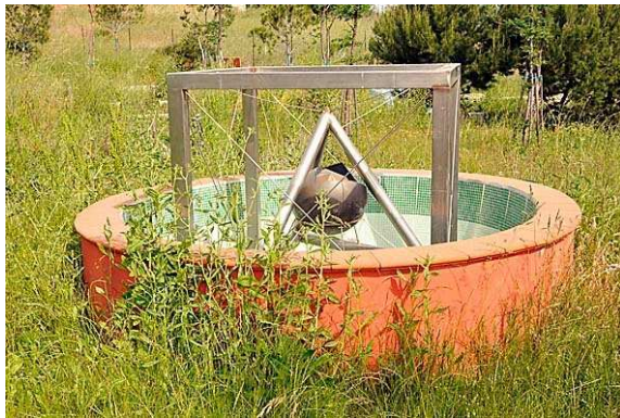
69. Incuria e abbandono delle installazioni
