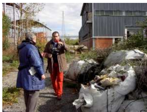
74. Giornalisti che denunciano la situazione di degrado e abbandono della raffineria
