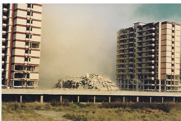
120. Abbattimento della prima delle sette torri
