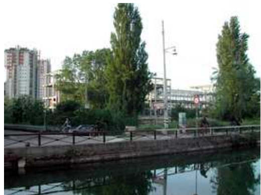
43. Scheletro in cemento dello scalo ferroviario
