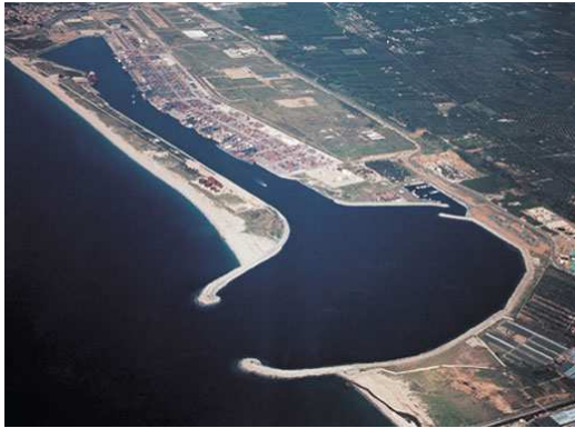
89. Veduta aerea del Porto di Gioia Tauro
