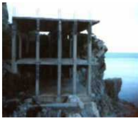
55. Scheletro in cemento di uno degli edifici del complesso
