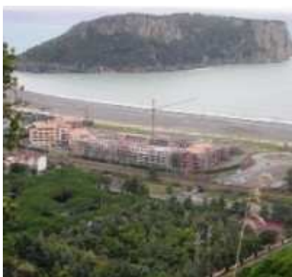
53. Veduta aerea del cantiere
