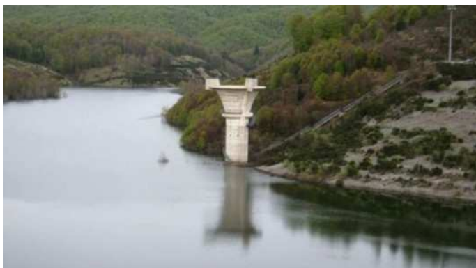
88. Opere mai terminate a supporto della diga sul fiume Metramo
