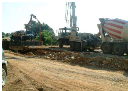
94. Cantiere della tangenziale est di Vibo Valentia
