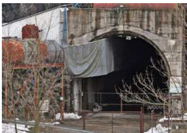
50. Cantiere abbandonato a Voltaggio (Liguria)
