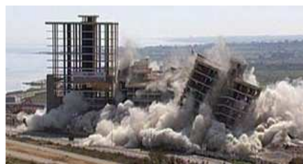
124. Demolizione delle strutture
