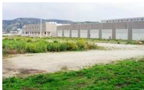
76. Completo stato di abbandono dell'edificio
