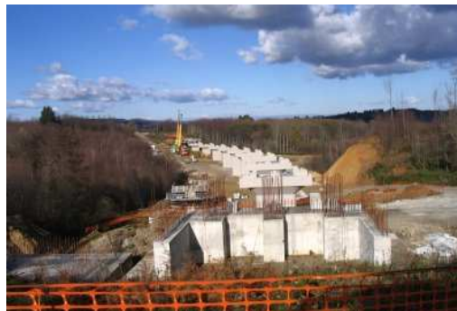
92. Trasversale delle Serre: cantiere aperto
