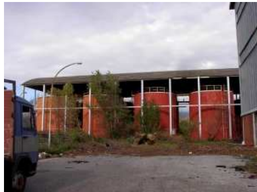
72. Cisterne di raccolta dell'olio inutilizzate
