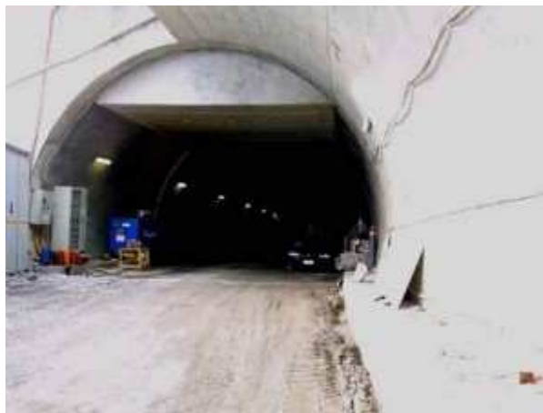
48. Cantiere per la realizzazione del tunnel
