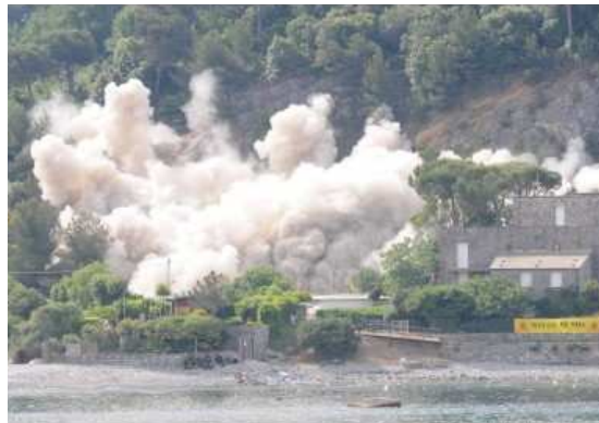
116. Demolizione del residence della Palmaria
