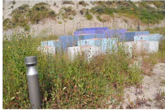
68. Incuria e abbandono delle installazioni
