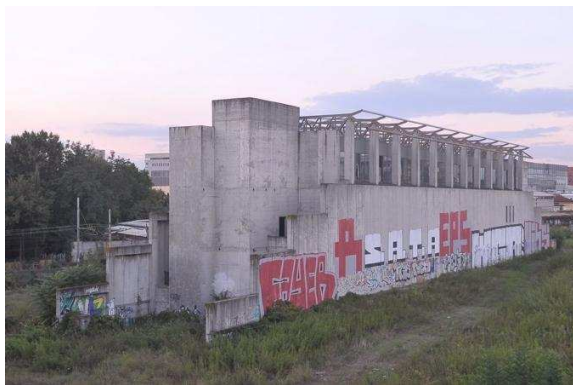
38. Stato di fatto attuale del Centro di Calcolo
