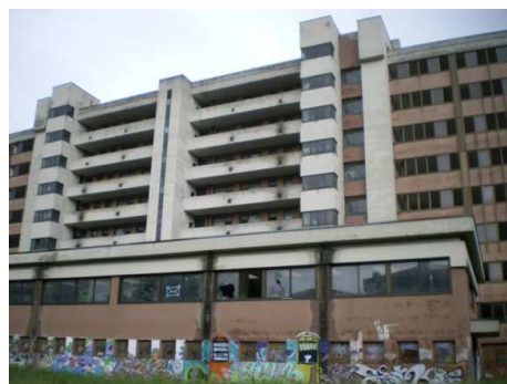
28. Degrado degli edifici del Quartiere
