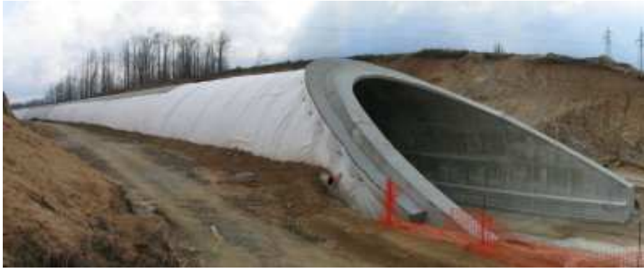
91. Trasversale delle Serre: cantiere aperto
