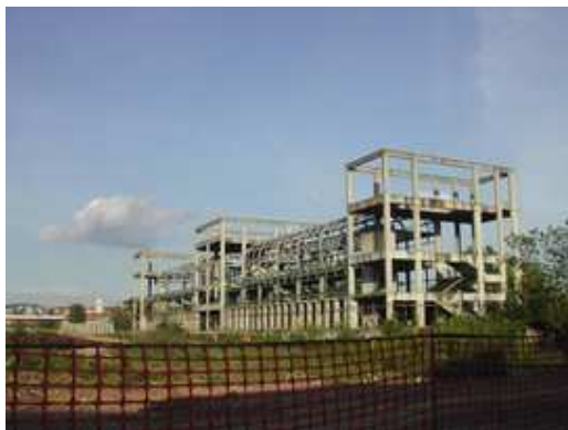
42. Scheletro in cemento dello scalo ferroviario
