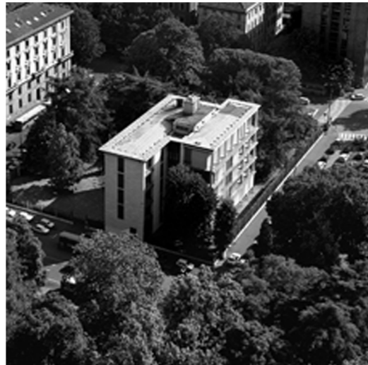
Fotografia aerea del progetto realizzato
