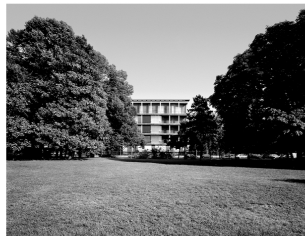
Fotografia d'epoca della facciata nord ovest, dal Parco Sempione
