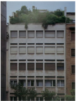
Facciata verso via Broletto
