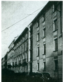
Foto d'epoca della facciata verso via Borgonuovo
