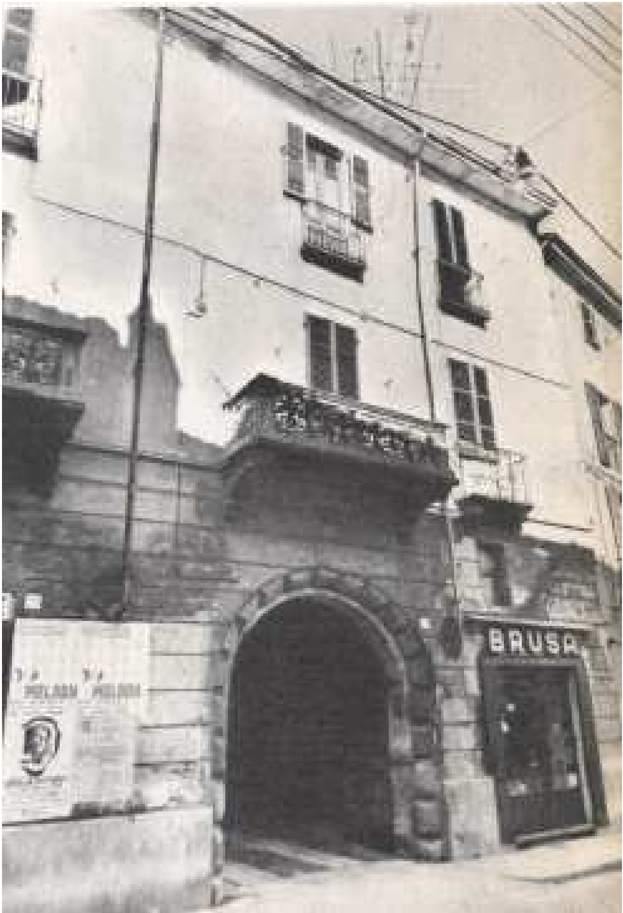
Figura 5_ Edificio in Corso Libertà
