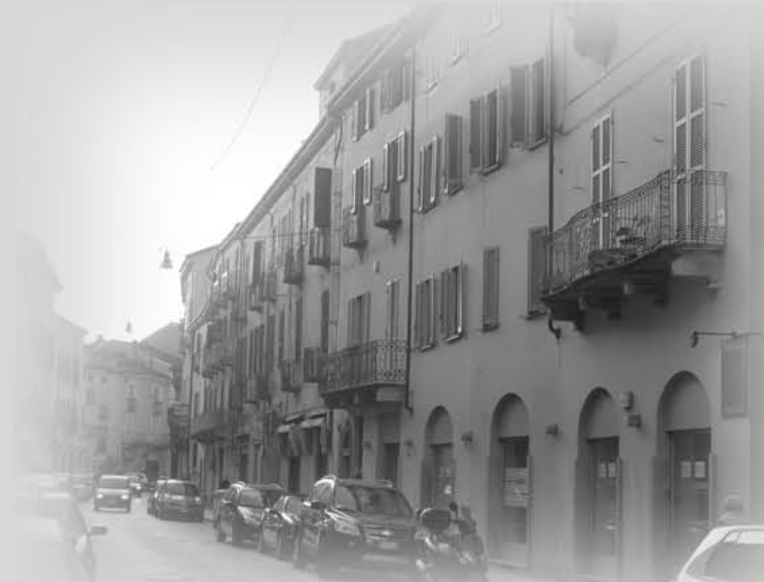
ESEMPIO DI TESSUTO COMPATTO CON CORTINA EDILIZIA SU CORSO LIBERTÀ
