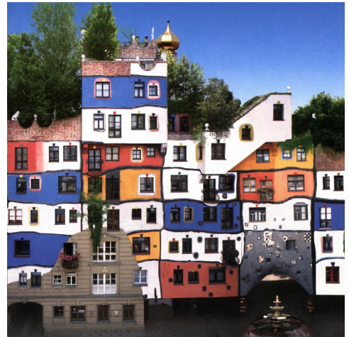
170 (in alto)_ Vista esterna con dettaglio della natura integrata; 171_ Particolare della facciata
