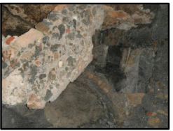
Dettaglio della scalinata
