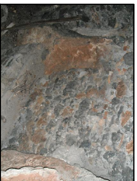
Dettaglio della parete in muratura
