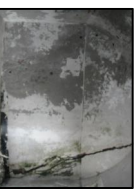
Frattura di una stanza del piano seminterrato (stanza I), parete verso volta. A destra dettaglio della frattura.
