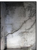
Frattura della parete nella stanza B, che poi prosegue attraverso il pavimento.
