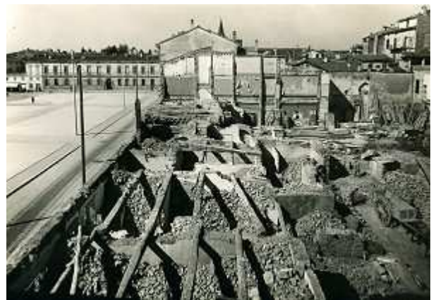
Figura 186: Demolizione del complesso preesistente alla realizzazione del palazzo del "Regime Fascista"; sulla sinistra l'area di Piazza Marconi ed il prospetto degli edifici su via Bella Chioppella. Data di ripresa: 1938 circa
