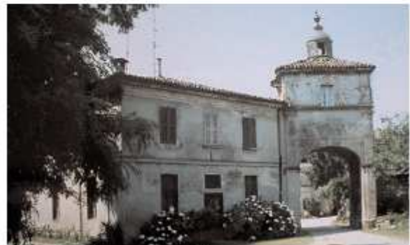
Cascina San Rocco - ingresso settecentesco
