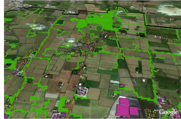
Boschetto-Migliaro – potenziali direttrici di sviluppo ecologico si dipartono dalla periferia settentrionale del territorio comunale, in direzione nord in appoggio alla presenza di tracciati ciclopeditoni esistenti affiancati ad infrastrutture storiche
