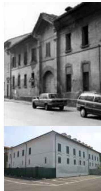
Ex caserma del diavolo a Seguito del restauro
