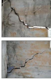
Dettaglio della fessurazione della parete finestrata con accesso ai balconcini.
