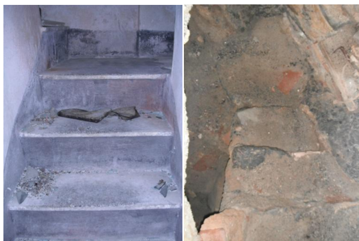
Fig. 31 - 32 A sinistra, scala che conduce alla sala decorata; a destra dettaglio della scala di accesso alla stalla.
