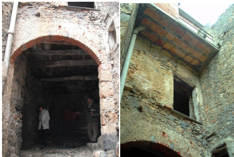
Fig. 63 - 64 La Porta Sottana, arco di accesso, foto scattata durante la visita del Borgo promossa dal FAI (marzo 2011); a destra, la struttura sovrastante.
