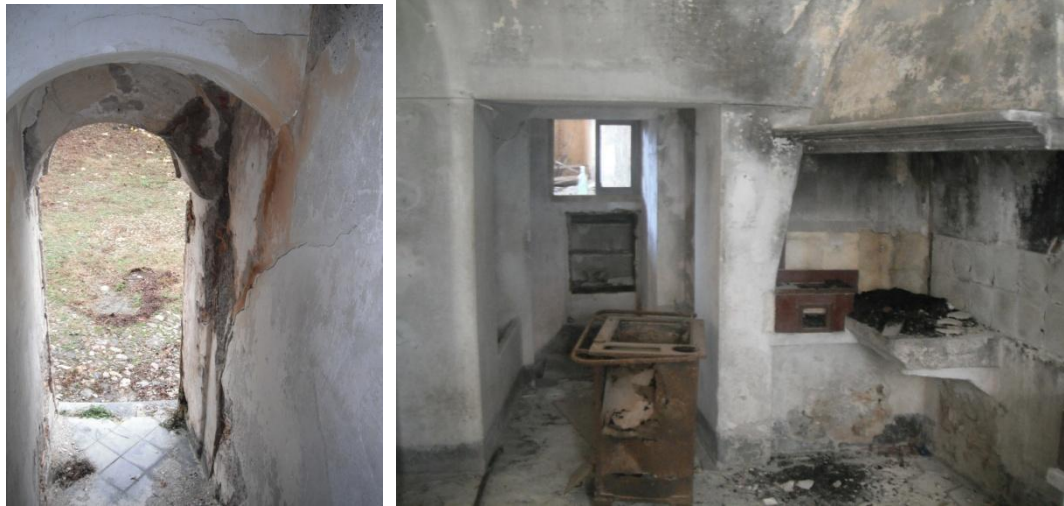
Fig. 37 - 38 Casa Panizza: accesso dalla piazza, sulla parete sono ancora visibili tracce dell'intonaco giallo con cui era dipinta; a destra la cucina del primo piano, con il forno, la vecchia stufa in ferro e al centro della foto sono ben distinguibili i gradini murati che davano accesso alla stanza dipinta.
