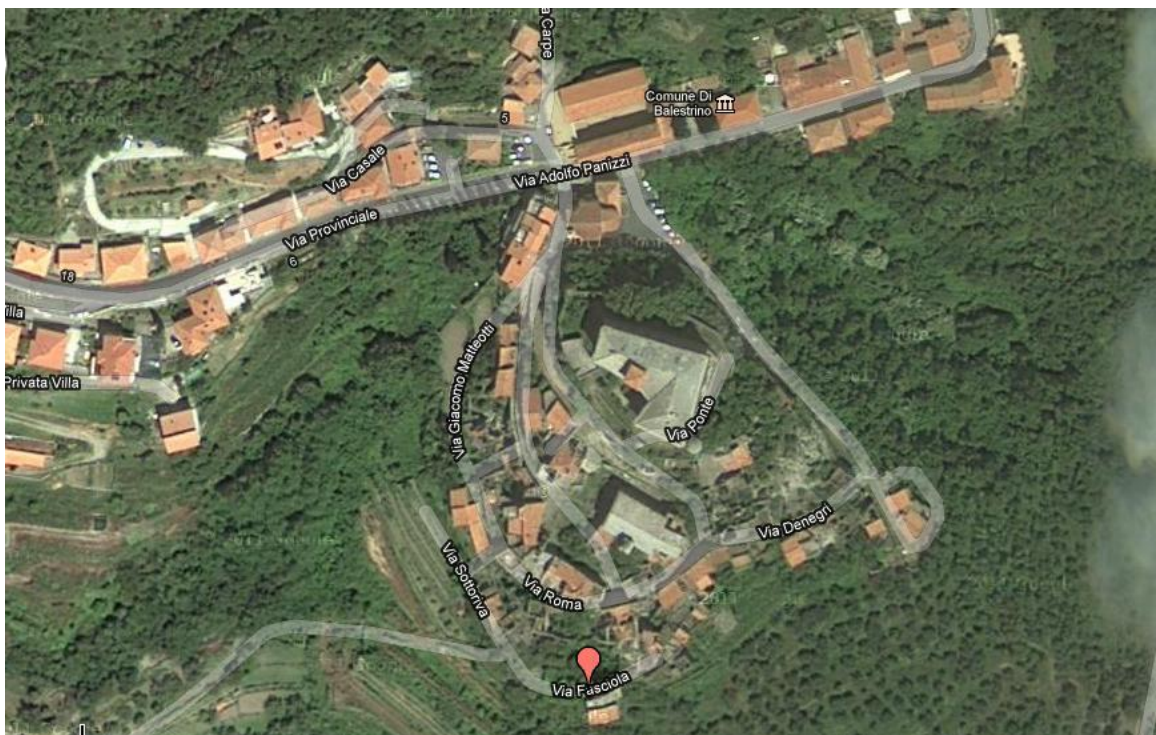
Fig. 21 Foto aerea del Borgo abbandonato di Balestrino, in basso la via che prende il nome dalla vecchia contrada della Fasciola che si trovava ai piedi de Borgo e oggi completamente abbandonata.
