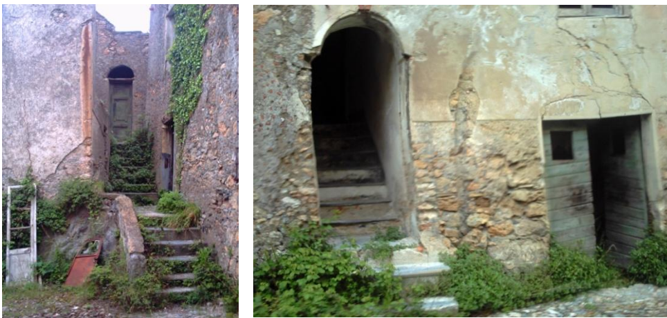
Fig. 22 - 23 Gli accessi di casa Panizza dalla piazza della Chiesa, a sinistra la scalinata che conduce al pilone, a destra gli accessi alla scala che conduce al piano superiore ed alle cantine.
