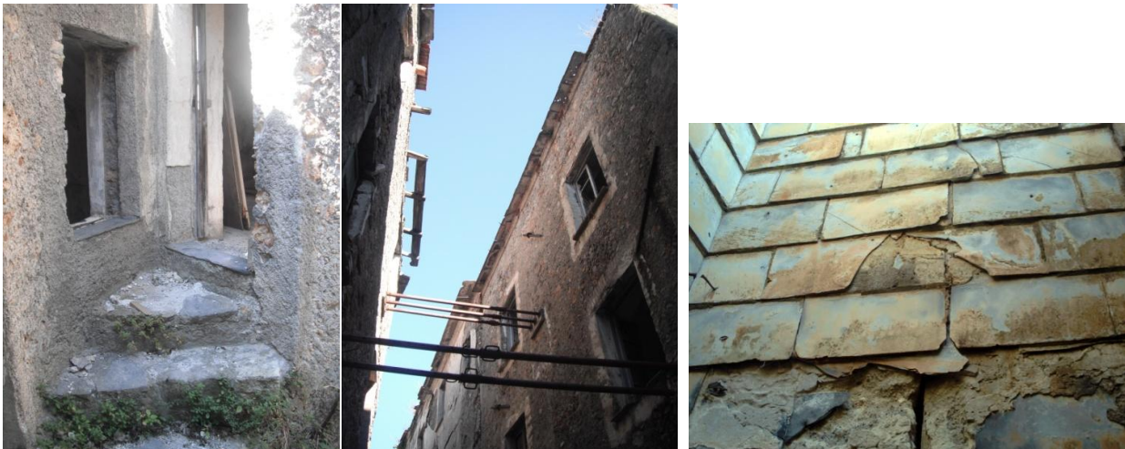
Fig. 112 – 113 - 114 Scalini rivestiti di ardesia (Casa Panizza: accesso alle stanze esterne dalla scalinata del Pilone) e lastre di ardesia che coprono i tetti di alcune case del borgo; a destra, dettaglio della copertura con abbadini delle pareti esterne di una casa del Borgo di Balestrino.
