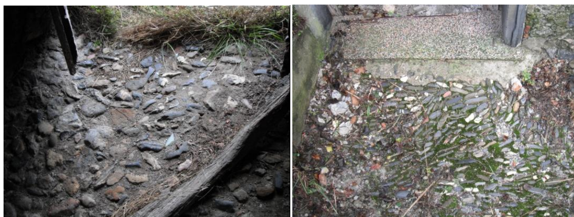
Fig. 75 – 76 Pavimento dell'accesso alle cantine di casa Panizza, e dell' accesso alla casa dalla scalinata del Pione.
