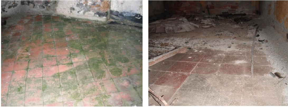
Fig. 83 – 84 Pavimento della camera al piano seminterrato (sopra la stalla) e della stanza murata.
