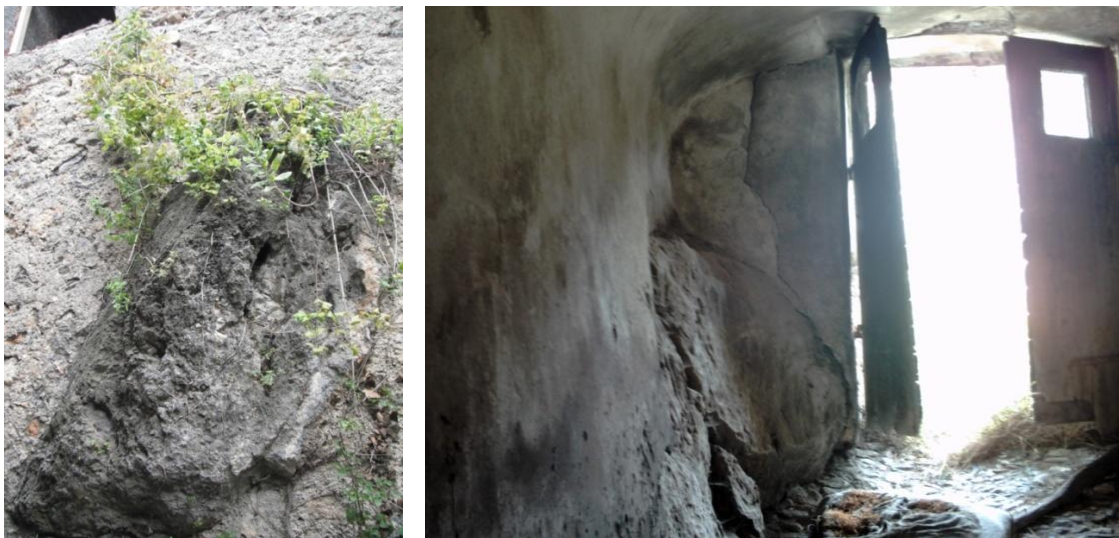
Fig. 60 – 61 Roccia affiorante visibile sul prospetto della casa Panizza verso valle e all'interno della stalla.
