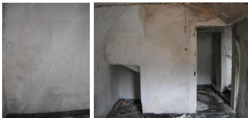
Foto a sinistra, dettaglio della parete con tracce della decorazione originaria rossa a tema floreale; a destra, accesso alla stanza e sottoscala.
