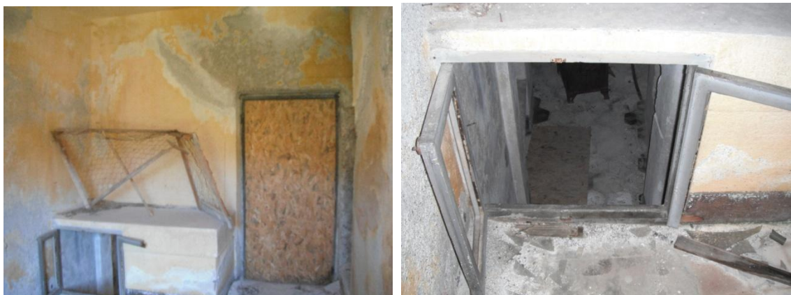
Fig. 39 - 40 Parete della stanza murata con accesso dalla scalinata e dettaglio della botola da cui si accede oggi.
