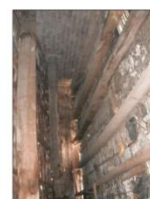
Dettaglio del sottotetto.
