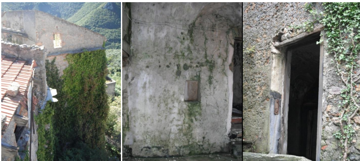
Fig. 102 - 103 - 104 Casa Panizza: fronte su via Sottoriva, parete interna di una stanza del primo piano e Ingresso di casa Panizza dalla scala del Pilone
