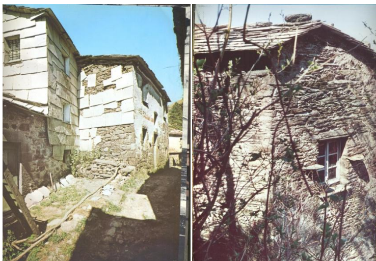
Fig. 108 – 109 Lastre di ardesia che ricoprono le superfici esterne delle case di Cella, dove le lastre aderiscono alla pietra assumendo la funzione di intonaco; a destra, una casa nella valle di Fontabuona realizzata interamente di ardesia.
