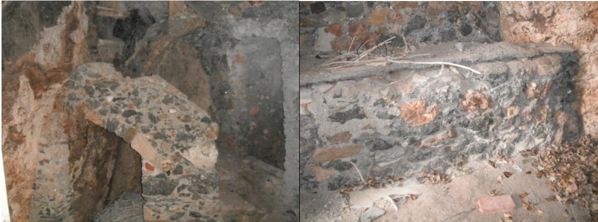
Fig. 8 – 9 Dettaglio della muratura della scala di accesso alla Stalla e al fienile, e particolare dei gradini.
