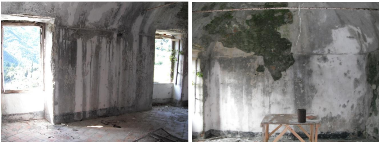
Fig. 44 – 45 Sala da pranzo, finestre sulla valle e parete laterale.
