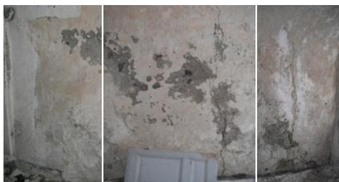
Parete di accesso alla stanza.
