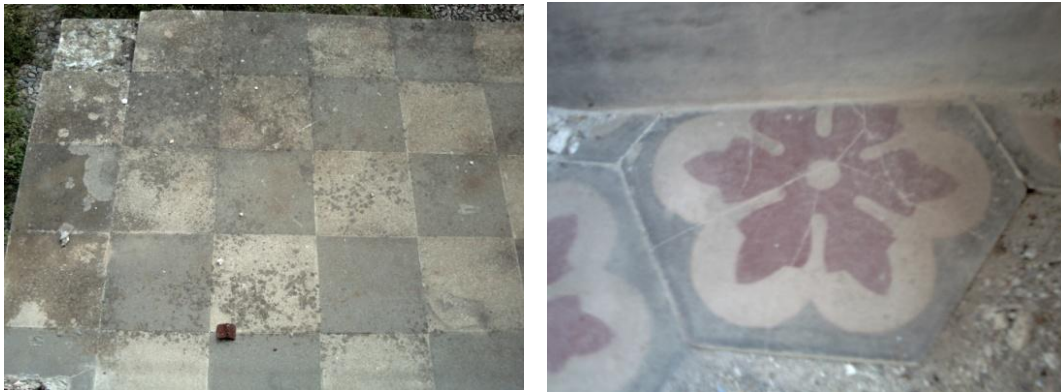
Fig. 85 – 86 Pavimento dei balconcini della sala dipinta, a destra le poche piastrelle rimaste del pavimento della sala dipinta, le altre sono state accuratamente rimosse.
