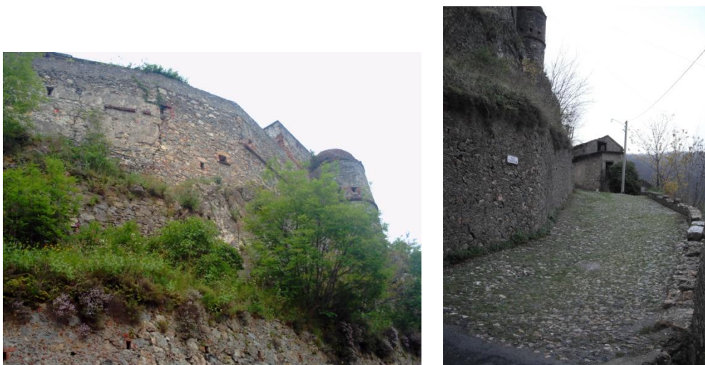
Fig. 67 - 68 Le mura del castello viste dalla strada e la salita da Via del Carretto.
