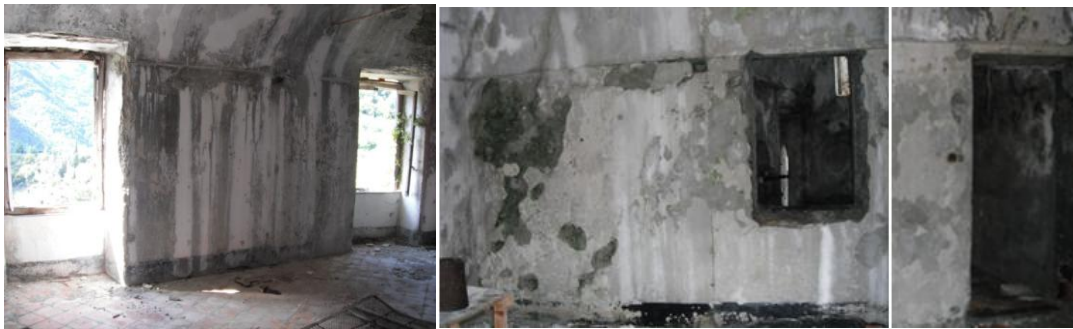
Frattura della parete nella sala da pranzo, a destra, dettaglio del proseguimento della lesione sulla volta del soffitto.
