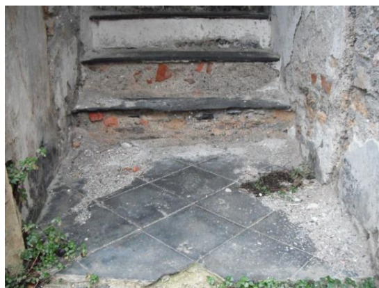
Fig. 87 Ingresso dalla porta ad arco
