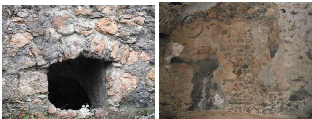
Fig. 26 - 27 Finestra della cantina, a livello strada, su Piazza della Chiesa, nella foto di destra si può vedere la roccia affiorante, su cui tutto il borgo e' costruito, dalla parete della cantina.
