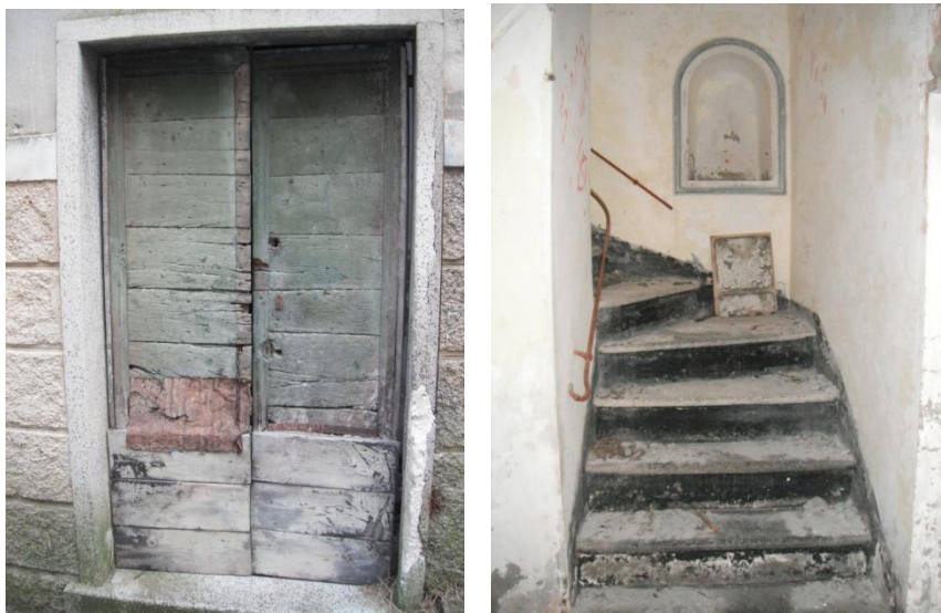
Fig. 35 -36 Asilo, portone di accesso e scalinata che conduce al piano superiore.
