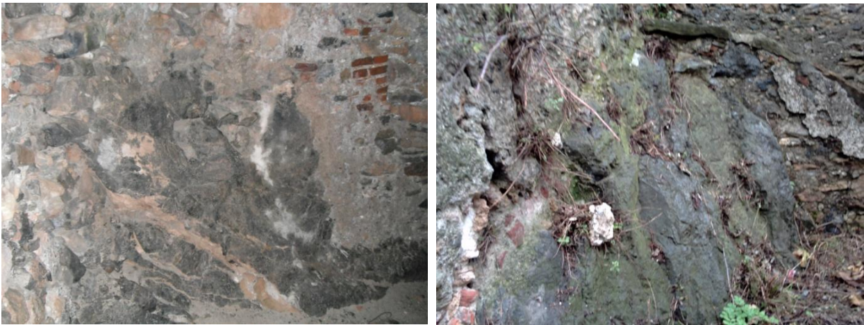
Fig. 32 – 33 Roccia su cui poggia la muratura di un'abitazione e dettaglio della roccia su cui è stato costruito il Pilonc.
