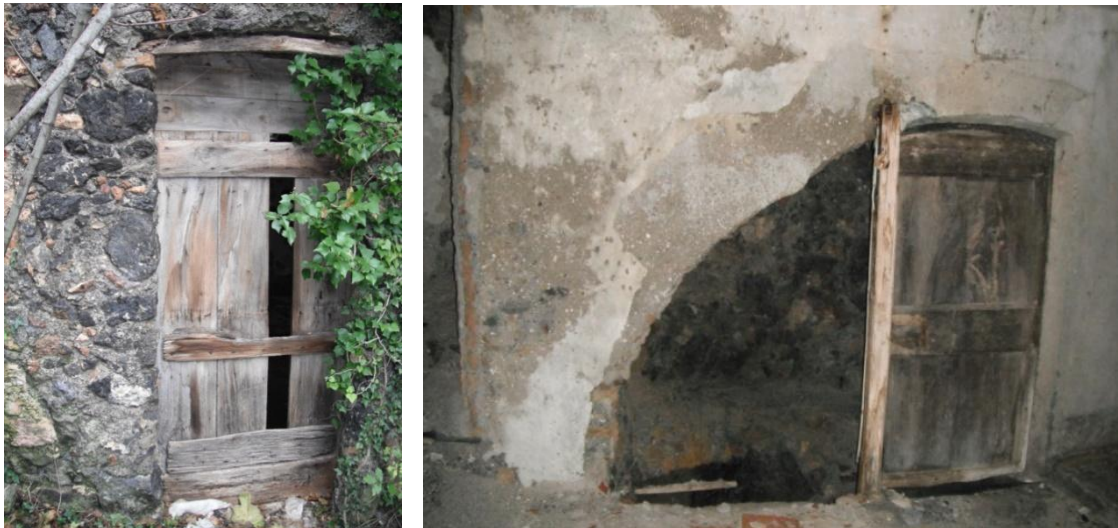
Fig. 50 – 51 Portone di accesso alla stalla e porta di accesso alla scalinata che conduce alla stalla ed al fienile dai locali seminterrati.
