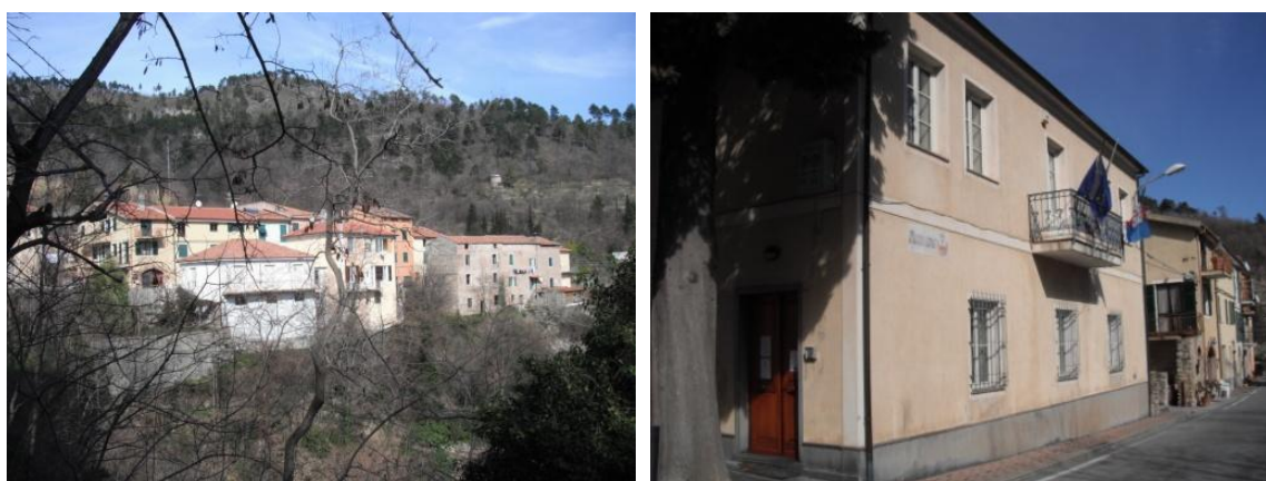
Fig. 139 – 140 L'abitato nuovo di Balestrino, a destra il municipio.
