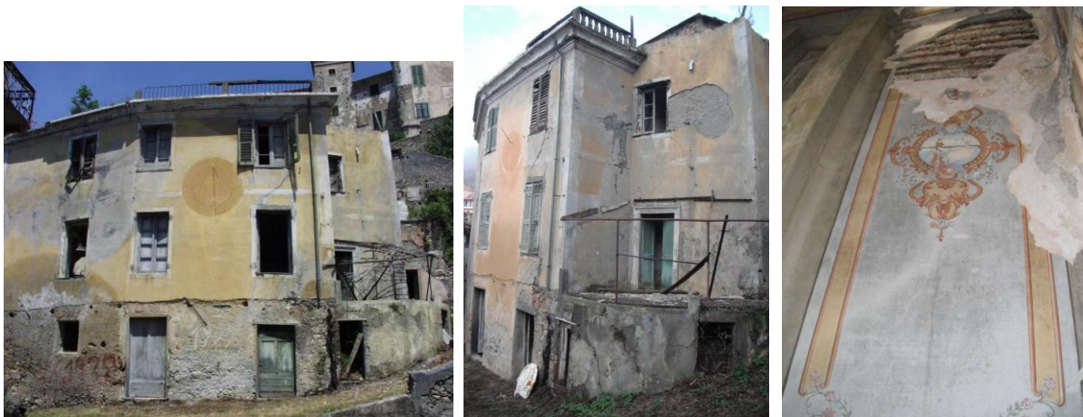
Fig. 45 - 46 - 47 Il Palazzo del Marchese, facciata su piazza Sant'Andrea, con i resti della meridiana dipinta ancora visibili, affaccio verso chiesa con balconcino e dettaglio della decorazione del salone.
