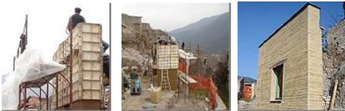
Fig. 12 -13 - 14 Fasi di realizzazione del muro in pisè, posizionato ai piedi del castello di Balestrino.
