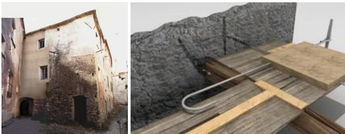
Fig. 10 - 11 Simulazione di risarcitura delle strutture murarie in pietra, con la tecnica del pisè, e esempio dell'intervento di consolidamento dei solai lignei. (Foto scaricate dal sito dell'Architetto Zunino).
