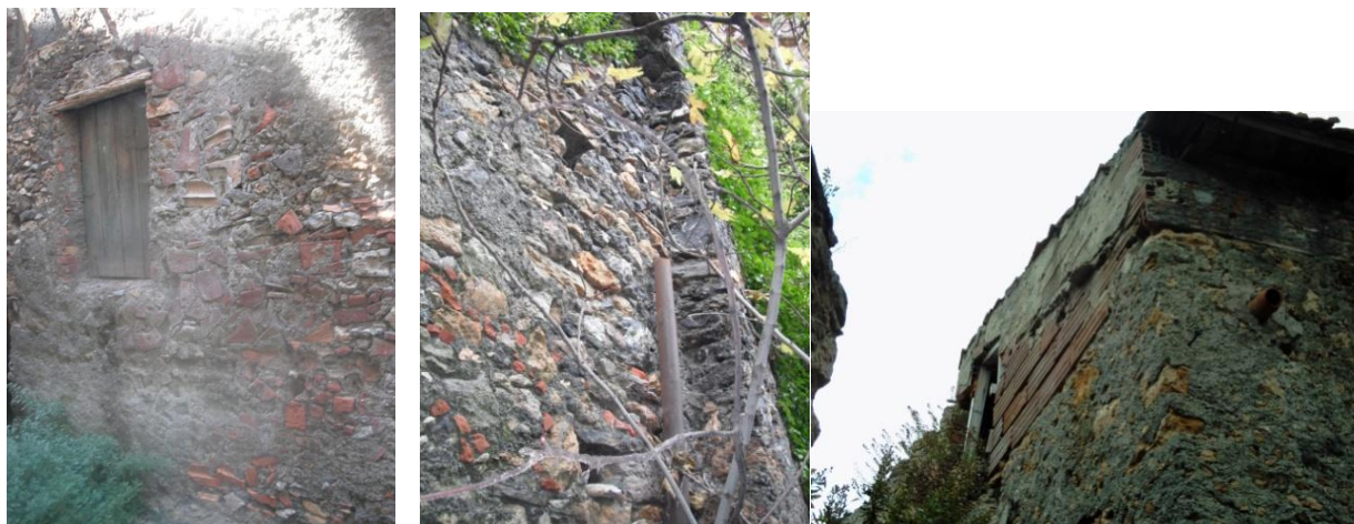
Fig. 5 – 6 - 7 Case del Borgo, le murature venivano realizzate con pietre di varie dimensioni e anche con pezzi di tegole; a destra casa Panizza: Fronte su valle e dettaglio del sopralzo dell'edificio realizzato in mattoni.
