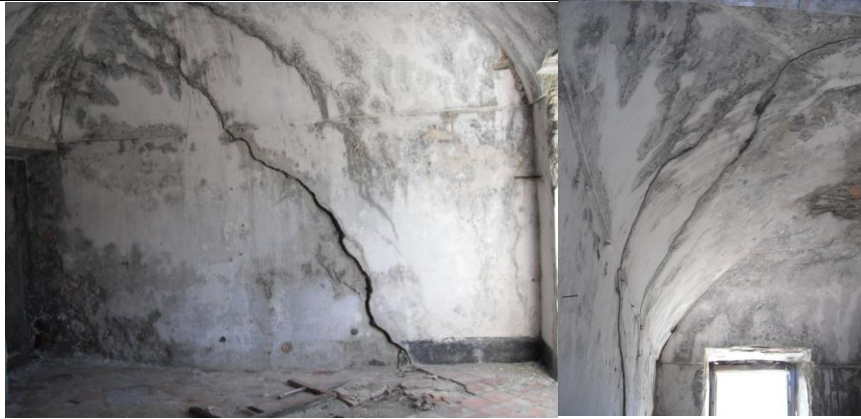
Frattura della parete nella sala da pranzo, a destra, dettaglio del proseguimento della lesione sulla volta del soffitto.
