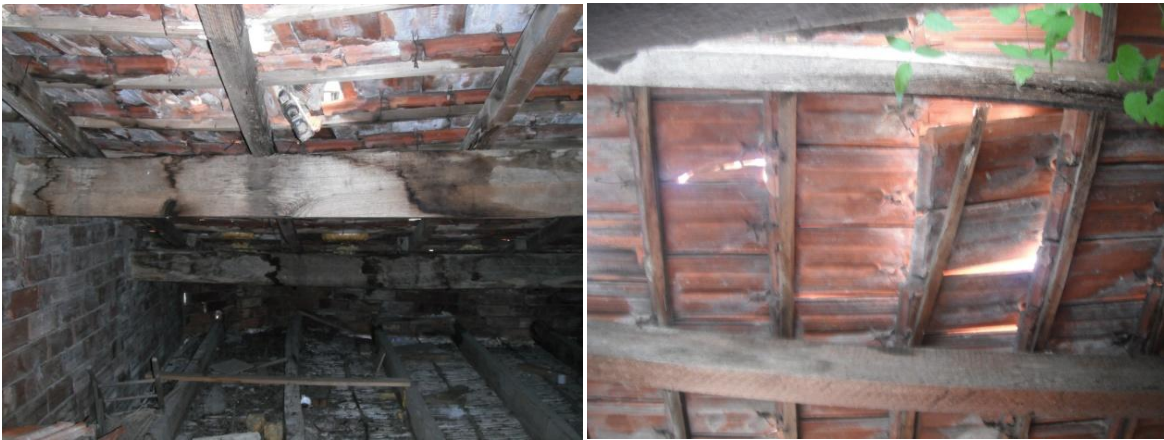
Fig. 70 – 71 Copertura del locale sottotetto e dettaglio.
