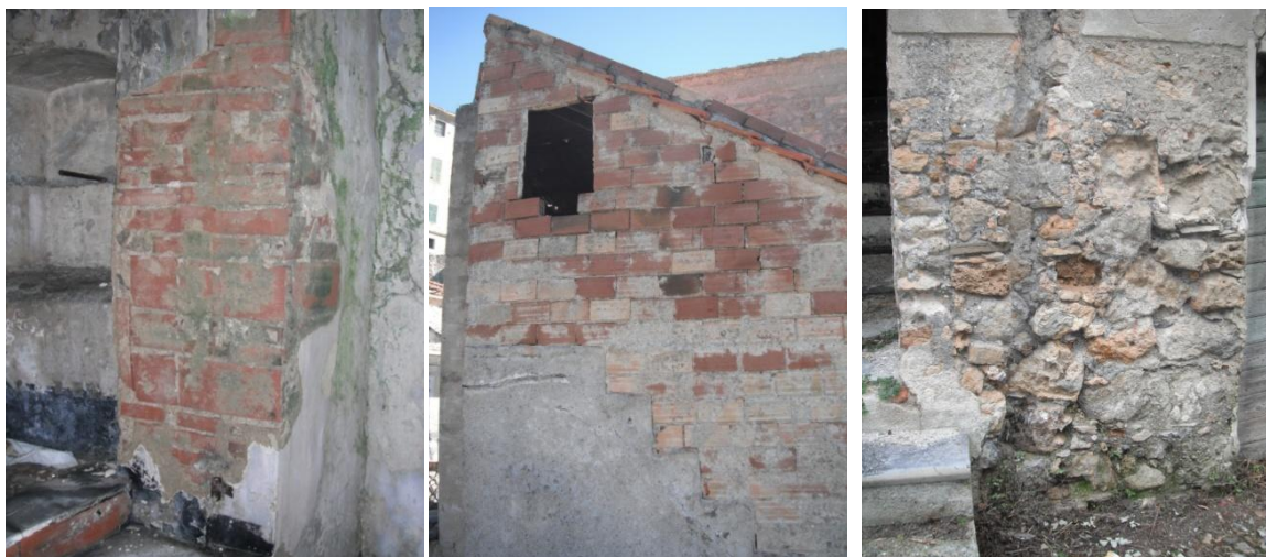
Fig. 2 - 3 - 4 Casa Panizza: dettaglio della muratura di una stanza, sottotetto di recente costruzione in mattoni e facciata sulla piazza.
