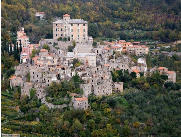
Fig. 2 Vista panoramica del borgo abbandonato di Balestrino oggi.
