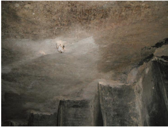
Fig. 90 – 91 Dettaglio di due catene nella muratura, sul pianerottolo della scala e sulla parete di una stanza.
