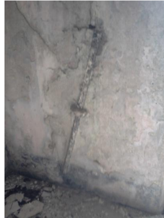
Fig. 90 – 91 Dettaglio di due catene nella muratura, sul pianerottolo della scala e sulla parete di una stanza.
