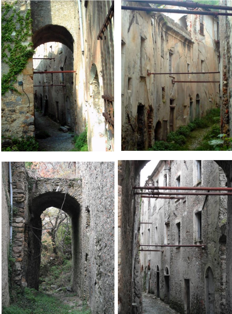
Fig. 133 - 134 - 135 - 136 Presidi antisismici presenti all'interno del Borgo di Balestrino: accesso al Borgo da via dei Marchesi del Carretto, Casa Negri, Piazza Inferiore e accesso da Via Sottoriva.
