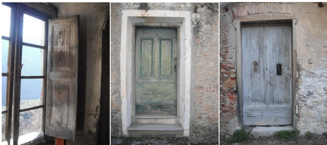
Fig. 20 – 21 – 22 Infisso di una finestra in buono stato di conservazione e portoni accesso ad una abitazione e all’osteria sotto il palazzo del Marchese (sul lato sinistro e' presente una decorazione in ferro battuto).
