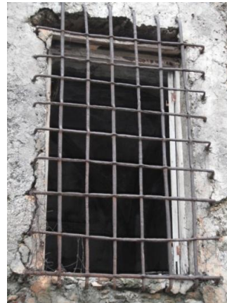
Fig. 92 – 93 Catena sulla muratura esterna del fronte su piazza della Chiesa e grata alla finestra del piano terra.
