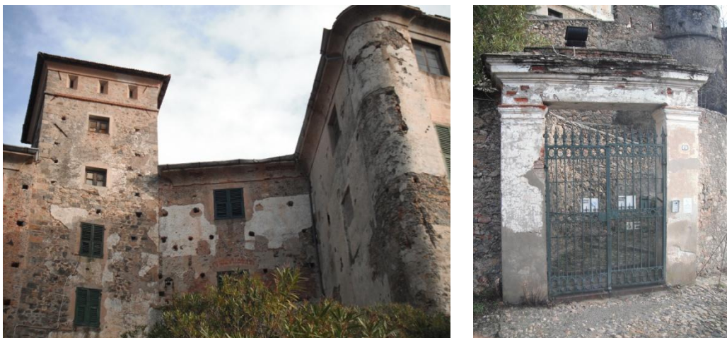
Fig. 71 - 72 Dettaglio del castello verso il borgo e cancellata di accesso all'edificio.
