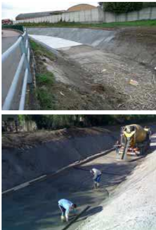
81. Rifacimento del fondo del Canale Villorosi (Fonte: www.etvillorosi.it )
