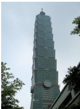
Fig. 36 - Dispositivo di smorzamento del grattacielo Tapei 101, Taiwan (Flickr).
