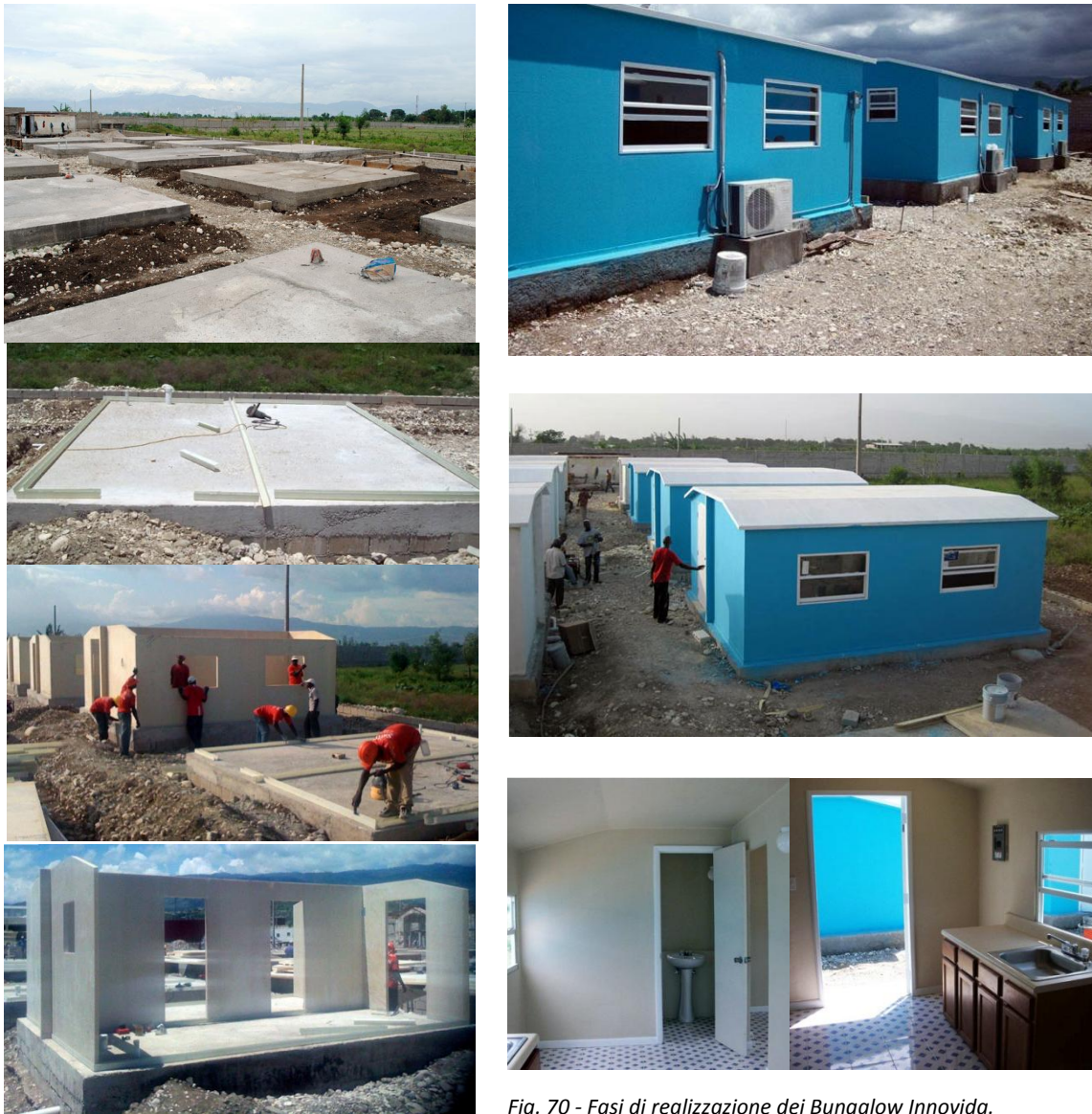
Fig. 70 - Fasi di realizzazione dei Bungalow Innovida.
