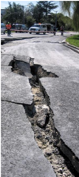
Fig. 16 - Danni al suolo causati dal terremoto di Christchurch, Nuova Zelanda il 4 Settembre 2010 (Flickr).
