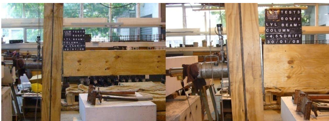
Fig. 47 - Test condotto sul giunto tipo trave pilastro: è evidente l'apertura del gap tra gli elementi in corrispondenza della piastra di acciaio.
