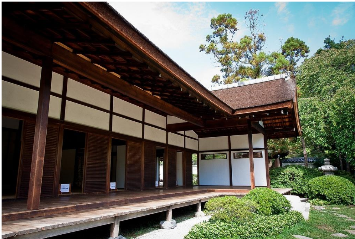
Fig. 43 - Porticato esterno, dettagli dell'attacco a terra e della facciata totalmente permeabile (Flickr).
