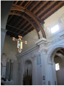
Fig. 25 - Caltabellotta, ripristino della copertura della Chiesa della Madrice dopo il terremoto del Belice del 1968. Le forme originarie della volta sono ricordate dalla sequenza di archi in legno-acciaio. L'ammorsamento dei muri laterali è garantito da una struttura leggera capace di assorbire spostamenti futuri grazie allo schema di vincolo ad arco a tre cerniere.
