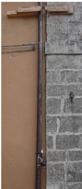
Fig. 18 - Sismografo da cantiere ("istruzioni: il movimento causato dal sisma fa allontanare le due frecce facendo cadere la birra"), Pescomaggiore, L'Aquila, Febbraio 2011 (Flickr).
