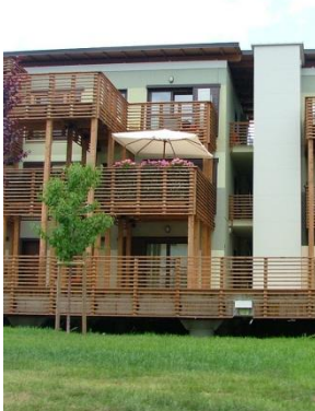
Fig. 52 - Alcuni esempi di edifici realizzati con il Progetto C.A.S.E., L'Aquila (Flickr).
