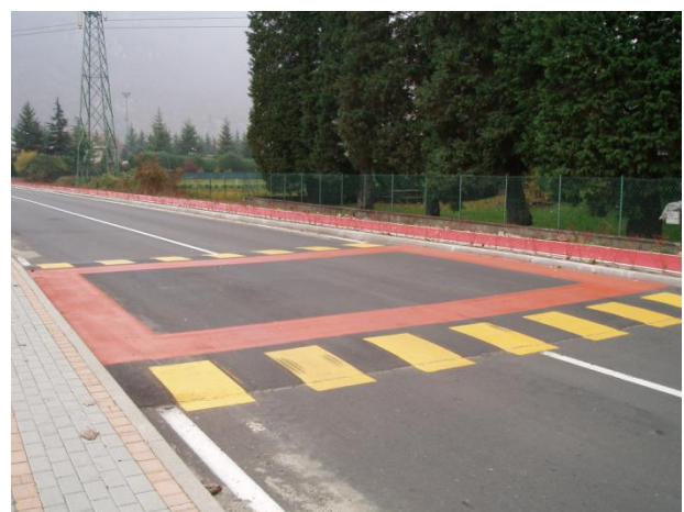
Fig. 428 - Esempio di intersezione rialzata con bande di colore per segnalare il pericolo.
