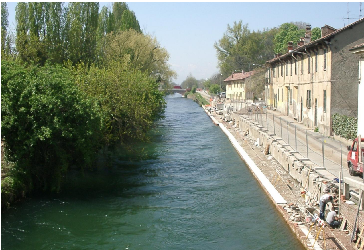
Fig. 387 – Lavori di riqualificazione lungo l'alzaia del Naviglio Grande nel territorio comunale di Robecco sul Naviglio.
