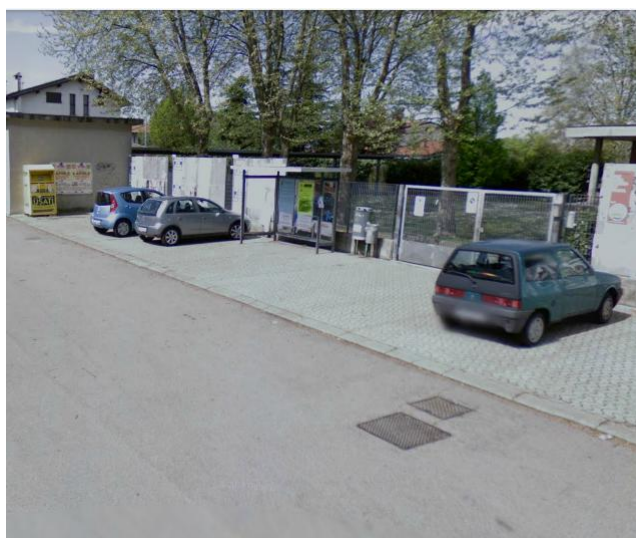
Fig. 418 – Accesso alla scuola elementare ‘Giuseppe Verdi’.
