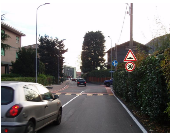
Fig. 428 - Esempio di intersezione rialzata con bande di colore per segnalare il pericolo.
