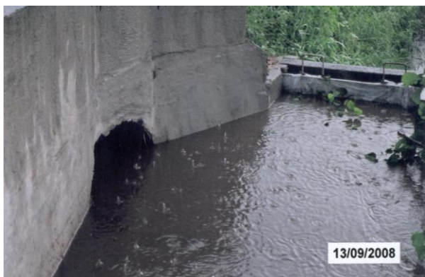
Fig. 477 – Punto di sbocco dello scarico di troppo pieno in frazione Casterno durante un evento meteorico (2008).
