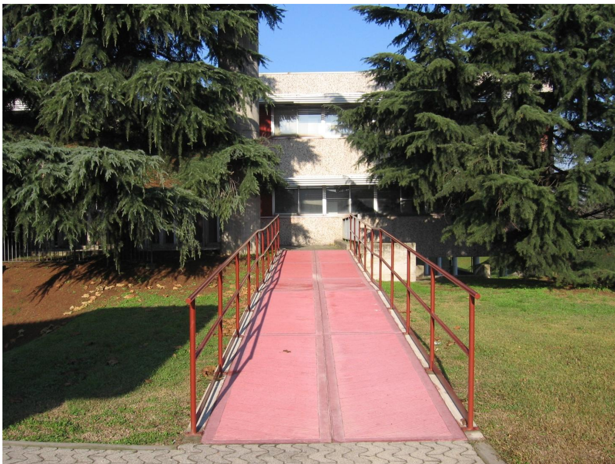
Fig. 135 – Rampe di accesso per disabili nelle strutture scolastiche di Robecco sul Naviglio
