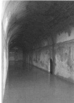
23. Interno della cisterna
