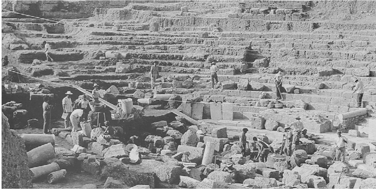
42. I lavori di restauro negli anni ottanta
