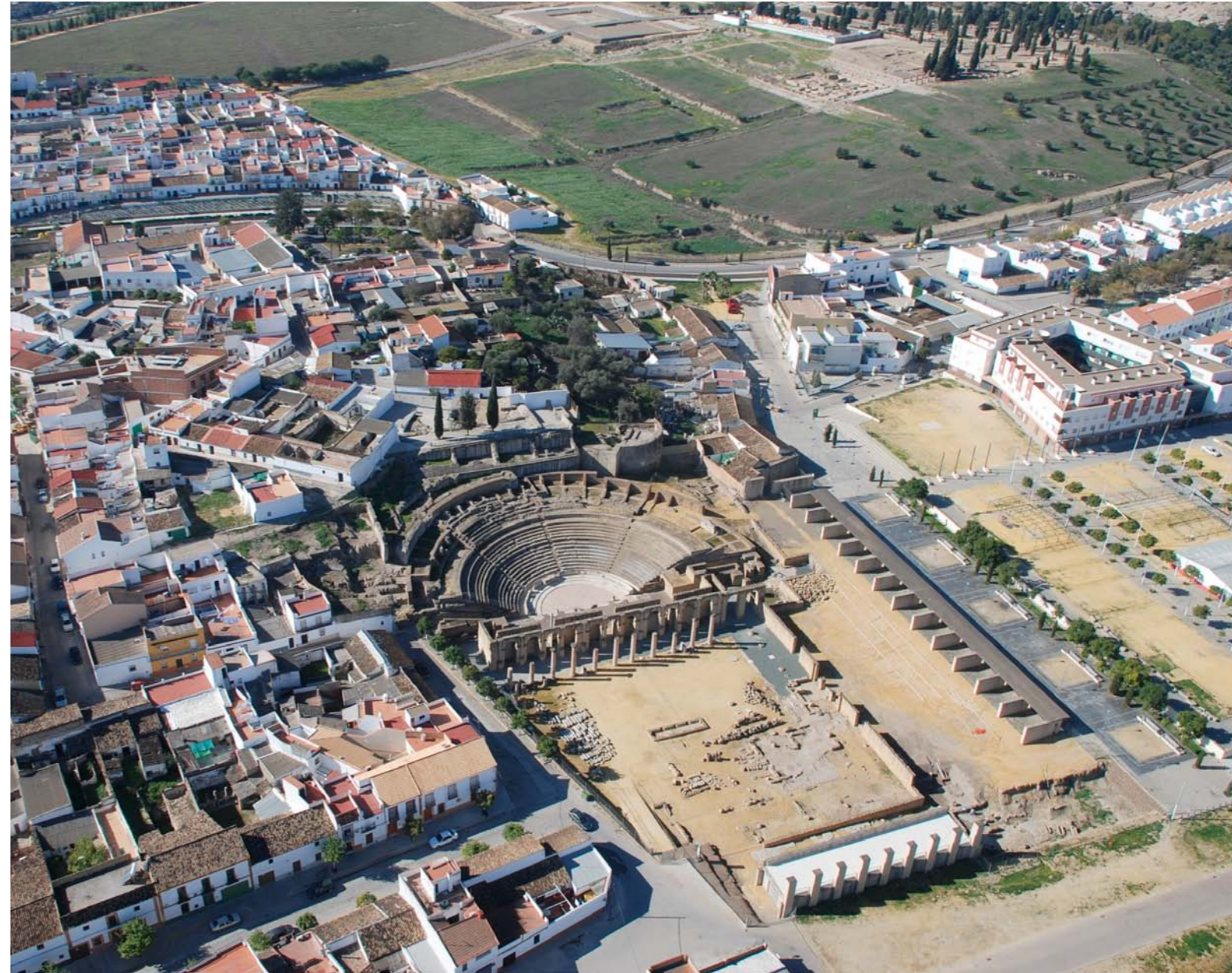
63. Vista aerea del teatro allo stato attuale
