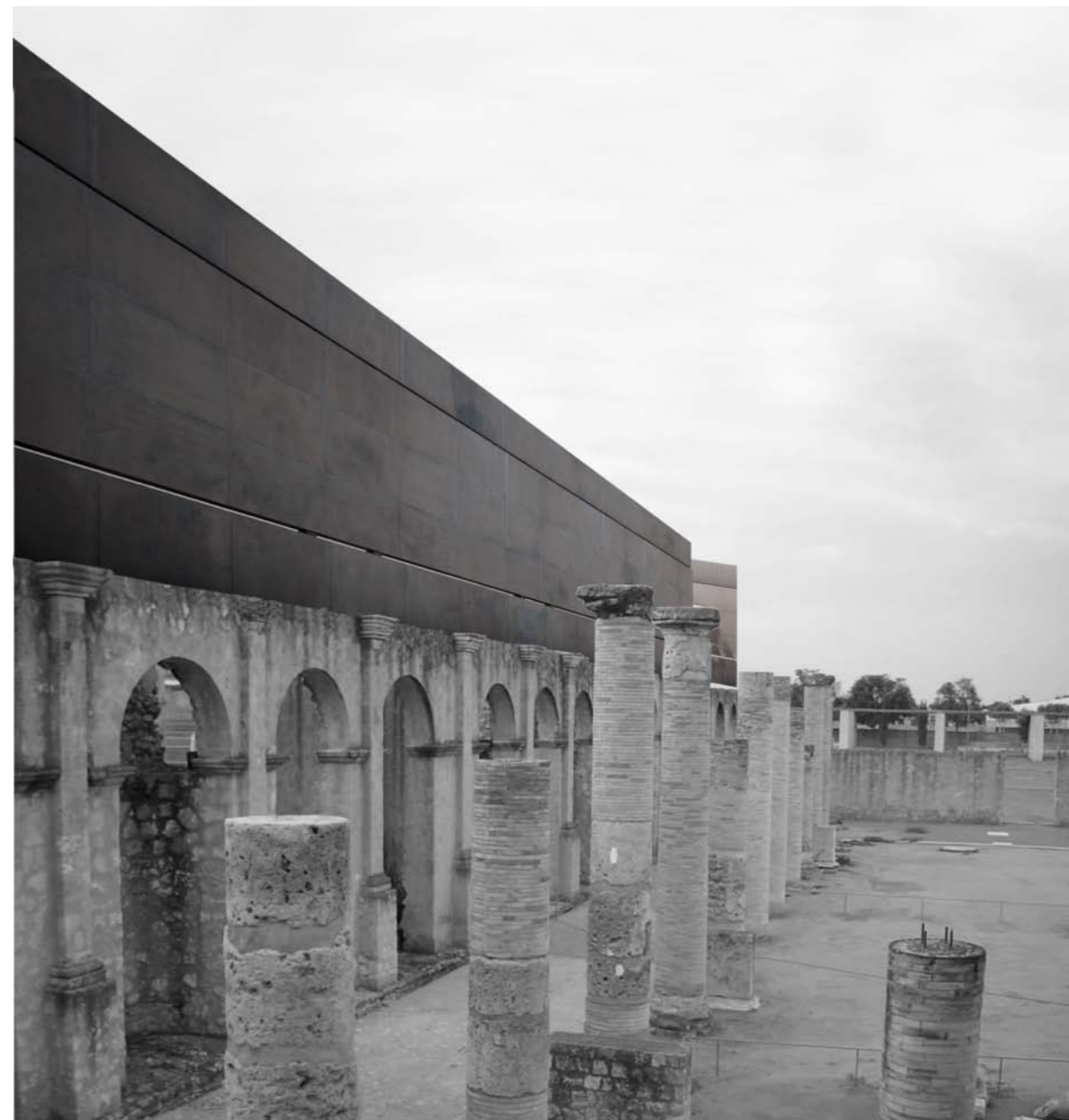
73. Fronte del muro in corten verso il porticus post scaenum
