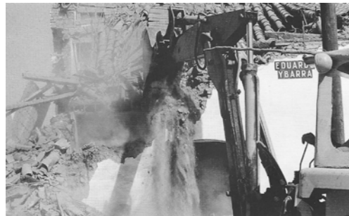
36. I lavori di demolizione del 1971
