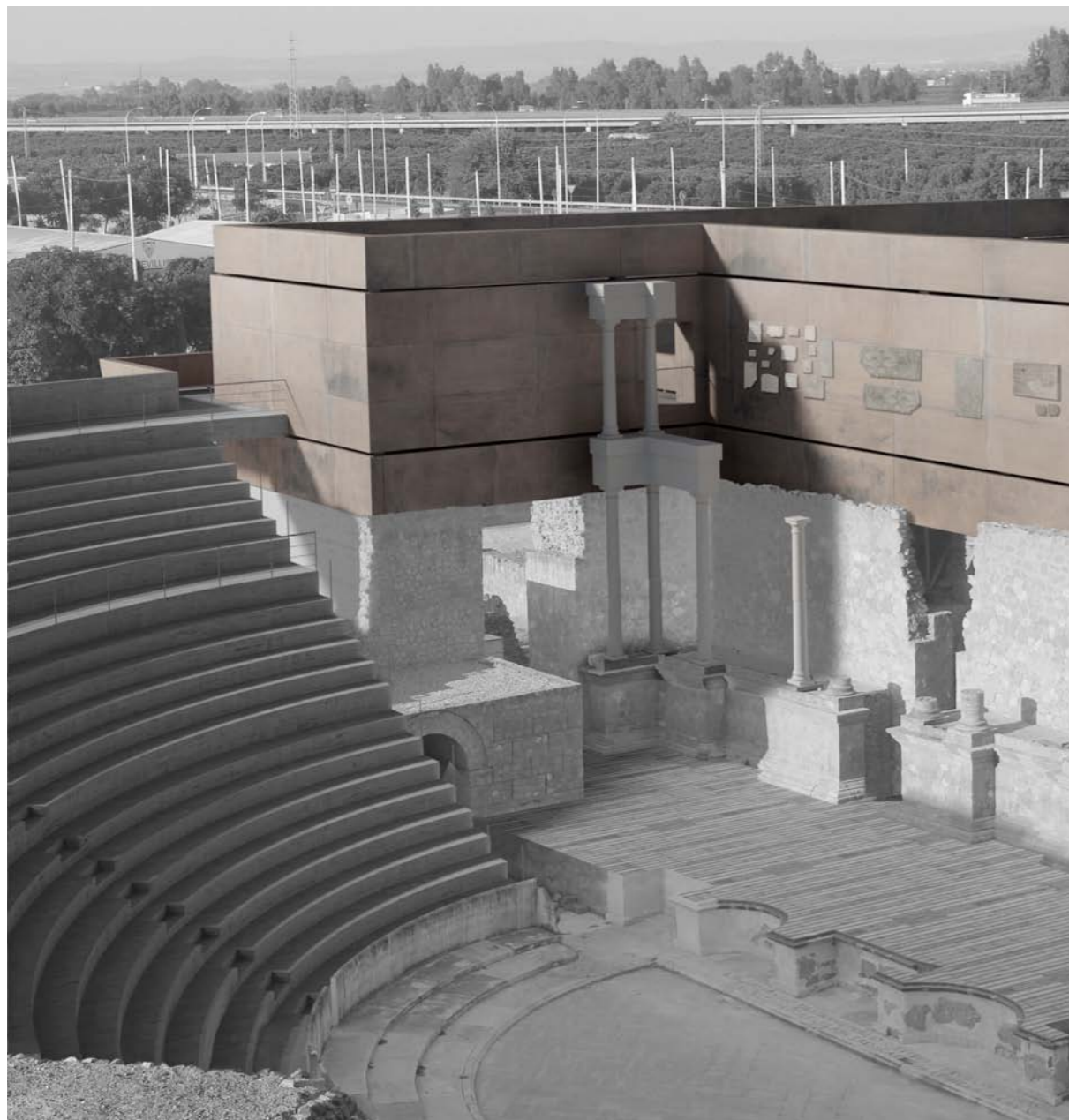
72. Fronte del muro in corten verso la cavea
