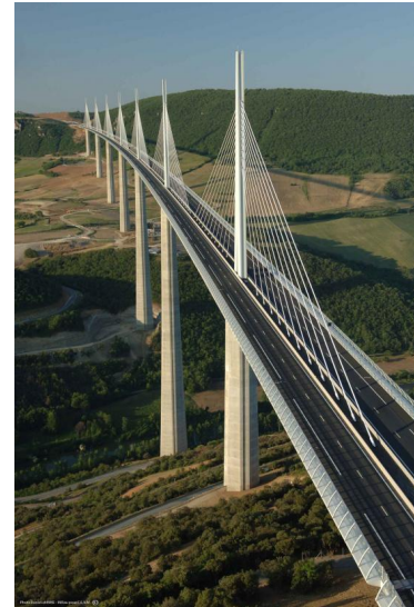
(b) Viadotto autostradale presso Millau, Francia
