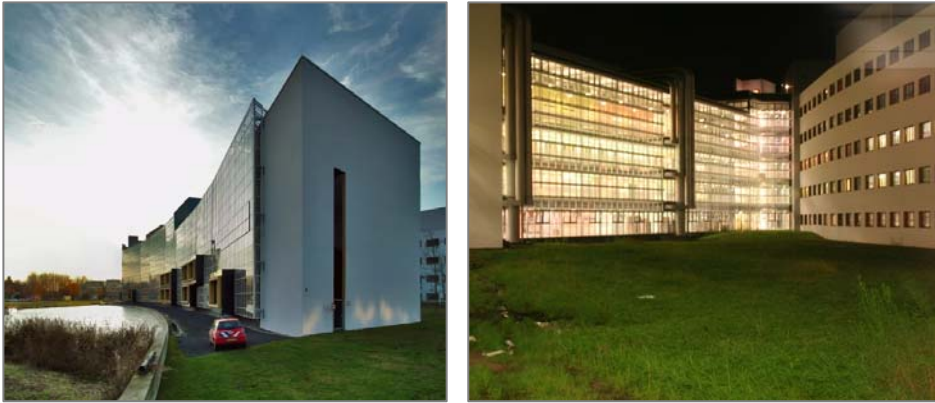
Vista lato nord-est. Vista punto di convergenza interno dei due edifici nuovi
