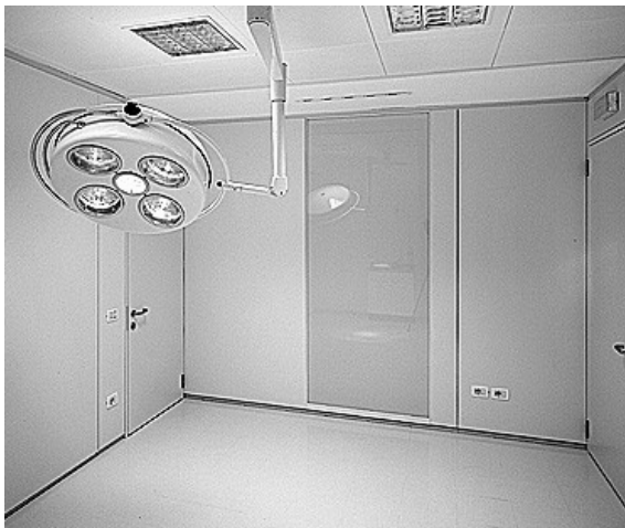
Pareti divisorie interne mobili installate all'interno di una stanza per la degenza Pareti divisorie interne mobili per locali ambulatoriali
