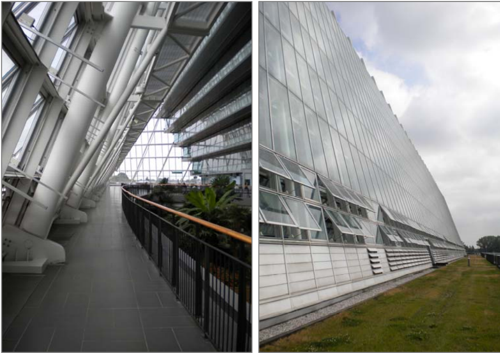
Veduta del corridoio lungo la facciata e Veduta della vela dal parco (particolare delle aperture)
