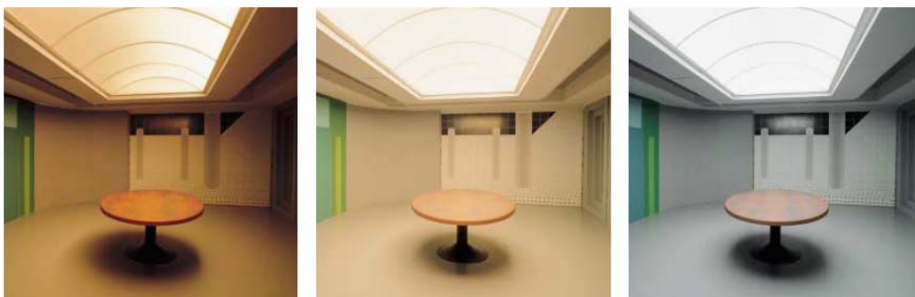
Esempio di sistema di illuminazione dinamica con variazione di intensità e colore della luce
