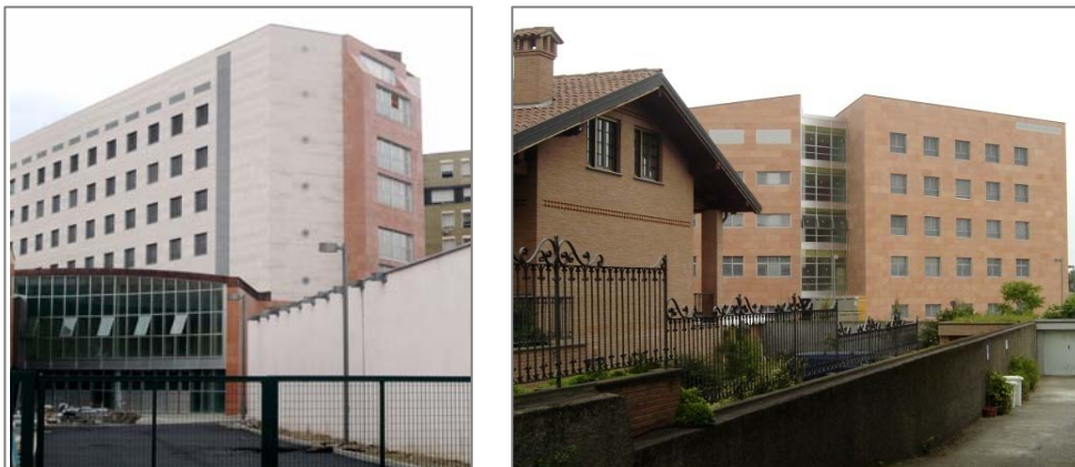
Connessione blocchi "B" e "C" e fronte ovest del blocco C
