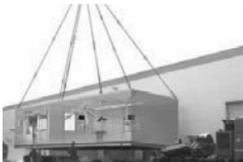
Fasi di allestimento, trasporto e posizionamento di moduli strutturali prefabbricati
