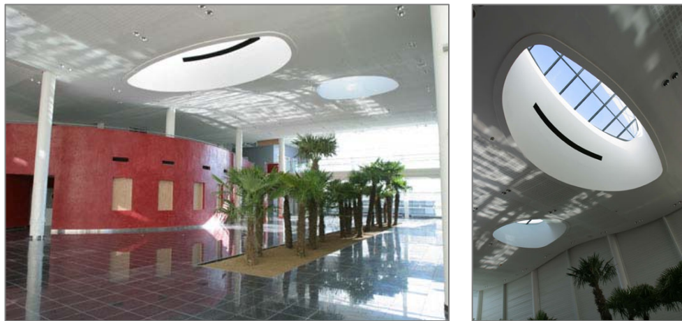
Hall di ingresso edificio B1 A e dettaglio lucernario
