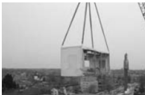
Fasi di allestimento, trasporto e posizionamento di moduli strutturali prefabbricati
