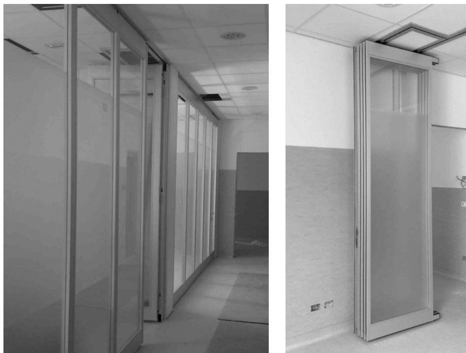
A sinistra, pareti manovrabili vetrate utilizzabili per la suddivisione delle sale di degenza. A destra, parete manovrabile impacchettata nella zona di raccolta.
