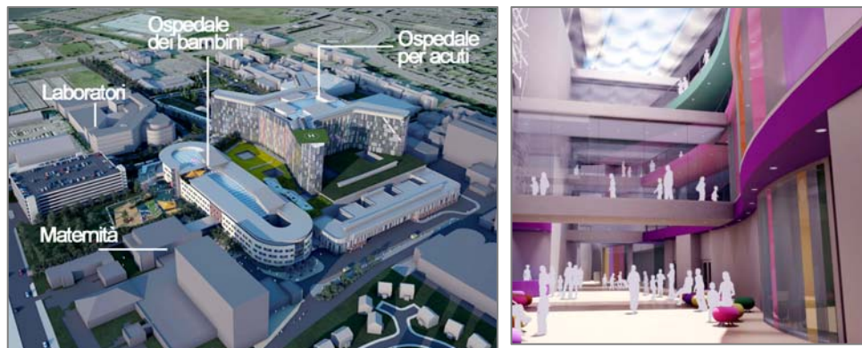
Vista New South Glasgow Hospital Campus e Ospedale dei Bambini
