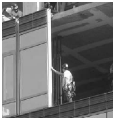
Facciata continua con costruzione a cellule indipendenti
