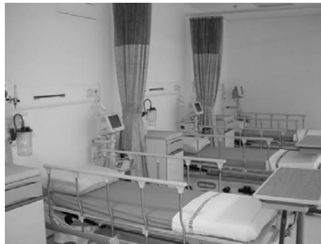
Utilizzo di binari elettrificati all'interno di stanze di degenza nell'ospedale di Singapore
