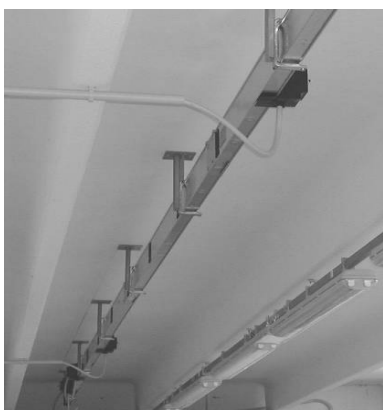
Condutture posate a vista in un locale tecnico e in un magazzino
