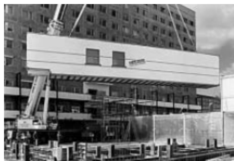
Fasi di allestimento, trasporto e posizionamento di moduli strutturali prefabbricati
