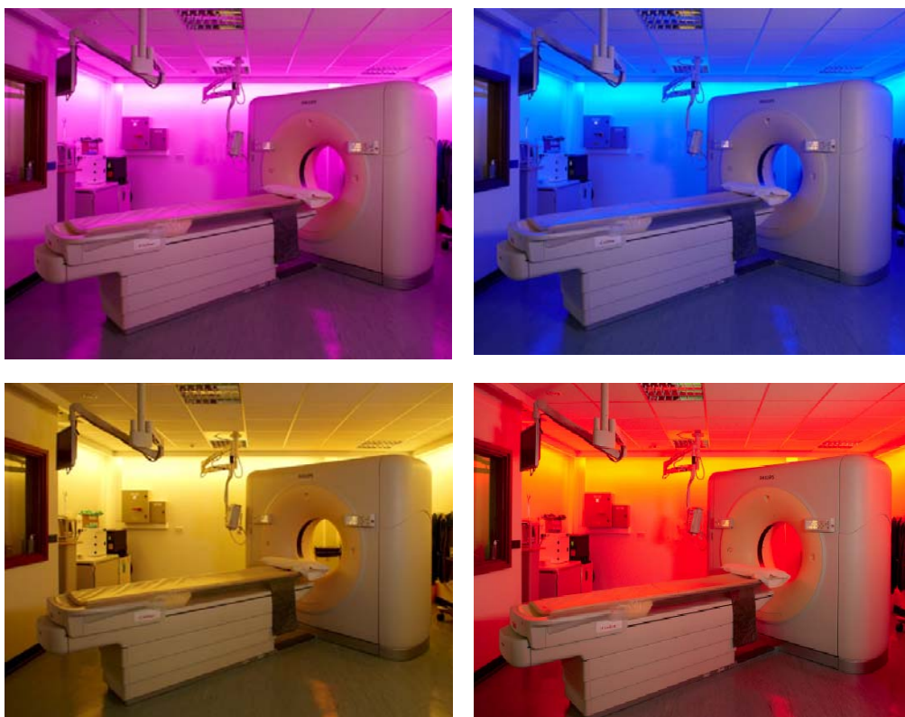
Esempio di applicazione di illuminazione dinamica in sala diagnostica – Princess Alexandra Hospital di Harlow (UK)
