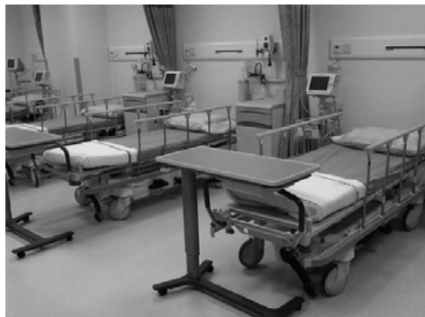
Utilizzo di binari elettrificati all'interno di stanze di degenza nell'ospedale di Singapore
