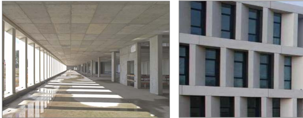
Elementi portanti in cemento armato prefabbricato con funzione anche di frangisole
