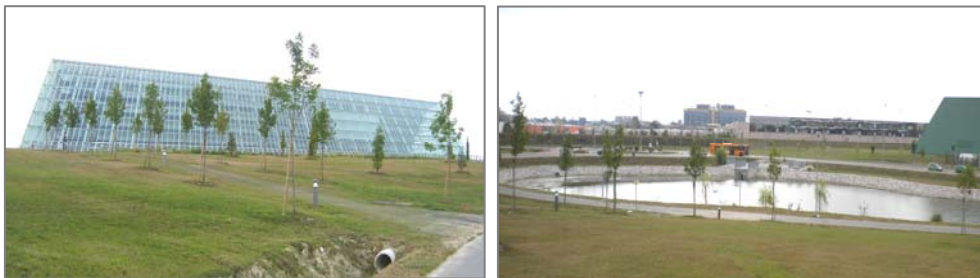
Vista esterna principale e Veduta esterna del laghetto antistante al corpo principale
