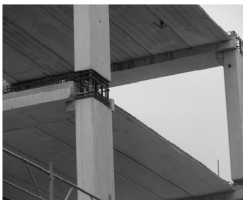
Struttura a telaio in C.A.P. con getto di completamento mensola
