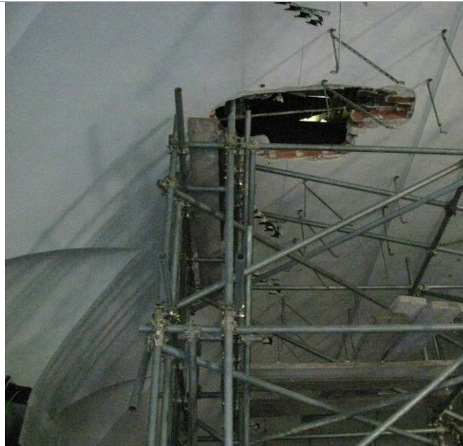
Figura 331 – Posizione del prelievo – porzione della struttura voltata dopo il prelievo del campione.
