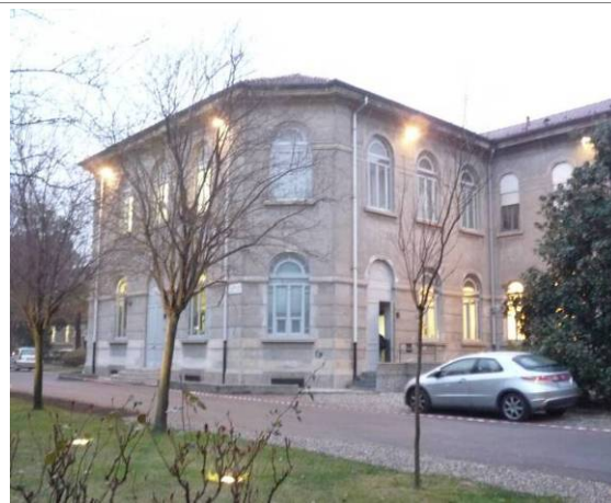
Figura 14 – Edificio 6_a1, corpo della grande aula.
