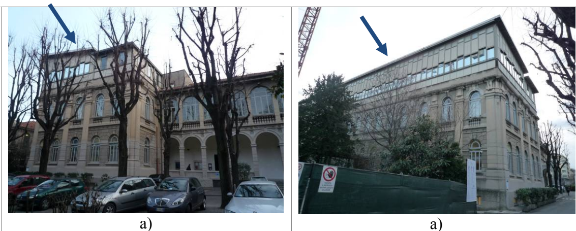
Figura 268 – Politecnico di Milano, Edificio 3 del corpo est. a) vista nord, b) corpo a est
