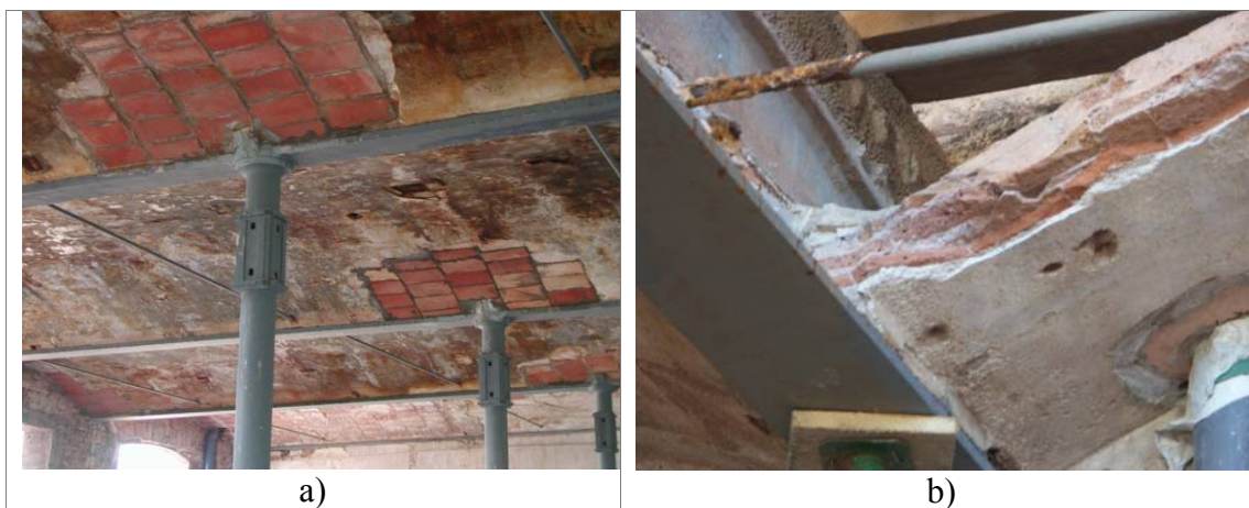
Figura 196 – Ca l'Aranyò, Poblenou, Barcellona, progetto di conservazione di A. Vilanova e E. Simó. Dettagli della struttura della volta catalana e dell'impostazione delle mattonelle di laterizio sulla base inferiore della trave metallica (immagine tratta dalla presentazione di A. Vilanova e E. Simó Il recupero del complesso industriale di Cà l'Aranyò per la Università Pompeu Fabra ).
