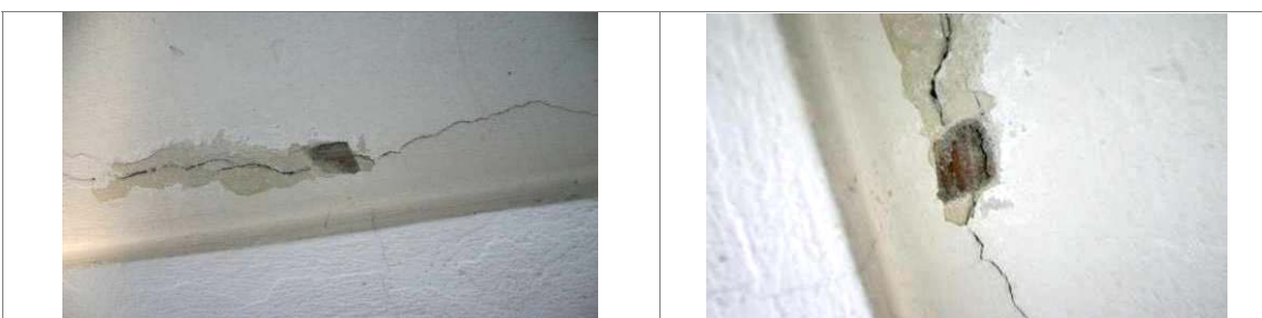
Figura 324 – Quinto saggio e particolari della lesione S5.
