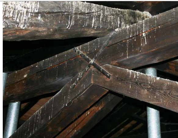
Figura 56 – Particolari degli incastrì degli elementi lignei della capriata C4
