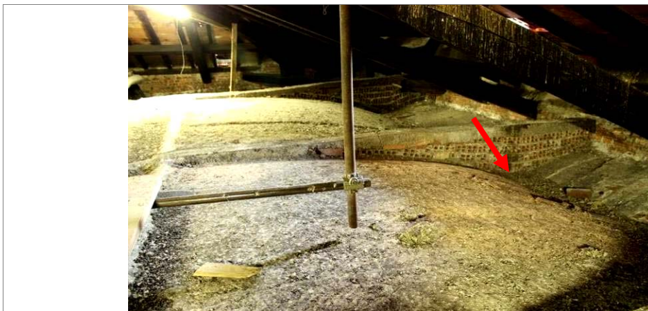
Figura 73 - Frenelli all'estradosso della volta, lato nord.
