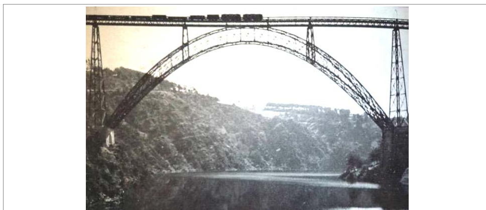
Figura 83 - Ponte ferroviario del Garabit, G. Eiffel, 1880-84 (da JODICE, ROISECCO, VANNELLI, L'architettura del ferro, la Francia (1715-1914) , Roma, 1973, p. 340).
