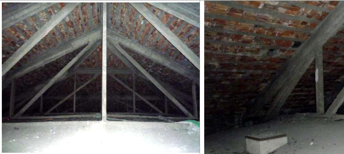
Figura 24 – Edificio 8. Capriate in calcestruzzo armato a sostegno della copertura.
