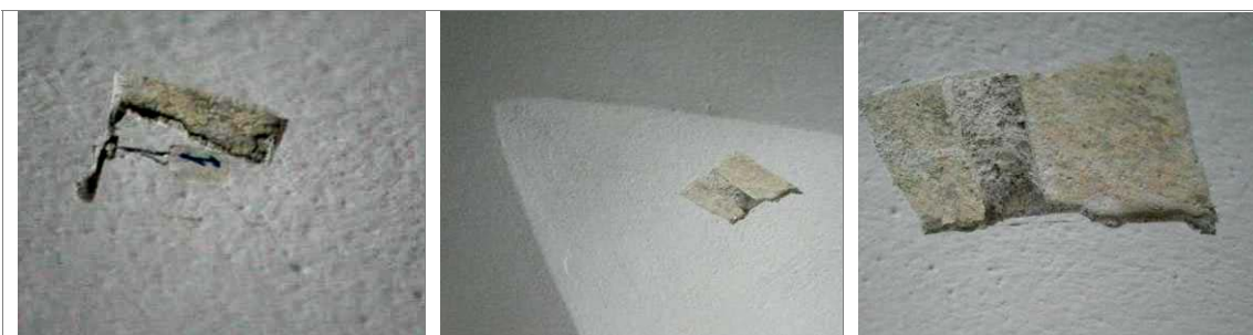
Figura 320 – Primo tassello stratigrafico terminato con individuazione dei vari strati S1.
