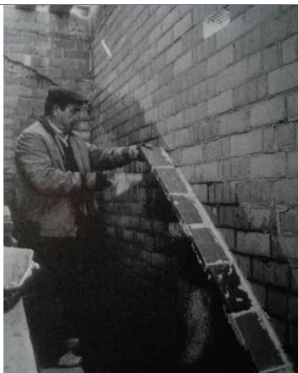
Figura 161 – Esecuzione della prima fila di rasillas (da GONZALEZ MORENO NAVARRO, La bòveda tabicada: pasado y futuro de un elemento de gran valor patrimonial , in TRUÑO, Construcción de bòvedas tabicadas , Madrid, 2004).
