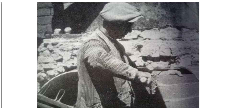
Figura 163 – Posizionamento della rasilla (da TRUÑO, Construcción de bòvedas tabicadas , Madrid, 2004, p. 18).
