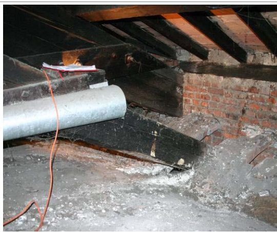
Figura 56 – Particolari degli incastrì degli elementi lignei della capriata C4
