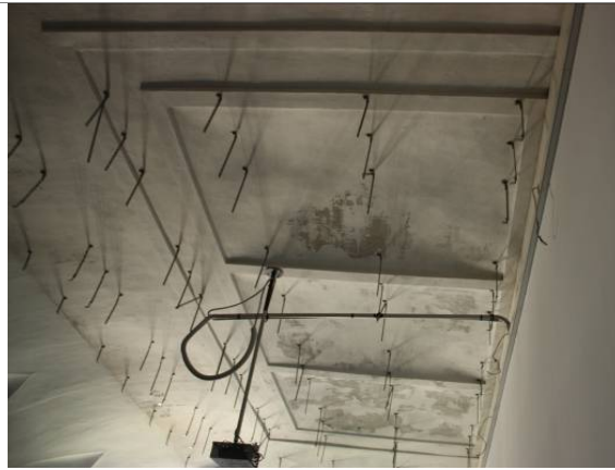
Figura 67 –Intradosso della volta, porzione del graticcio metallico in corrispondenza della specchiatura centrale. Aula S 1.1.
