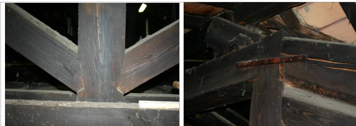
Figura 17 – Edificio 2_a1. Capriate lignee a sostegno della copertura.
