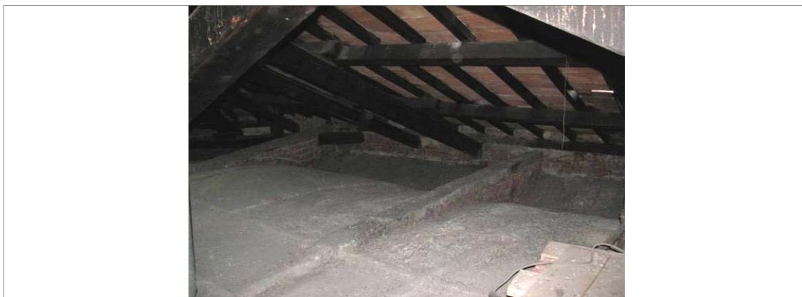
Figura 290 – Estradosso della volta coperta da uno strato d'intonaco.
