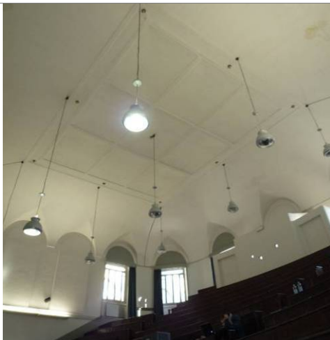
Figura 11 – Intradosso della volta dell'aula principale, edificio 2_a1.
