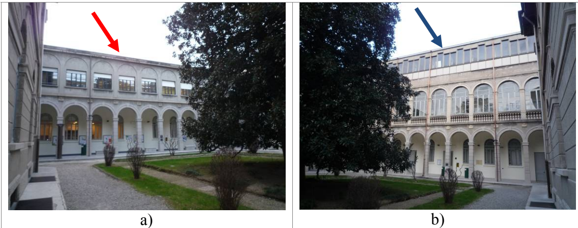
Figura 267 – Politecnico di Milano, Edificio 3, interno della corte. a) corpo a ovest, b) corpo a est.
