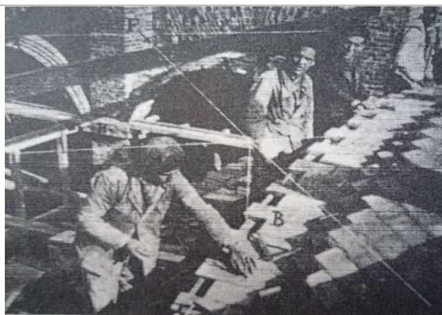
Figura 168 – Costruzione di una volta del Museo de America di Luis Moya Blanco (da GULLI, MOCHI, Bóvedas tabicadas: architettura e costruzione , Roma, 1995, p. ).
