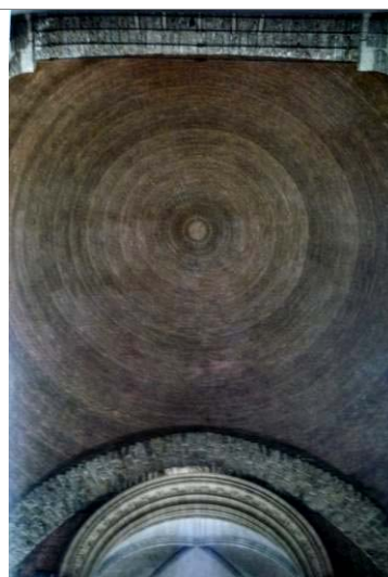
Figura 160 - St. John the Divine, Manhattan, dettaglio della cupola (da OCHSENDORF, Guastavino Vaulting: The Art of Structural Tile , USA, 2010, p. 125).
