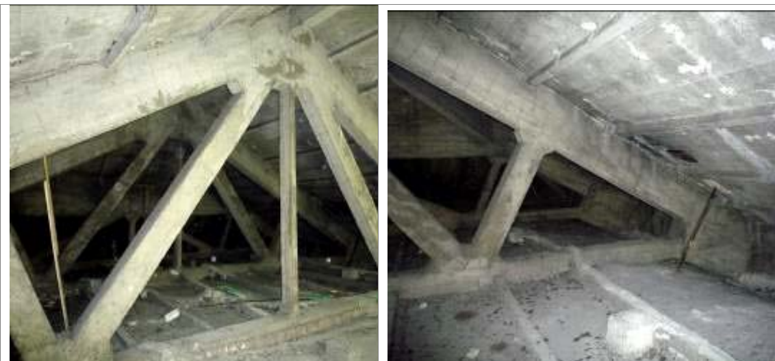
Figura 25 – Edificio 9. Capriate in calcestruzzo armato a sostegno della copertura.
