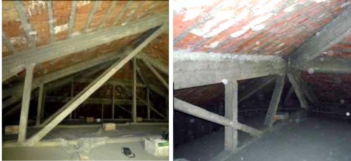
Figura 22 – Edificio 4. Capriate in calcestruzzo armato a sostegno della copertura.
