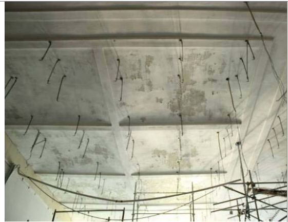
Figura 68 –Intradosso della volta, porzione del graticcio metallico in corrispondenza della specchiatura centrale. Aula S 1.8.
