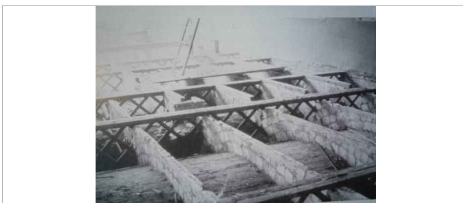
Figura 170 – Sistema di irrigidimento della volta (da da GONZALEZ MORENO NAVARRO, La bòveda tabicada: pasado y futuro de un elemento de gran valor patrimonial , in TRUÑO, Construcción de bòvedas tabicadas , Madrid, 2004).
