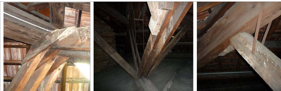
Figura 32 –Edificio 4. Capriate in legno a sostegno della copertura.
