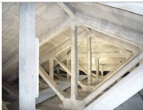
Figura 16 – Sottotetto in corrispondenza dell'estradosso della volta dell'aula principale, edificio 6_a1.
