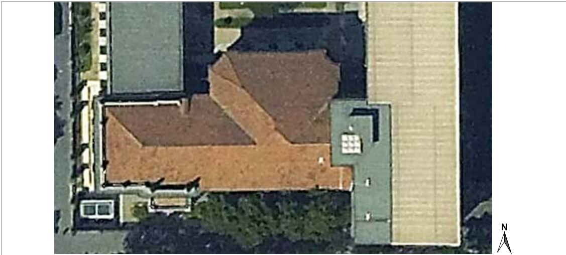
Figura 60 – Politecnico di Milano – Edificio 3_a1 - Vista dall'alto (da Google Maps, http://maps.google.it ).
