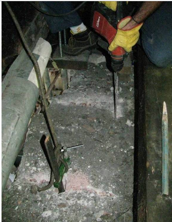
Figura 328 – Estrazione campione di muratura.
