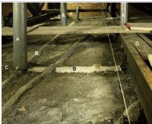
Figura 280 - Elementi di connessione(A) tra gli elementi metallici della parte centrale della volta(B,C) e le capriate lignee. E' visibile una catena lignea della capriata (D).
