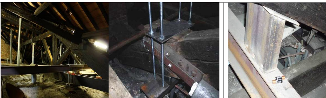
Figura 42 – Intervento di messa in sicurezza delle capriate C3 e C4
