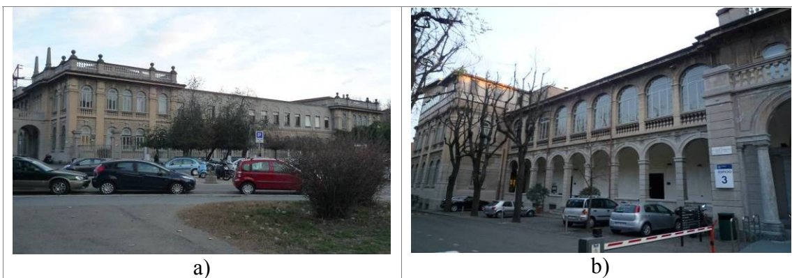
Figura 6 – Politecnico di Milano, Edificio 3. a) vista est, b) vista nord
