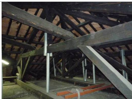
Figura 15 – Sottotetto in corrispondenza dell'estradosso della volta dell'aula principale, edificio 2_a1.
