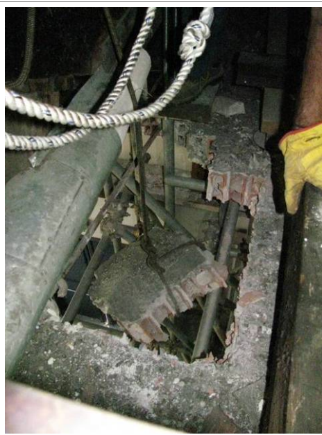
Figura 330 – Estrazione del campione di muratura.
