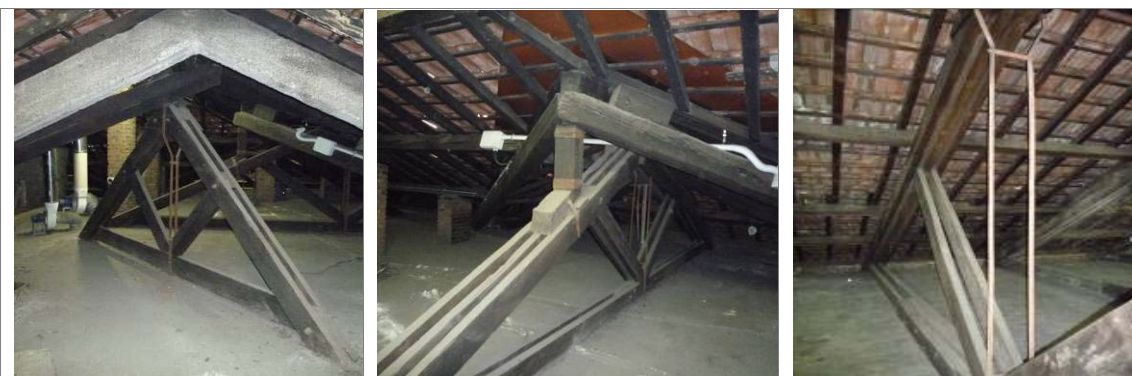
Figura 35 –Edificio 8. Capriate in legno a sostegno della copertura.
