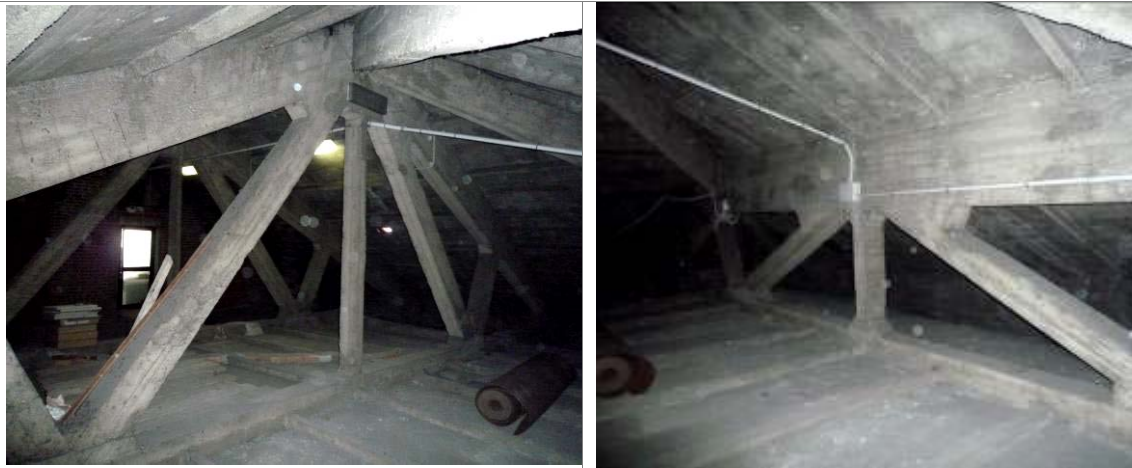
Figura 23 – Edificio 5. Capriate in calcestruzzo armato a sostegno della copertura.
