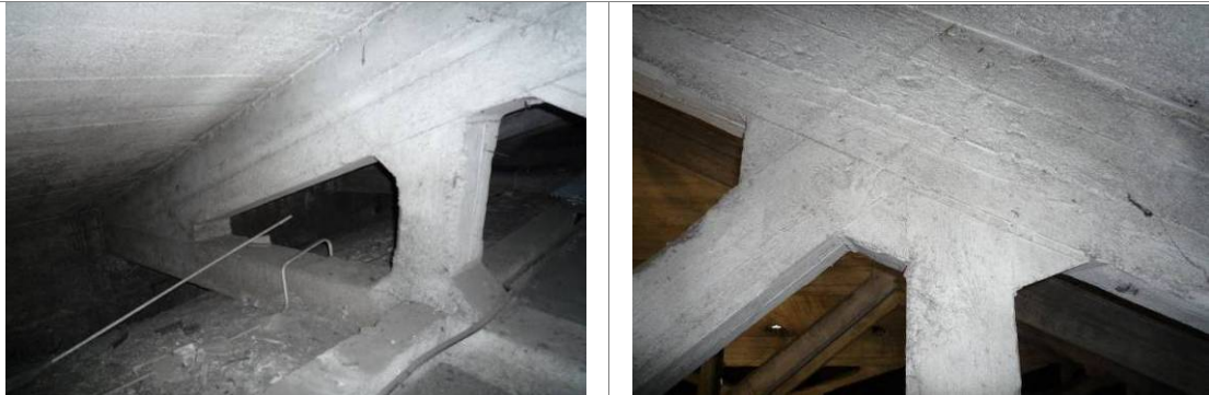
Figura 20 – Edificio 6_a1. Capriate in calcestruzzo armato a sostegno della copertura.
