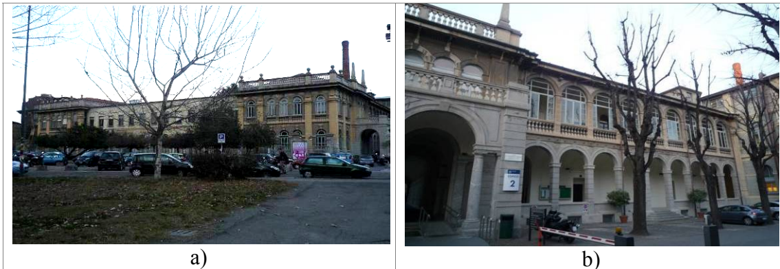
Figura 4 – Politecnico di Milano, Edificio 2. a) vista est, b) vista sud
