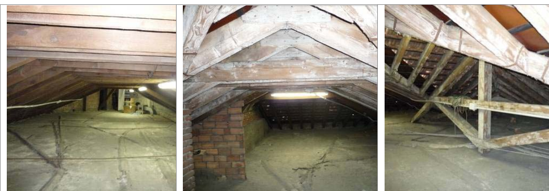
Figura 33 –Edificio 5. Capriate in legno a sostegno della copertura.
