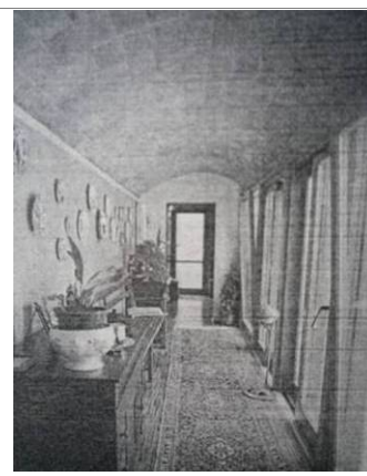
Figura 173 – Costruzione di una volta a tre strati con 2 m di luce. R. Gulli, G. Mochi, T. Piemontese, Fano, 1993 a) Fase di realizzazione dell'estradosso della volta; b) Interno del locale, intradosso della volta (da Bòvedas tabicadas : architettura e costruzione , GULLI, MOCHI, Roma, 1995, p. 268).
