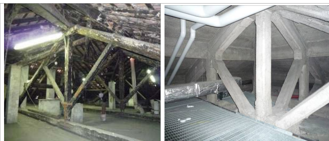
Figura 26 –Edificio 6. Capriate in legno a sostegno della copertura.
