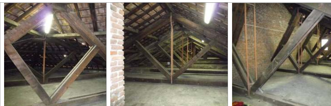
Figura 31 –Edificio 4. Capriate in legno a sostegno della copertura.
