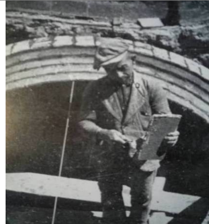
Figura 165 – La spalmatura della pasta di gesso sullo spessore della rasilla (da TRUÑO, Construcción de bóvedas tabicadas , Madrid, 2004, p. 17)
