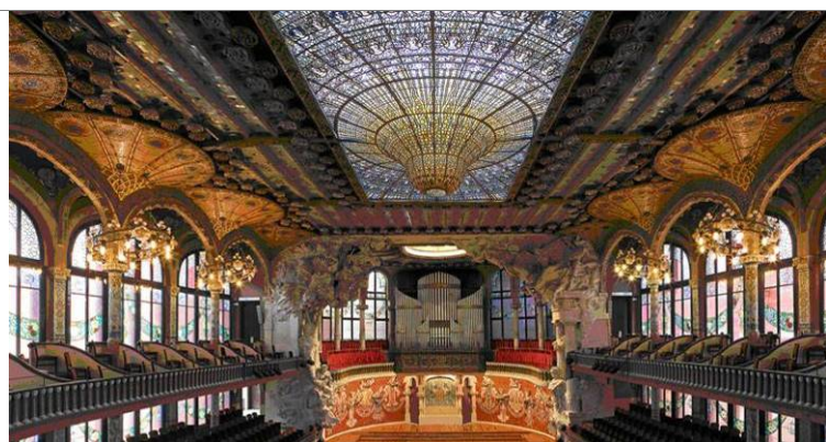
Figura 177 - Palau de la música catalana , Barcellona, Domènech y Montaner, 1905-08. Solaio realizzato con voltine tabicade impostate su una griglia di putrelle in acciaio (da http://www.palaumusica.org/ , sito ufficiale del Palau de la música catalana di Barcellona).
