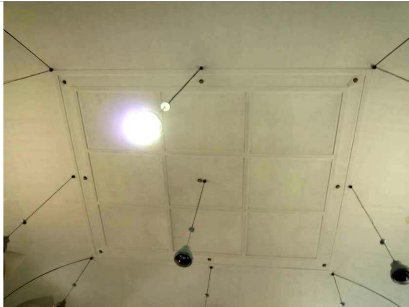
Figura 65 – Grande aula dell’edificio 3_a2, suddivisa da un tramezzo, lato ad ovest, Aula S 1.8.
