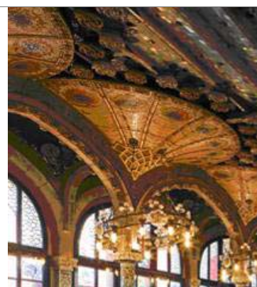
Figura 177 - Palau de la música catalana , Barcellona, Domènech y Montaner, 1905-08. Solaio realizzato con voltine tabicade impostate su una griglia di putrelle in acciaio (da http://www.palaumusica.org/ , sito ufficiale del Palau de la música catalana di Barcellona).
