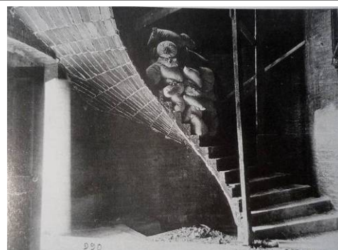
Figura 158 – Prova di carico su una scala realizzata con tecnica laminare stratificata (da OCHSENDORF, Guastavino Vaulting: The Art of Structural Tile , USA, 2010, p. 153).
