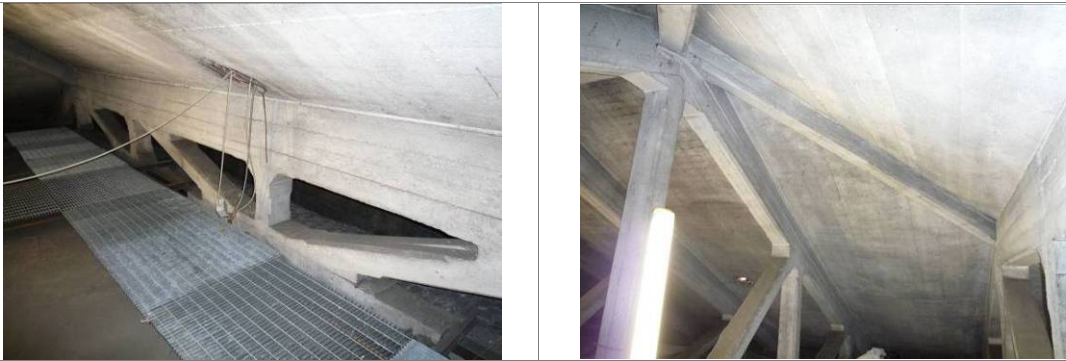
Figura 19 – Edificio 6_a1. Capriate in calcestruzzo armato a sostegno della copertura.
