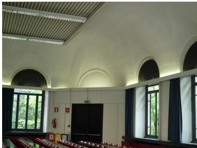
Figura 66 – Particolare della presenza del controsoffitto in corrispondenza della parte centrale dell’intradosso della volta in una delle aula principali.
