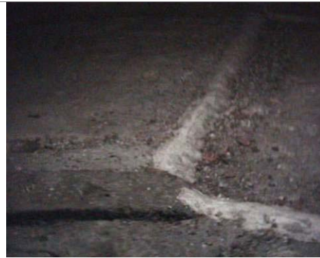
Figura 305 – visibile corrispondente al termogramma 14.
