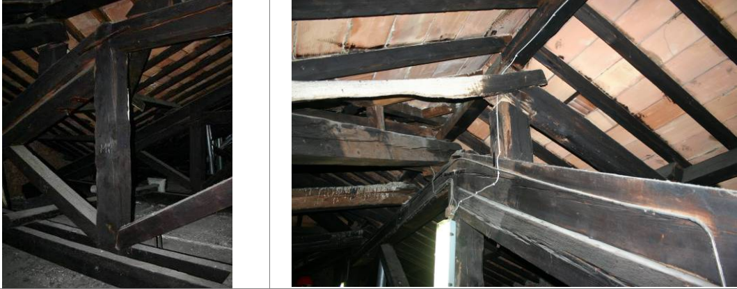
Figura 18 – Edificio 2_a1. Capriate lignee a sostegno della copertura.
