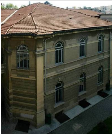
Figura 13 – Edificio 2_a1, corpo della grande aula.
