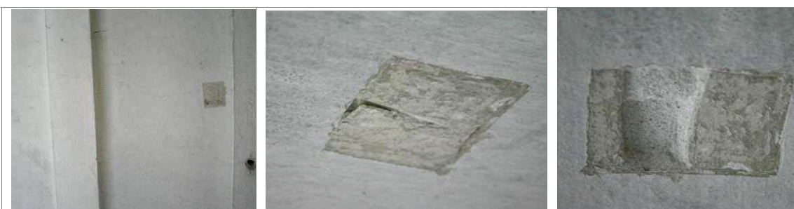
Figura 322 – Terzo tassello stratigrafico terminato con l'individuazione dei 3 strati S3.
