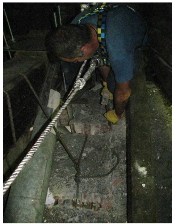
Figura 329 – Messa in sicurezza del campione di muratura.
