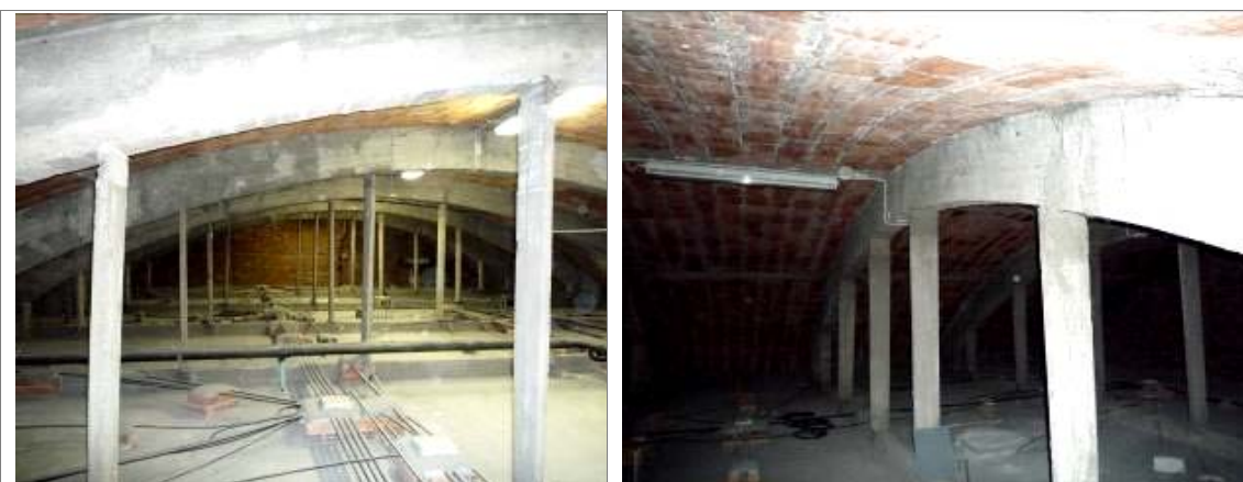
Figura 29 – Edificio 9. Archi in calcestruzzo armato a sostegno della copertura.
