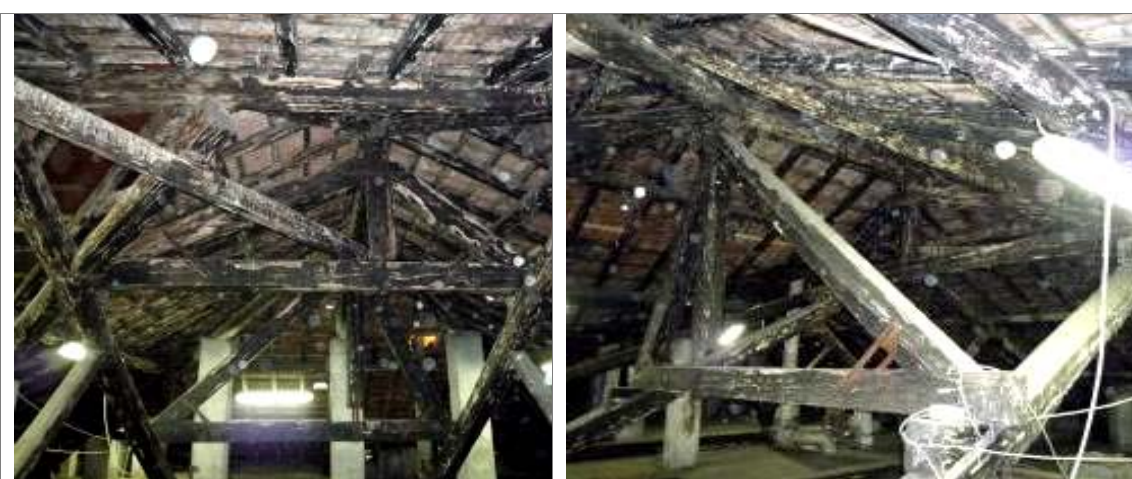
Figura 28 –Edificio 6. Capriate in legno a sostegno della copertura.
