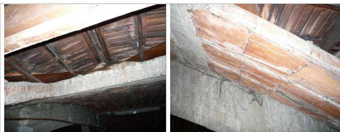
Figura 30 – Edificio 9. Archi in calcestruzzo armato a sostegno della copertura.
