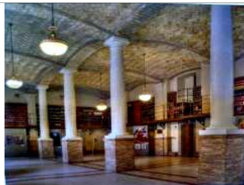
Figura 150 - Biblioteca pubblica di Boston (da OCHSENDORF, Guastavino Vaulting: The Art of Structural Tile , USA, 2010, p. 51).
