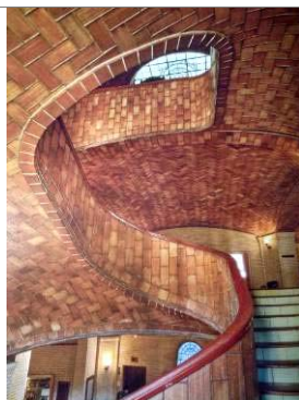
Figura 157 – St. Paul's Chapel , scala realizzata con tecnica laminare stratificata (da OCHSENDORF, Guastavino Vaulting: The Art of Structural Tile , USA, 2010, p. 200).
