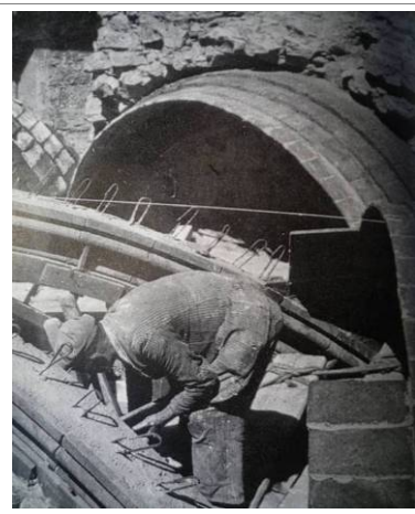
Figura 167 – Costruzione di una bóveda tabicada a più strati (da TRUÑO, Construcción de bóvedas tabicadas , Madrid, 2004, p. 14).
