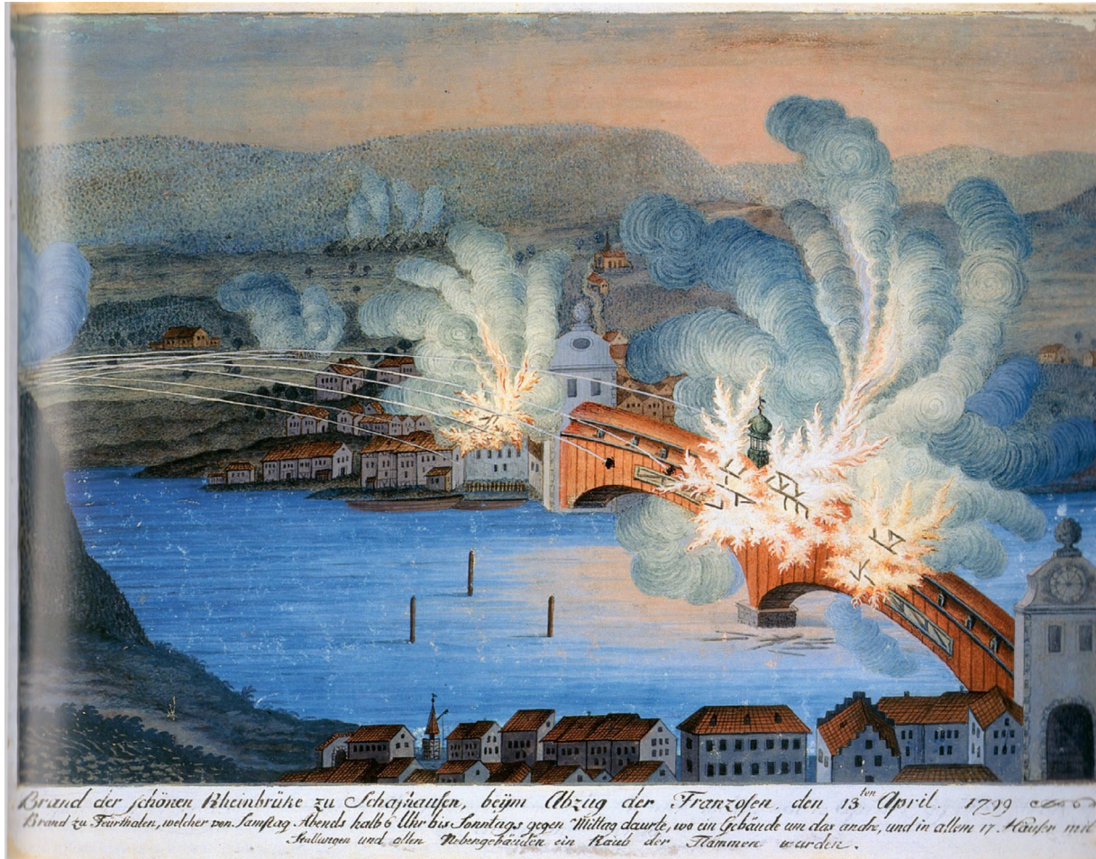
Figura 39. Distruzione del ponte di Schaffhausen ad opera delle truppe francesi nel 1799.
