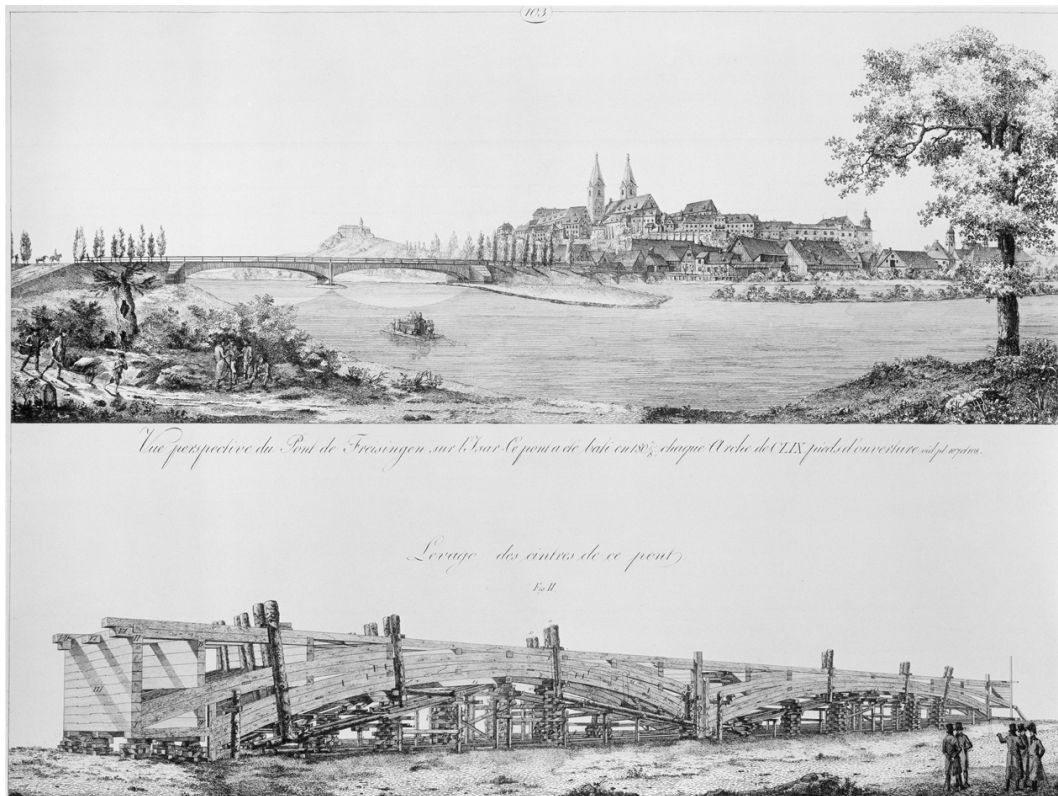
Figura 49. Ponte di Freysing.
