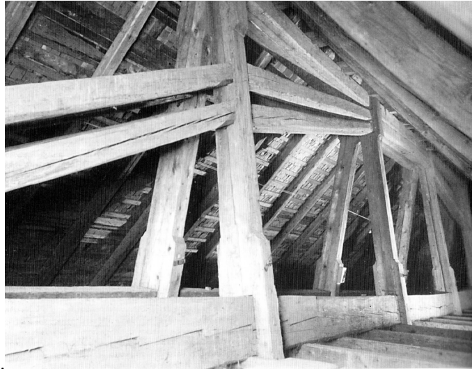
Figura 32. Struttura di copertura della chiesa di Grub.
