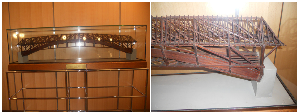
Figura 40. Modello originale del ponte di Wettingen. Figura 41. Particolare dell'imposta dell'arco.
