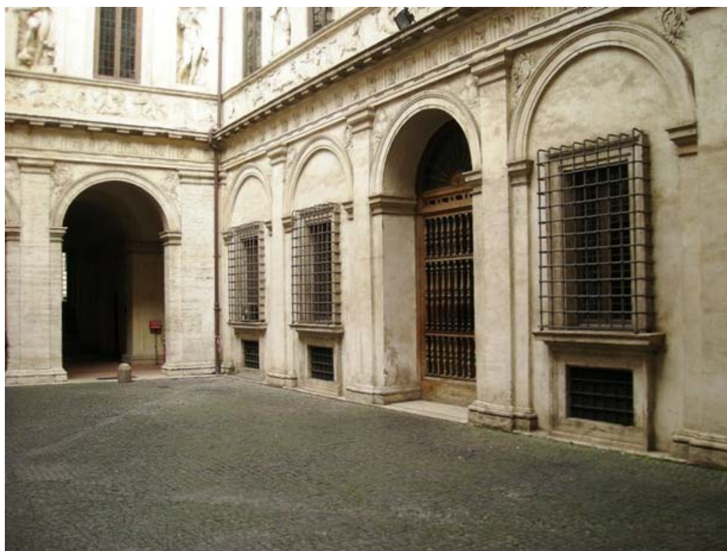
Fig.3.6, Palazzo Spada, cortile.
