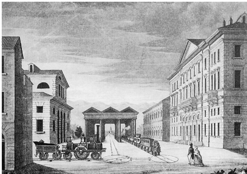
Fig. 4.14, Veduta della strada ferrata da Milano a Monza, L. Mantovani, 1850 ca.
