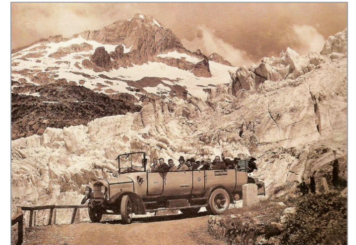
Corriera panoramica sulla strada del Passo Furka (CH, Vallese) nel 1923 (Bachmann, 1980, pag. 231)
