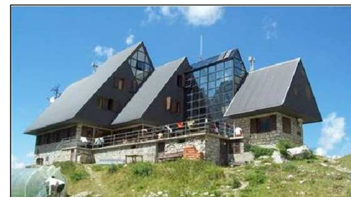
Il prospetto Sud del Rifugio Garelli (googleimages.com)
