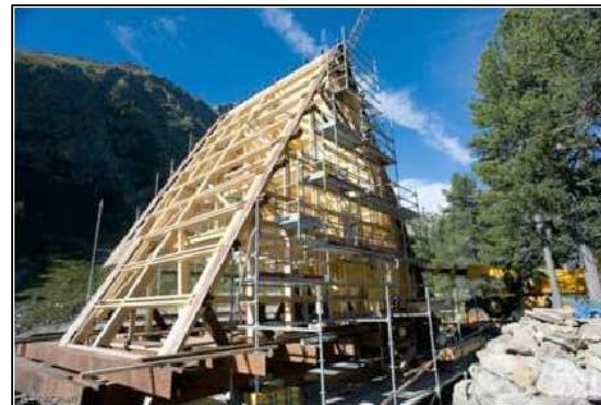
Il rifugio in costruzione (ArchAlp, Ottobre 2010)
