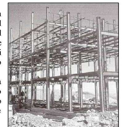
La struttura in acciaio dell'albergo rifugio Pirovano (Bolzoni, 2001, pag. 55)
