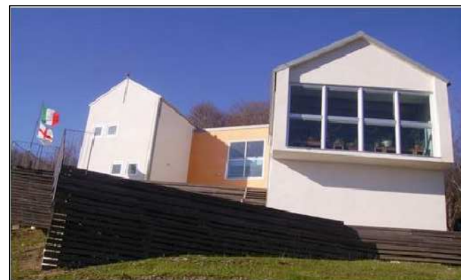
Vista del prospetto Sud del Rifugio Antola (googleimages.com)
