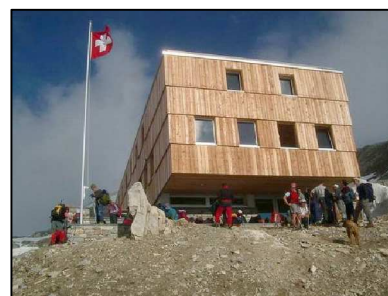
Il fronte principale della Capanna Cristallina (www. capannacristallina.ch)
