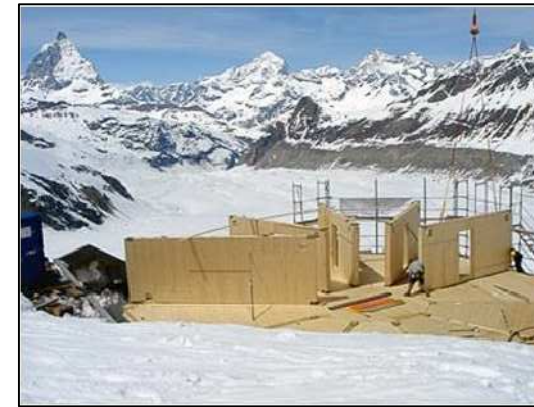
Fasi di montaggio delle pareti prefabbricate (www.neuemonterasahuette.ch)
