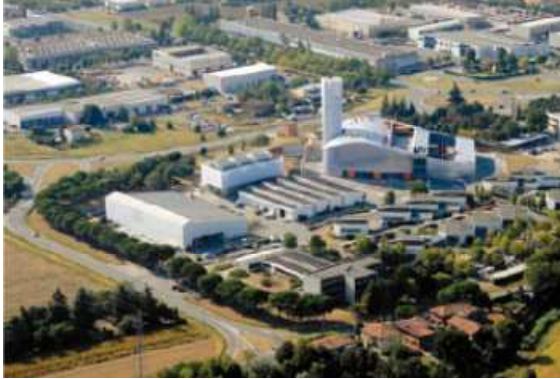
Figura 4.68: Centrale di cogenerazione di Imola (vista aerea)
