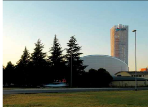
Figura 4.69: Centrale di cogenerazione di Imola (esterno)
