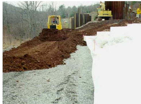
Figura 4.7: Rivestimento in terra
