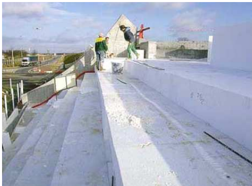
Figura 4.6: Montaggio dei blocchi
