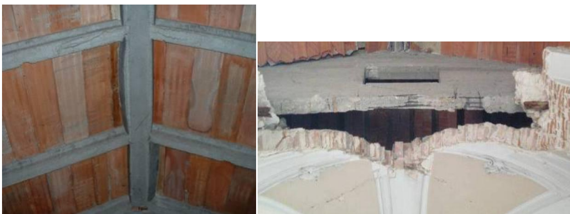
Figura 3-5 Interventi sulla copertura della chiesa di San Marco
