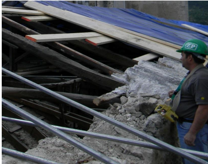
Figura 5-2 Copertura di San Biagio
