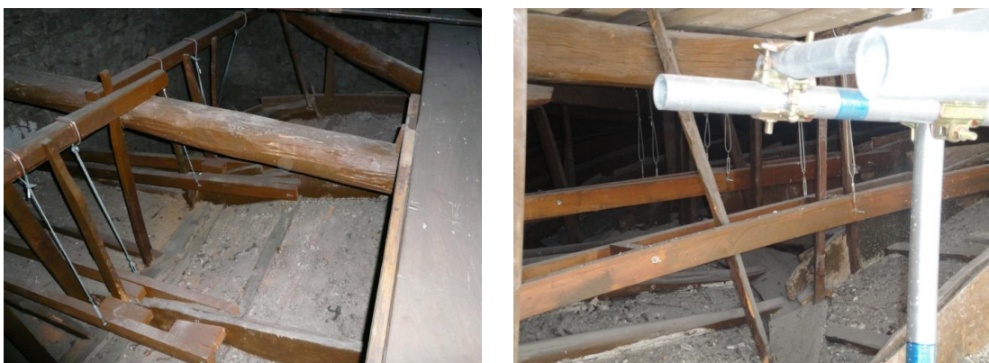
Figura 4-17 Dettaglio dei collegamenti della volta
