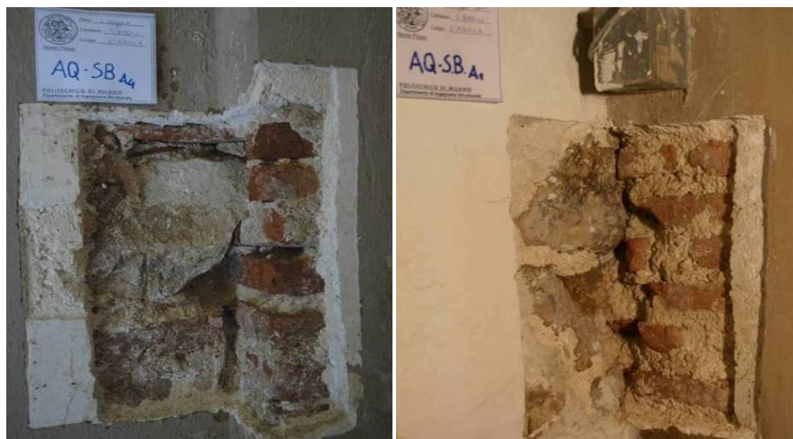
Figura 2-3 Prove eseguite sulla muratura
