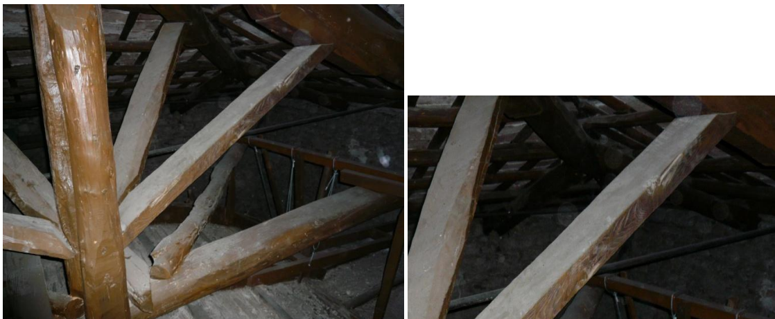
Figura 4-11 Particolari della testa di padiglione
