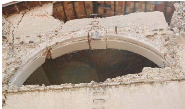
Figura 3-7 Interventi sulla copertura della chiesa S.S. Nicandro e Marciano
