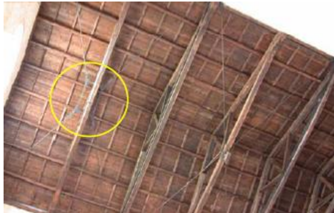
Figura 3-8 Copertura della chiesa di Santa Maria di Collemaggio
