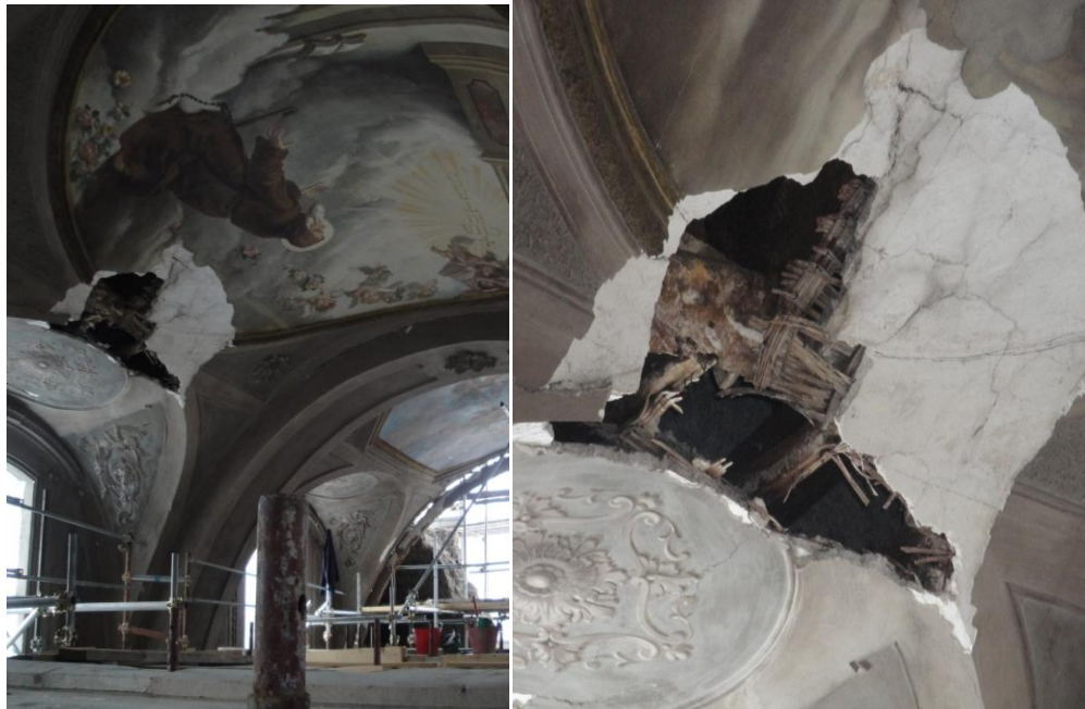
Figura 2-6 Crollo della volta in cannicciato
