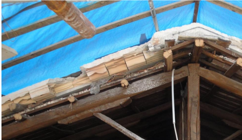
Figura 6-3 Copertura dopo gli interventi
