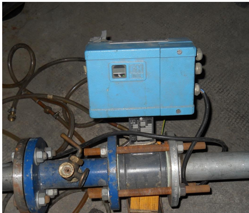
Figura 2.2 Misuratore magnetico di portata.
