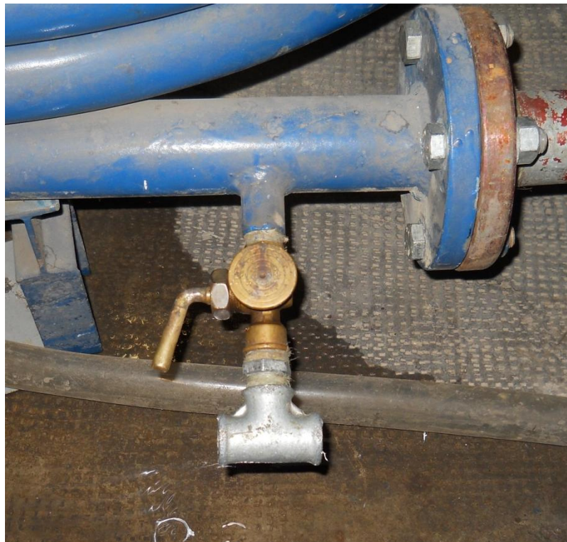
Figura 4.13 Raccordo in ferro a forma di T che permette di avvitare i due sensori contemporaneamente.
