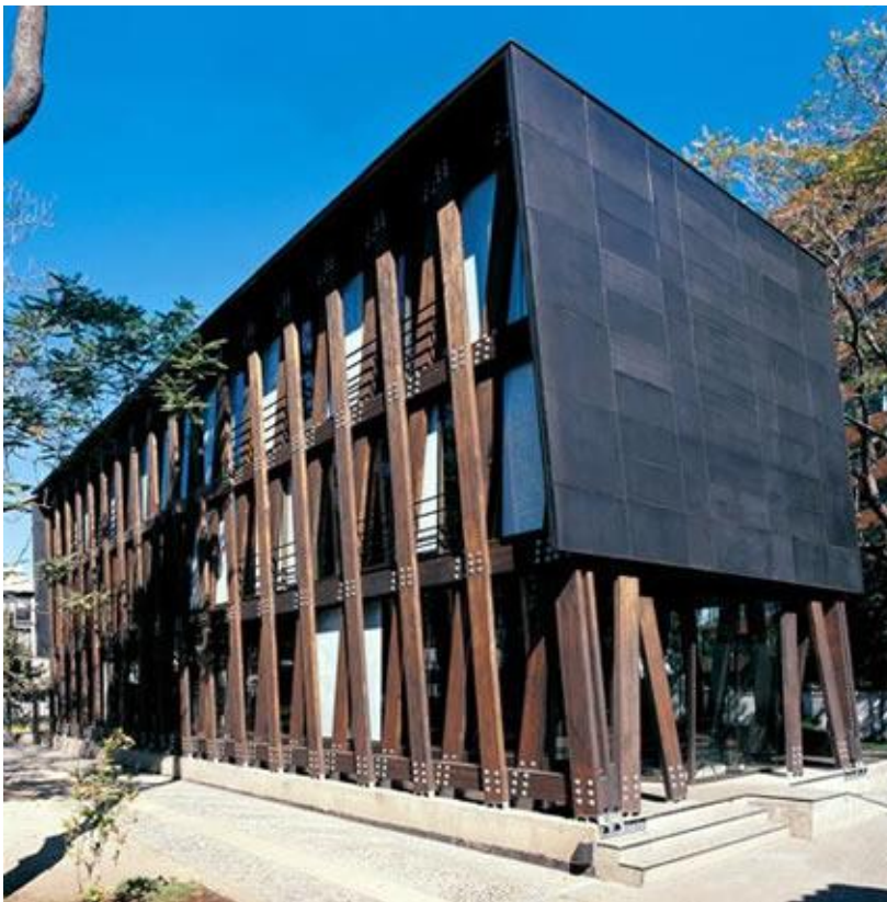
Figura 1 – Edificio di 3 piani a Santiago del Cile in legno lamellare [1]
