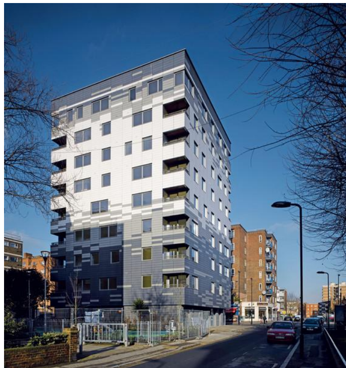
Figura 9 – Edificio di 9 piani con struttura portante in XLAM, Shoreditch, Londra [5]
