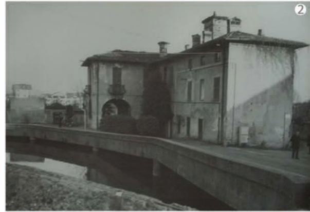
Casa del custode delle acque a Vaprio d'Adda
