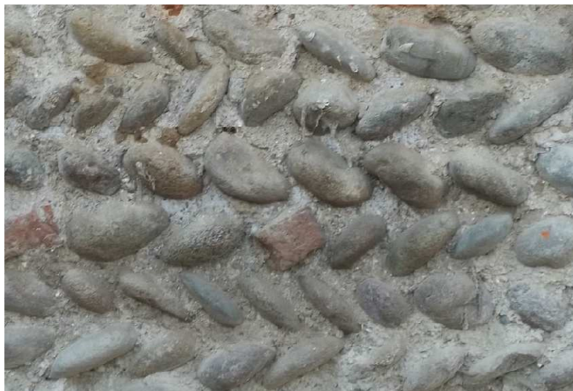
Figura 33: esempio di muratura in pietra naturale
