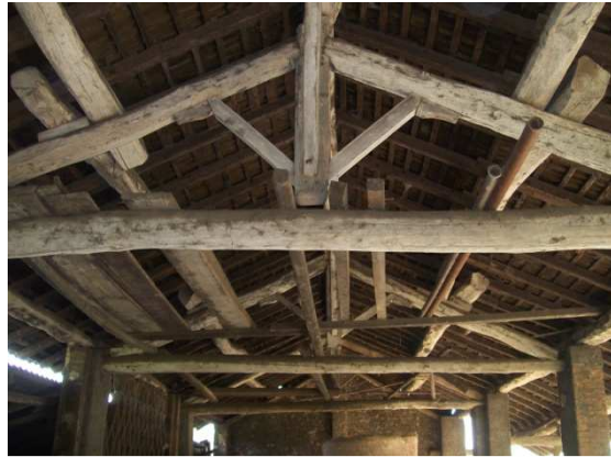
Figura 36: capriata e copertura lignea
