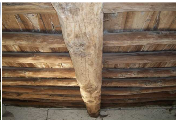
Figura 121: solaio ligneo
