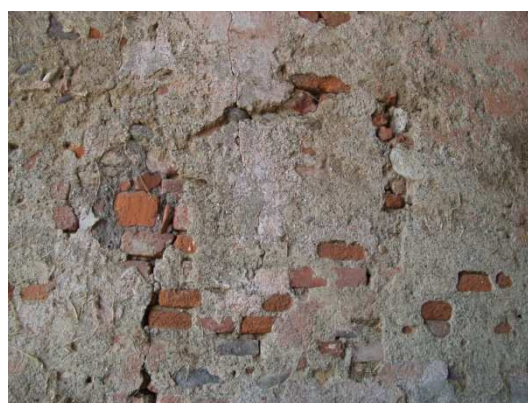
Figura 122: paramento murario degradato
