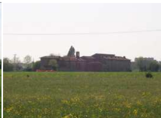
Figura 168: il fronte Nord del complesso
