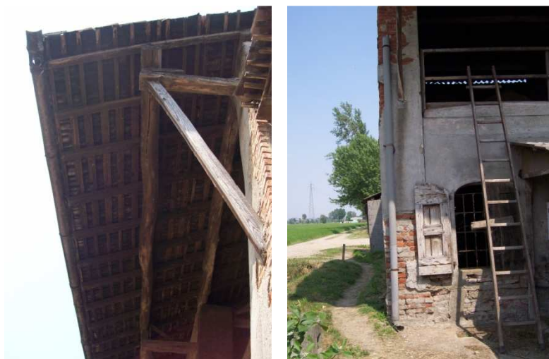
Figura 114: l'edificio delle stalle
