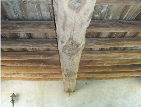
Figura 35: solaio ligneo
