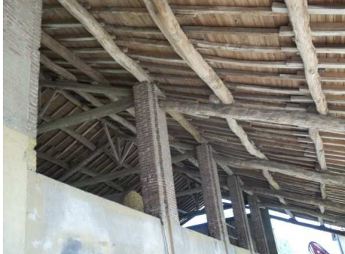
Figura 149: muratura in laterizio
