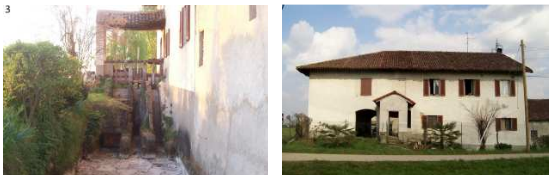
Figura 111: l'edificio del molino
