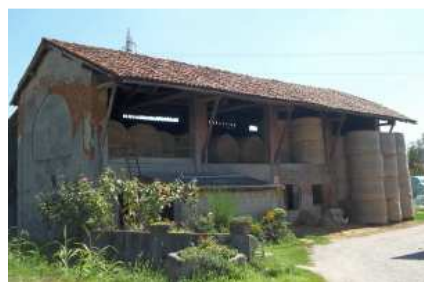
Figura 110: l'edificio delle stalle
