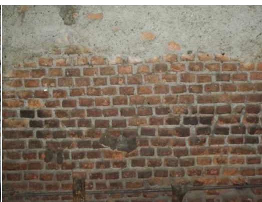
Figura 113: paramento murario in laterizio
