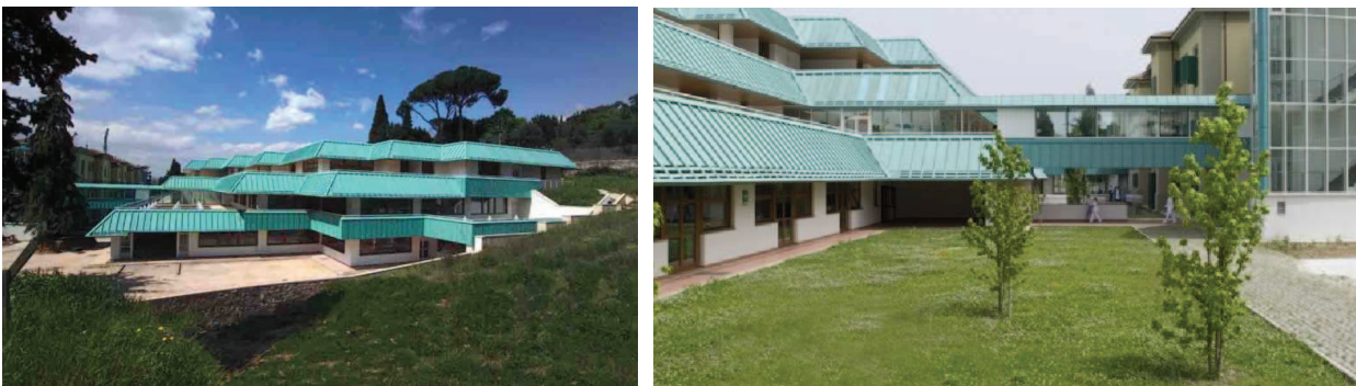
Figura 7. Viste copertura ospedale Meyer
