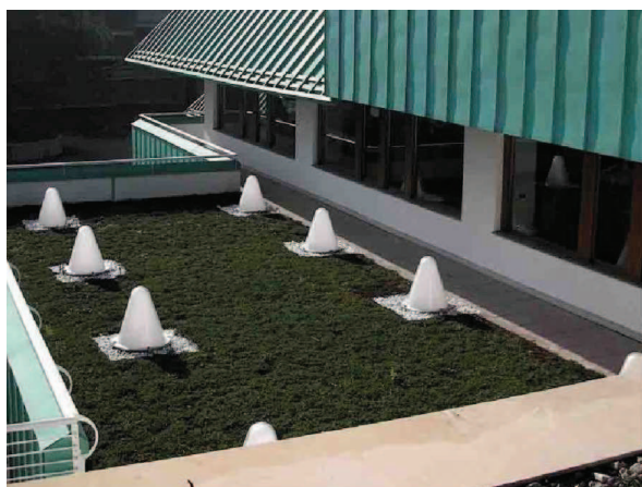
Figura 9. Lucernari in copertura
