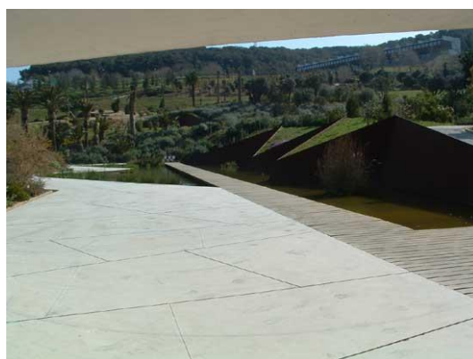
Figura 175 - Dettaglio della pavimentazione
