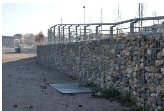
Figura 232 - Elemento di arredo urbano in gabion wall nel nuovo quartiere di espansione "Spina 3" a Torino
