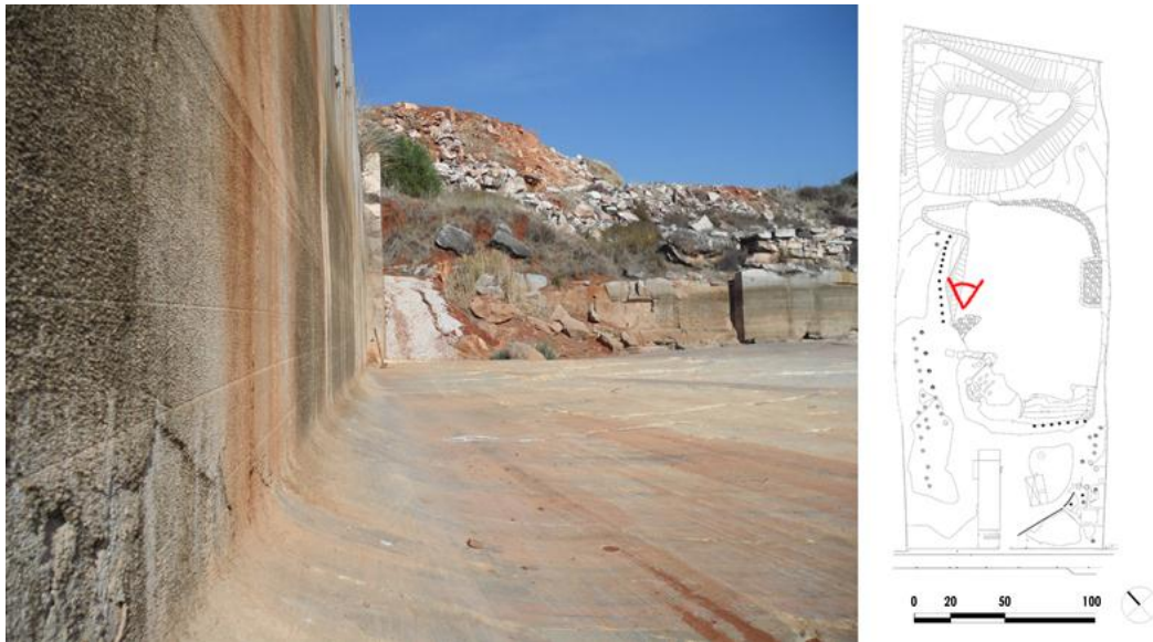
Figura 68 - Interno del lotto: particolare della balza
