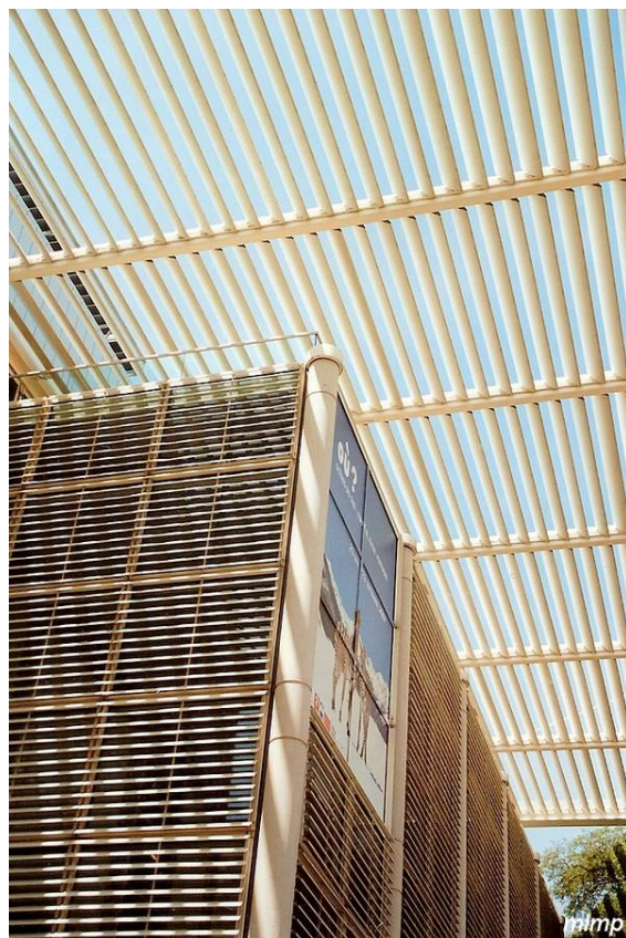
Figura 192 - Particolare delle schermature solari
