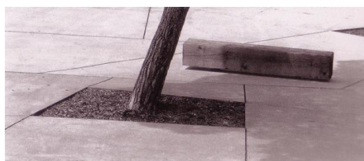
Figura 179 - Dettaglio della pavimentazione
