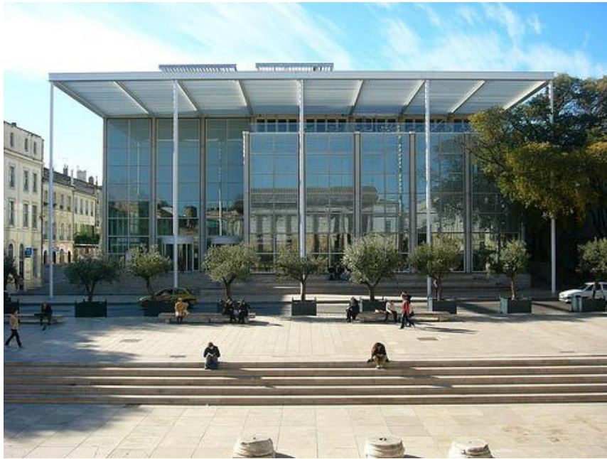
Figura 188 - Fronte principale: vista frontale
