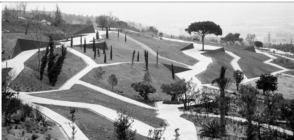
Figura 174 - Vista complessiva dell'intervento
