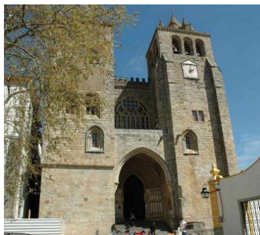
Figura 3 - Duomo di Evora, facciata
