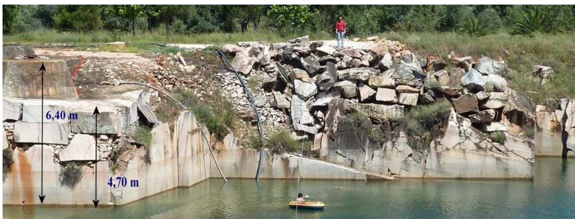
Figura 45 - Livello dell'acqua nella cava
