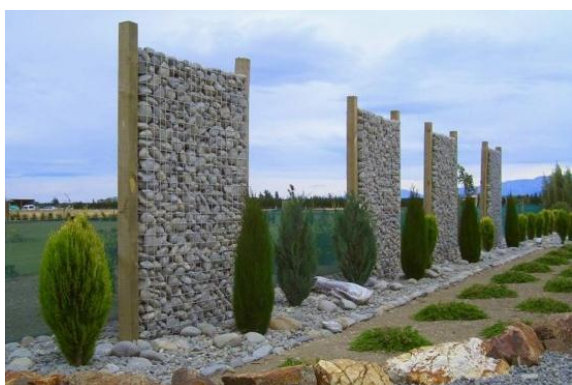
Figura 231 - Elemento di arredo urbano in gabion wall
