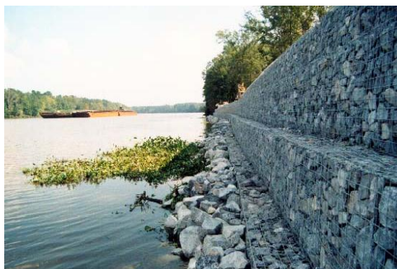
Figura 228 - Gabion wall in prossimità del letto di un fiume
