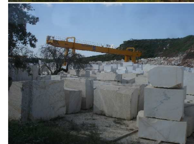
Una zona di stoccaggio dei blocchi di marmo in un sito estrattivo. Sullo sfondo l'imponente gru a ponte per la movimentazione dei blocchi.
