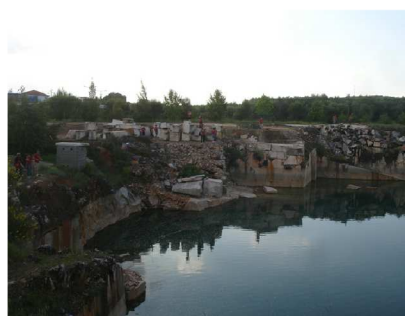
7. Vista laterale della cava e dei livelli delle balze di marmo
