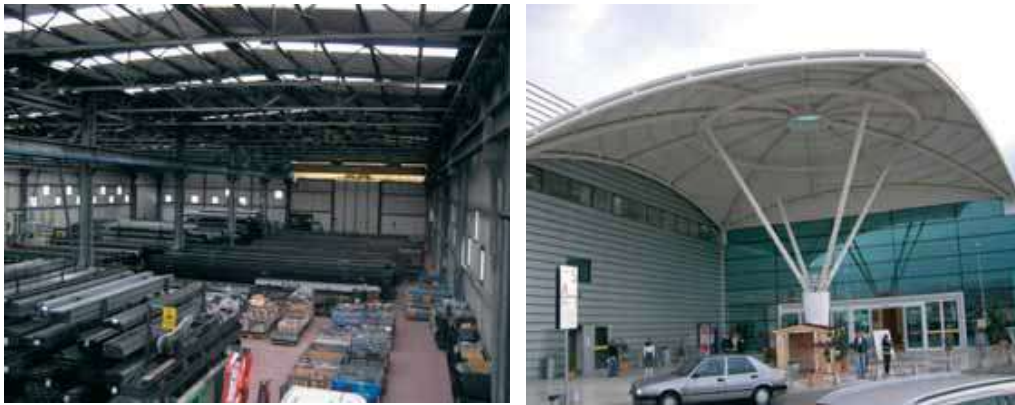
Fig.11.12 Edifici in acciaio dopo il sisma, L'Aquila
