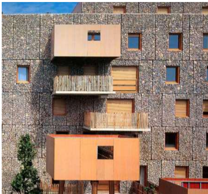
Fig.8.1 Alloggi popolari a Montpellier di Edouard Francois & Associés. Dall'alto, vista parziale della facciata e schemi delle fasi di esecuzione dei gabbioni
