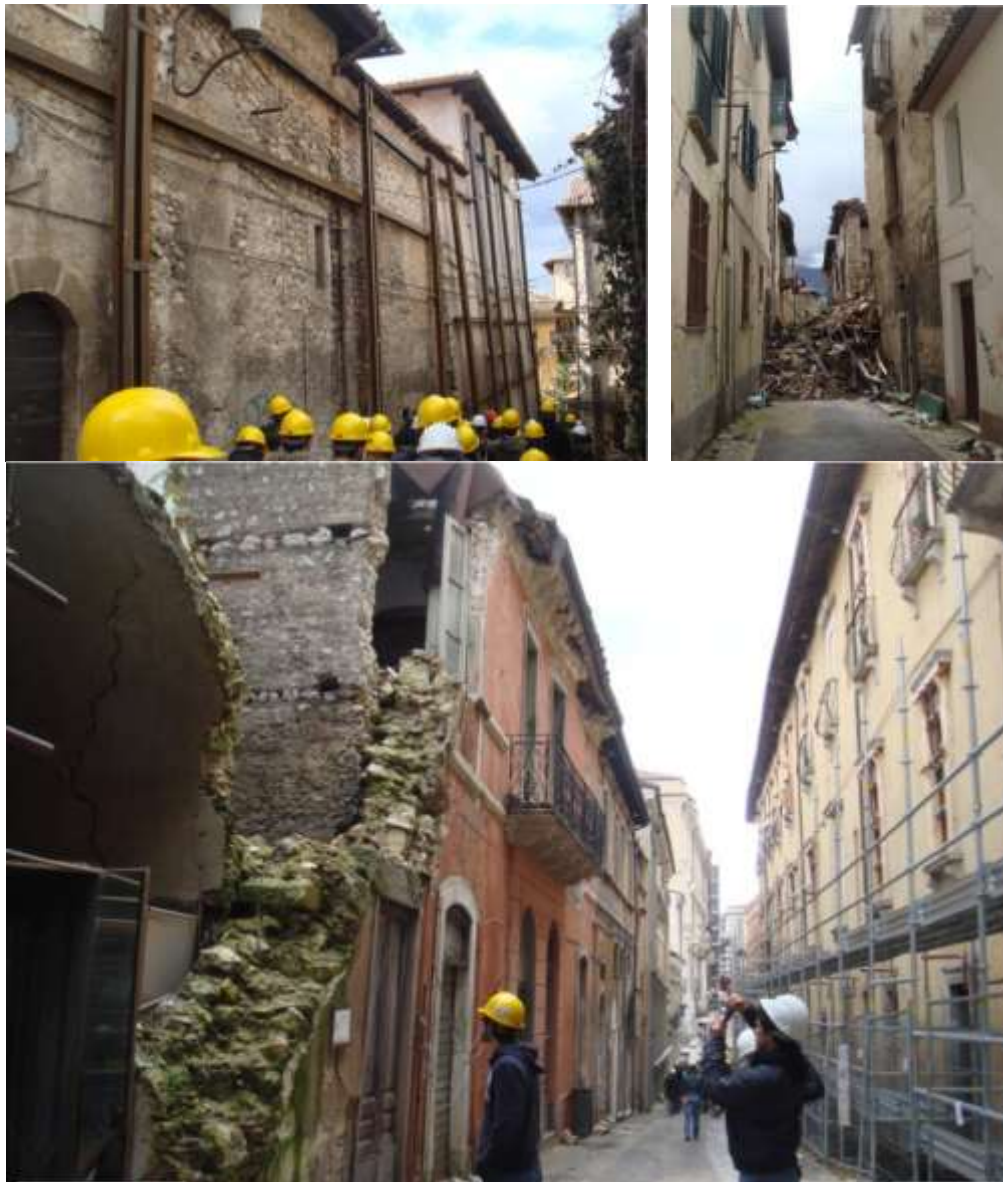
Fig.11.11 Report fotografico realizzato durante il sopralluogo promosso dal Politecnico di Milano, 1 Marzo 2010, Zona rossa, L'Aquila
