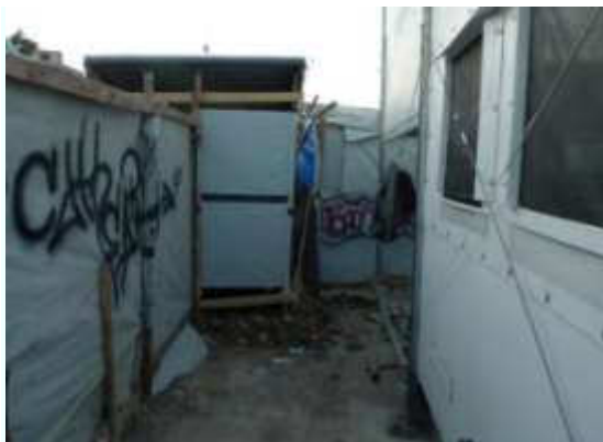
[Fig.4.2.7.5] Recinto e pavimentazione in cemento
