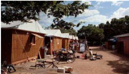
[Fig.1.2.1] Shigeru Ban, Paper Log House, Kobe - Giappone, 1994/ Kaynasli - Turchia, 2000/ Bhuj - India, 2001
