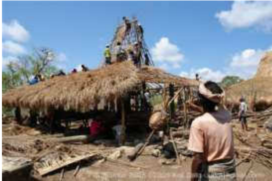
[Fig.6.4.2.18] Costruzione di un tetto Sumba
