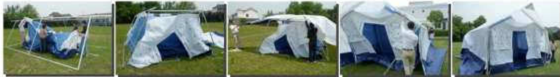
[Fig.4.2.6.2] Le fasi di montaggio della TS-200
